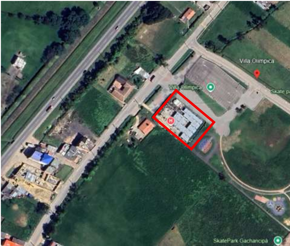
Figura 1.1. [Predio actual – Hospital Gachancipá.]
