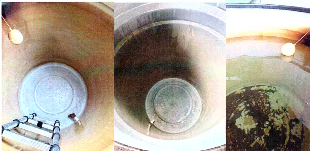
Resultado del lavado y desinfección de tanques aéreos de 1.000 litros. Se evidencia limpieza completa de paredes internas y fondo, tanques en condiciones sanitarias óptimas.
