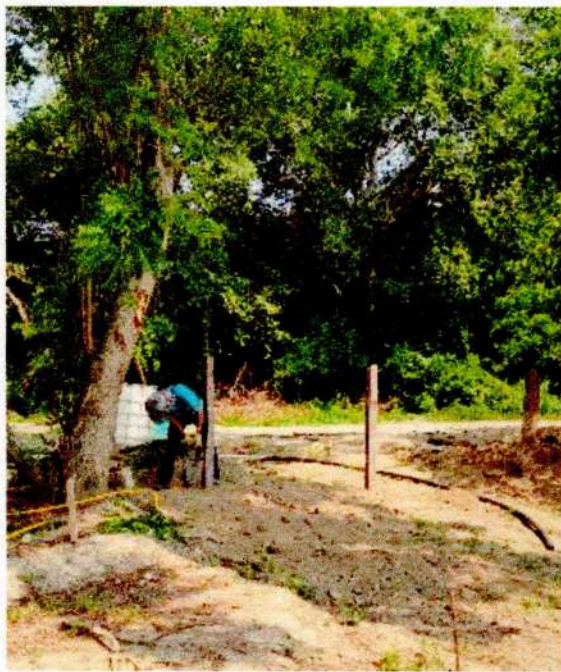
FOTOGRAFIA 7. RECUPERACION DE CERRAMIENTO
