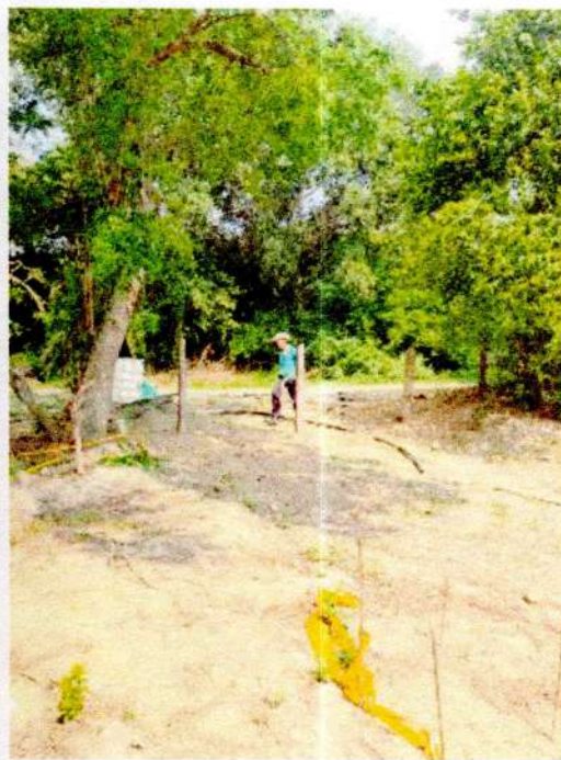
FOTOGRAFIA 8. RECUPERACION DE CERRAMIENTO
