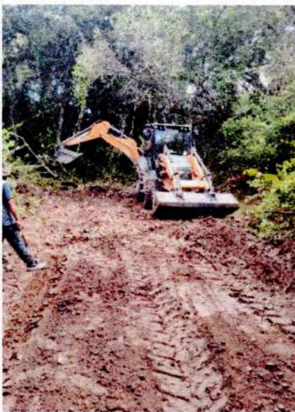
FOTOGRAFIA 4. MANTENIMIENTO DE VIA
