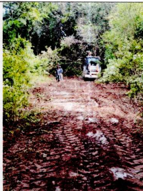
FOTOGRAFIA 5. MANTENIMIENTO DE VIA
