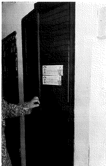
Estado puertas antes
