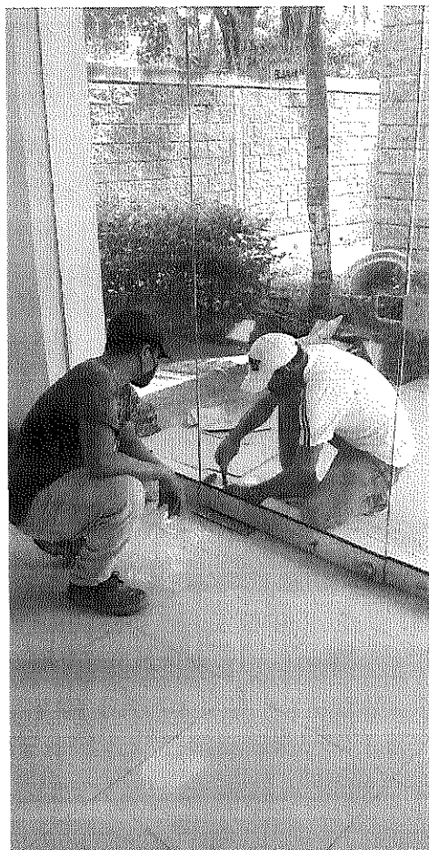
Mantenimiento de puertas de vidrio GANCA
