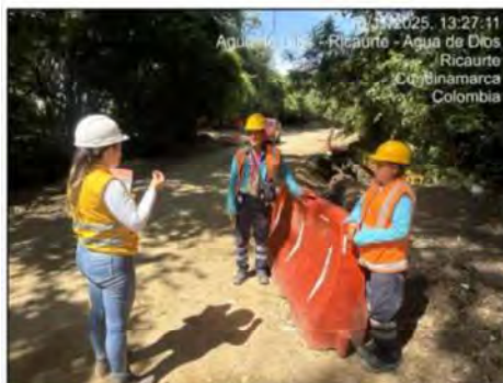
Fotografía 3. Capacitación limpieza final de obra y desmantelamiento en obra
