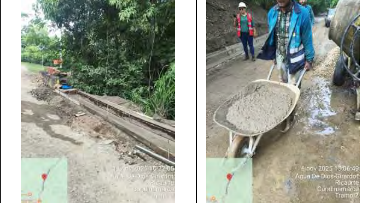
Fotografía 7 Vaciado concreto cunetas tramo 2
