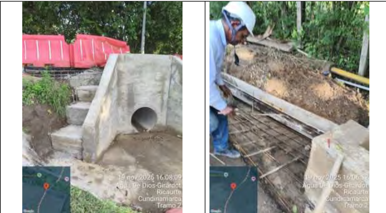
Fotografía 5 Vaciado para disipadores k5+560 Tramo 2
