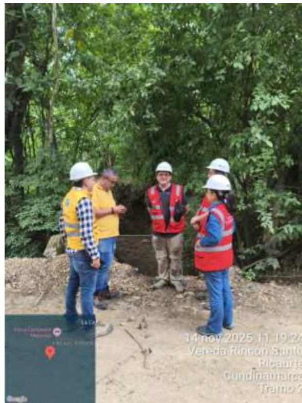
Imagen 3. Recorrido de obra – verificación de solicitudes comunitarias.
