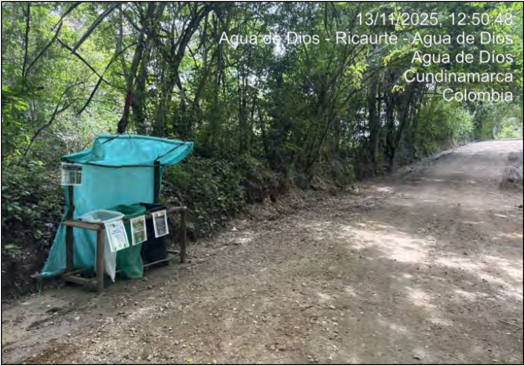
Ilustración 6. Punto ecológico en obra – Tramo 1
