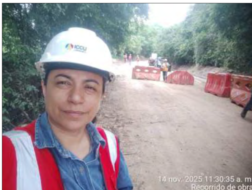
Imagen 2. Recorrido de obra – verificación de solicitudes comunitarias.
