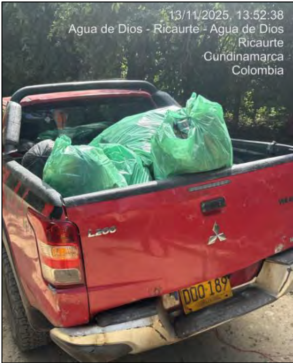
Ilustración 9. Registro fotográfico cargue de bolsas de cemento en obra
