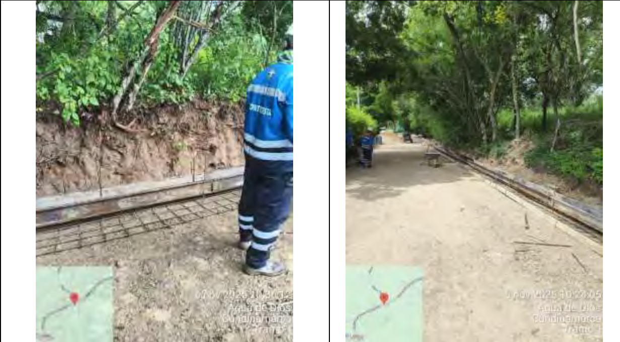
Fotografía 11 Acero de refuerzo para tramo 1
