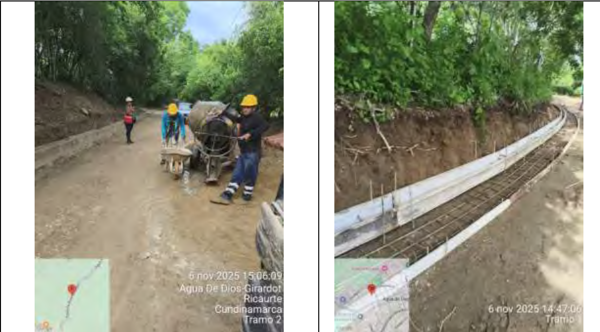
Fotografía 9 concreto elaborado en sitio para cunetas tramo 2
