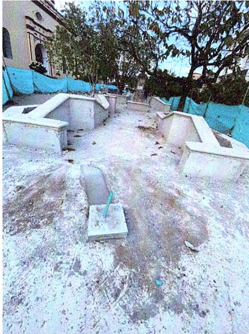
PLANTILLA EN CONCRETO, TUBERIA ELECTRICA PEDESTAL DE APOYO PARA POSTES ELECTRICOS.
