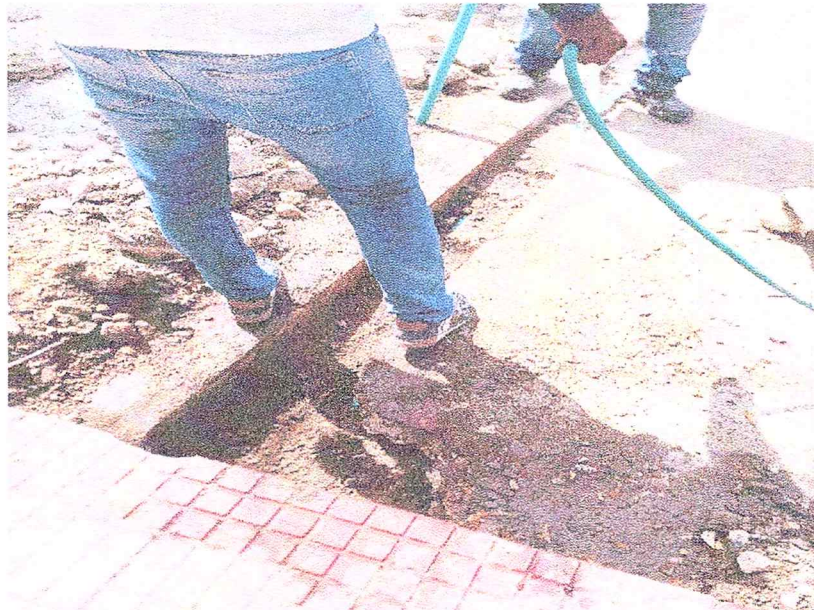
SUPERVISION DE INSTALACION DE TUBERIA PRINCIPAL PVC PARA ACOMETIDA PARQUE 29
