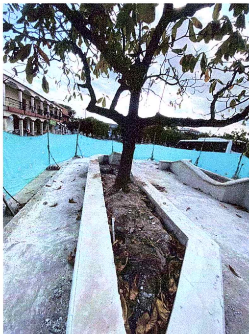
PLANTILLA EN CONCRETO, ALFAJIA Y PAÑETE IMPERMEABILIZADO
