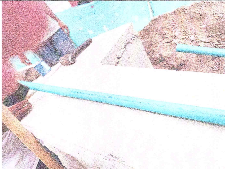
REVISION DE TUBERIA PVC ELECTRICA 3/4" PARA JARDINERAS
