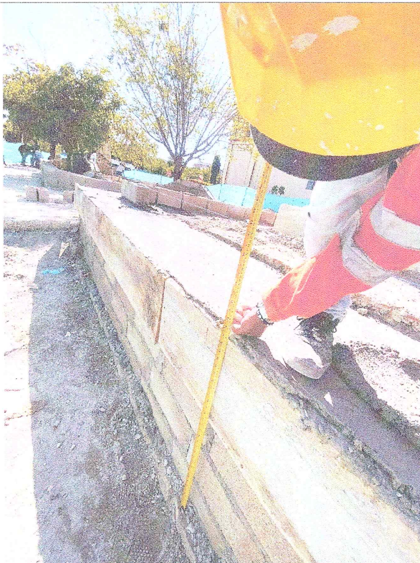
CHEQUEO DE ALTURAS DE MURO DE ESCALINATAS PARQUE 28
