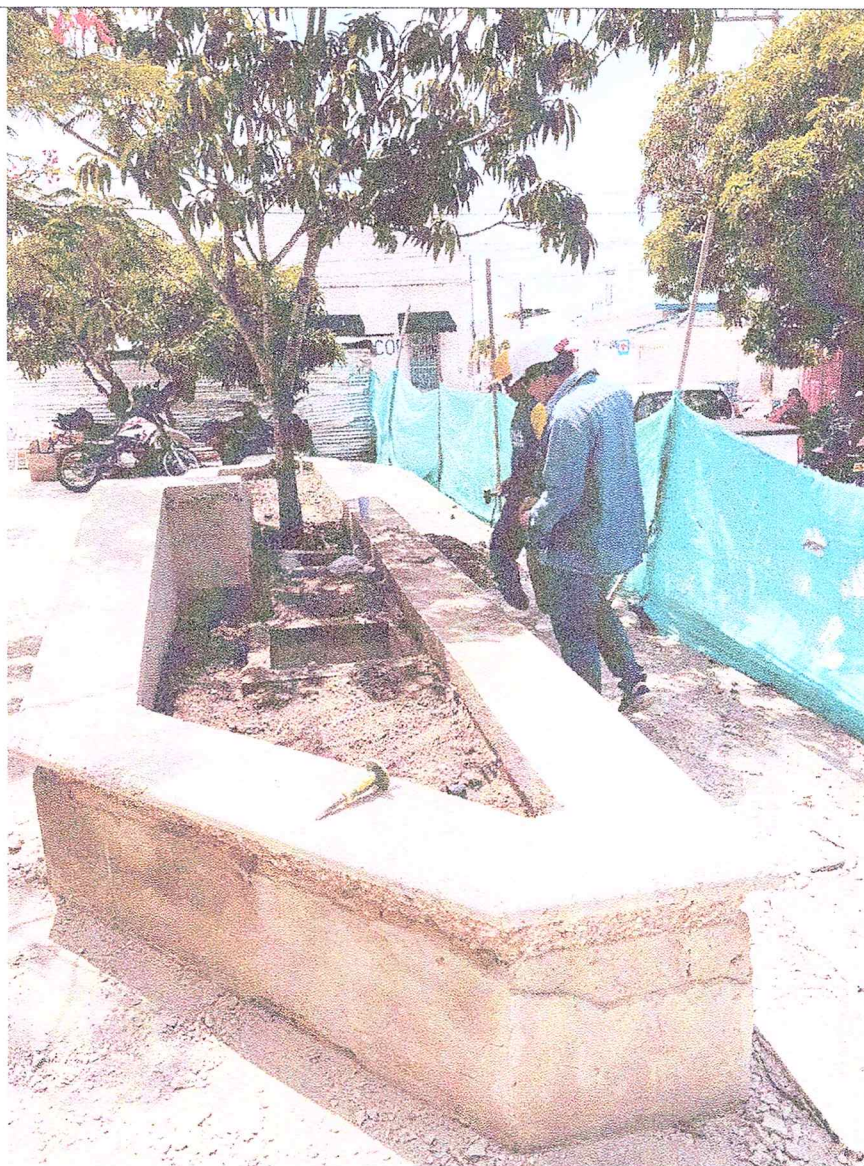
REVISION EN LOS REVOQUES Y FILOS DE LAS JARDINERAS, CORRECCION DE PAÑETE .
