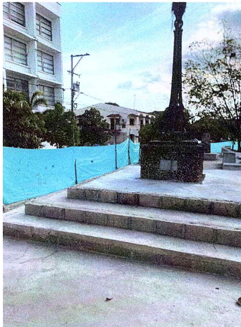
ESCALINATAS MONUMENTO BOULEVAR 28
