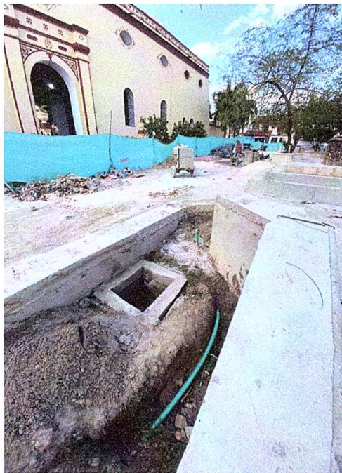
REGISTRO DE HIDROSANITARIO EN JARDINERA Y ALFAJIA BOULEVAR CALLE 28
