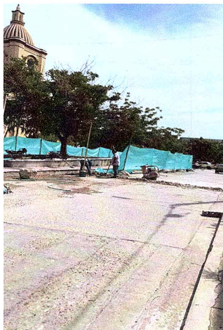
INSTALACION TUBERIA PARA ACOMETIDA ELECTRICA BOULEVART CALLE 29
