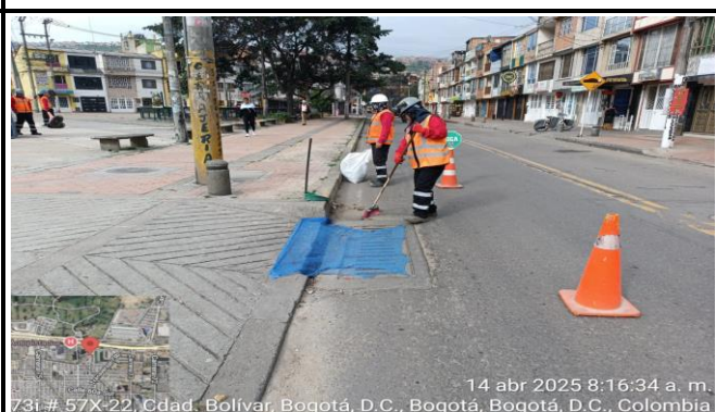
Foto 16. MANTENIMIENTO DE SUMIDEROS # 5
