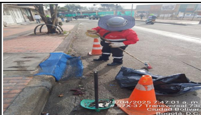
Foto 12. MANTENIMIENTO DE SUMIDEROS # 1
