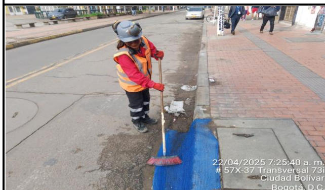
Foto 13. MANTENIMIENTO DE SUMIDEROS # 2
