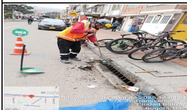
Foto 15. MANTENIMIENTO DE SUMIDEROS # 4
