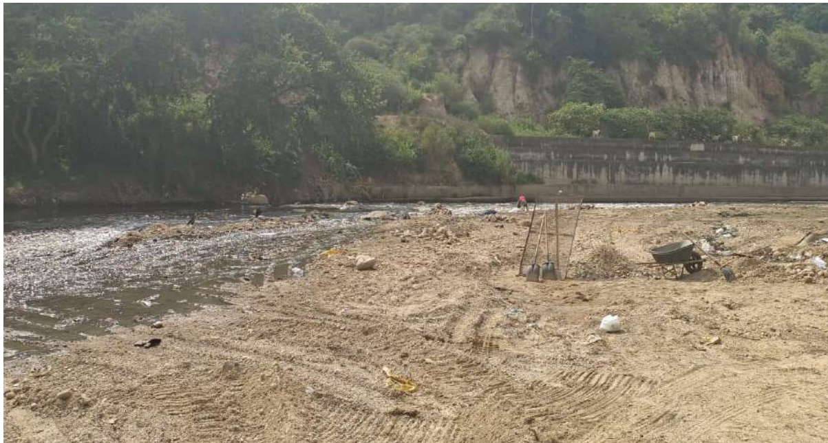
Ilustración 2 área levantamiento topográfico inicial, playa cause del rio
