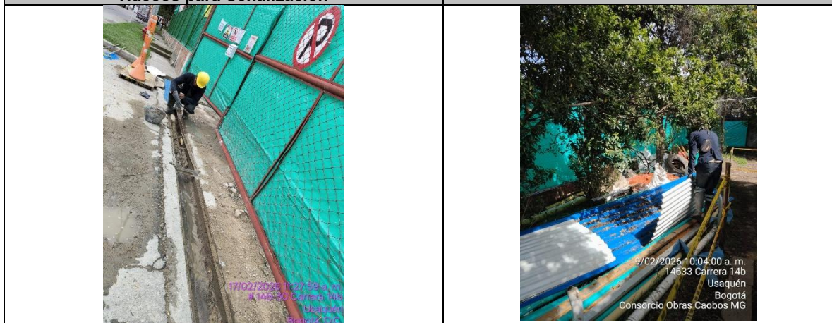
Imagen 18. Supervisión limpieza de cárcamos
