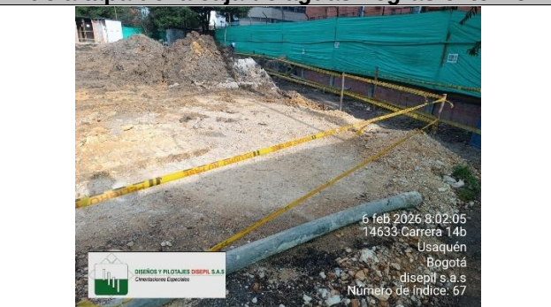
Imagen 54. Subsanción de señalización de sendero peatonal
