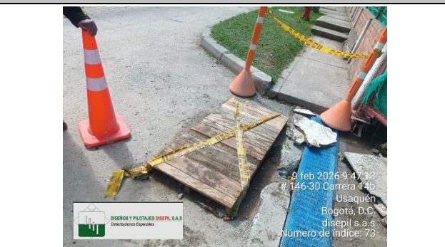
Imagen 52. Cambio de camilla y señalización dela tapa de la caja de aguas negras externo
