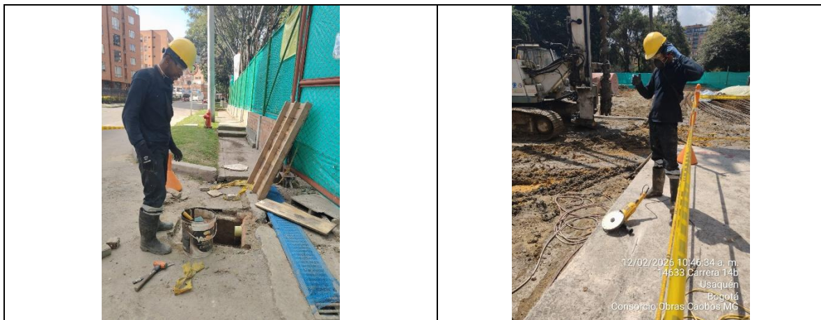
Imagen 14. Supervisión trabajo en obra-Arreglo Tapa de Aguas Negras
