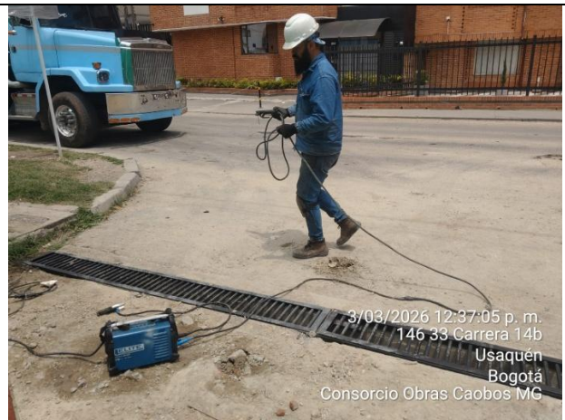
Imagen 50. Instalación de Rejilla
