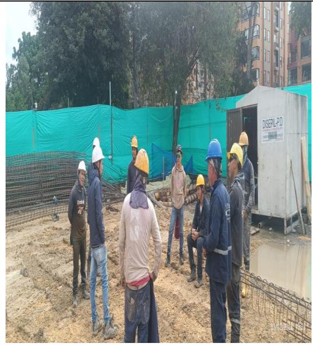
se hace charla de seguridad para todo los trabajadores con el fin de hacerle identificar los riesgo
