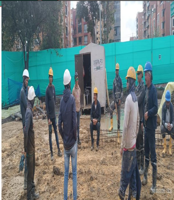
se hace charla de seguridad para todo los trabajadores con el fin de hacerle identificar los riesgo
