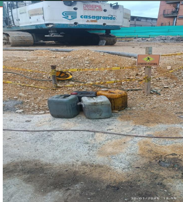
ingresa insumos para la casa grande con el fin de poder en buenas condiciones la maquina piloteadora
