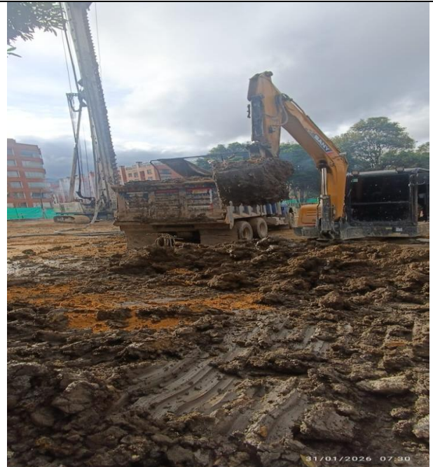
la obra requiere foto del material que se saca con las volquetas para llevar un control de retiro de material
