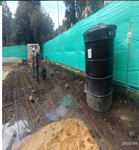
se señala el área de armado de los herreros con el fin de identificar el área de armado de parrillas
