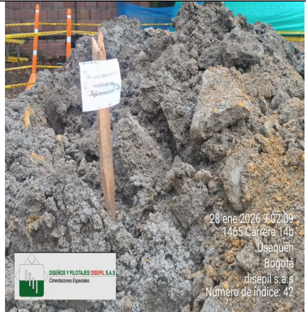
se demarca el área de acopio de barro con el fin de poder identificar
