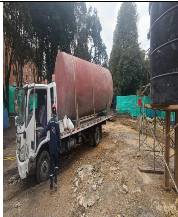
ingresa a obra un tanque para almacenamiento de agua
