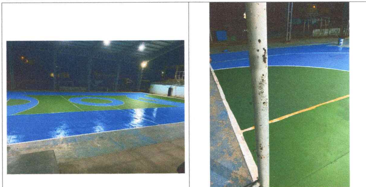
Ilustración 14 - Ítems 2.4: Demarcación de Cancha Pintura antideslizante resistente al tráfico peatonal y deportivo
