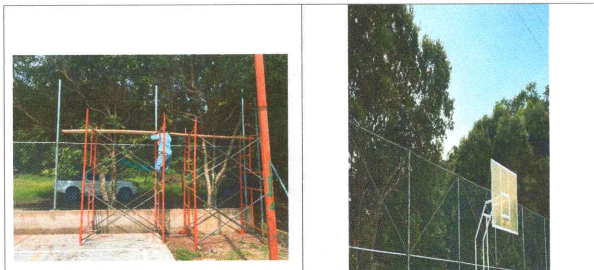
Ilustración 24 - Ítems 5.2: Ángulos metálicos de 1 1/2" para soporte de malla contra golpe
