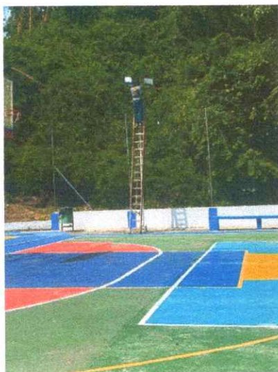
Ilustración 26 - Ítems 1.1: Suministro e instalacion de reflector 200W Potencia 200w, Tension de Operación 110-277V, Flujo luminoso mayor o igual a 19000 Lm, Temperatura de color 6000K, Vida Util mayor o igual a 30,000 Horas. Incluye fotocelda eléctrica
