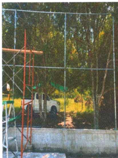
Ilustración 25 - Ítems 5.2: Malla contra impacto según diseño estructural, incluye suministro e instalación de Tubos metálicos de 1", anclajes, platinas, tensores, soldadura, pintura anticorrosiva de esmalte (2 manos)
