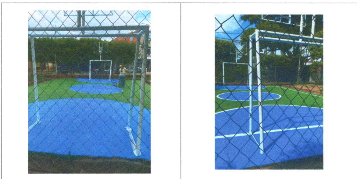
Ilustración 6 - Ítems 4.2: Demarcación de Cancha Pintura antideslizante resistente al tráfico peatonal y deportivo
