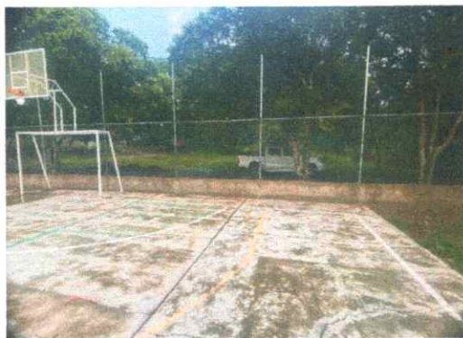
Ilustración 25 - Ítems 5.2: Malla contra impacto según diseño estructural, incluye suministro e instalación de Tubos metálicos de 1", anclajes, platinas, tensores, soldadura, pintura anticorrosiva de esmalte (2 manos)
