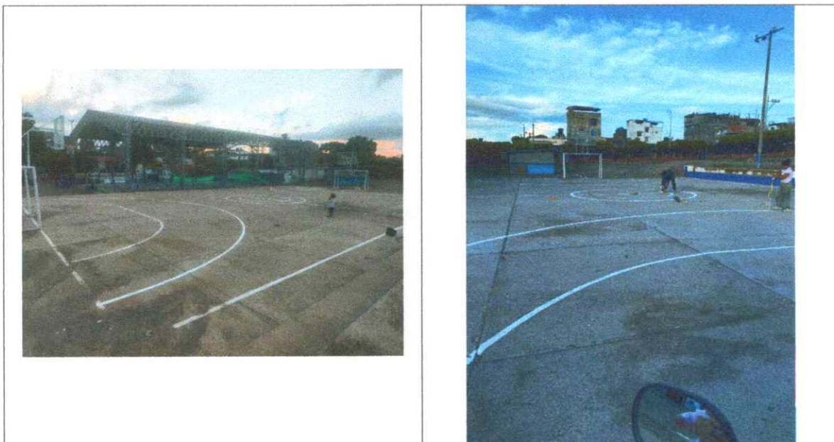
Ilustración 10 - Ítems 1.4: Demarcación de Cancha Pintura antideslizante resistente al tráfico peatonal y deportivo
