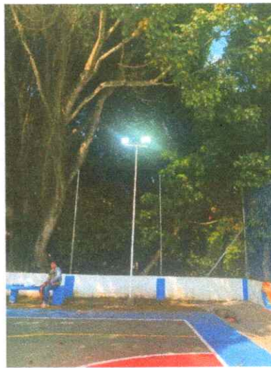
Ilustración 26 - Ítems 1.1: Suministro e instalacion de reflector 200W Potencia 200w, Tension de Operación 110-277V, Flujo luminoso mayor o igual a 19000 Lm, Temperatura de color 6000K, Vida Util mayor o igual a 30,000 Horas. Incluye fotocelda eléctrica
