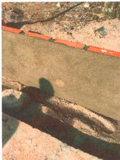
Ilustración 22 - Ítems 4.2: Pañete muros 1:4 (incluye filos y dilataciones)
