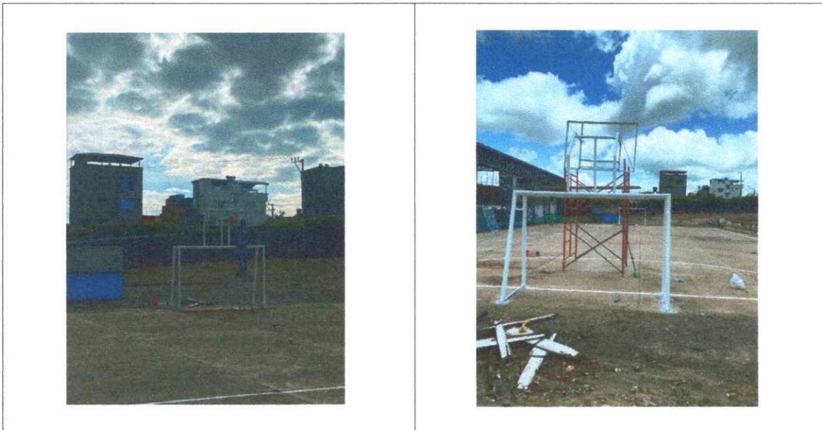
Ilustración 9- Ítems 1.3: Suministro e instalación de tableros de baloncesto en acrílico calibre 12 mm resistente a la intemperie Incluye (Aro y malla de baloncesto 6 mm blanco para aro o canasta) y demás elementos necesarios para su correcto funcionamiento.
