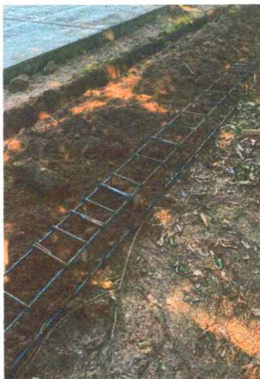
Ilustración 20 - Ítems 3.1: Acero de refuerzo 60.000 PSI
