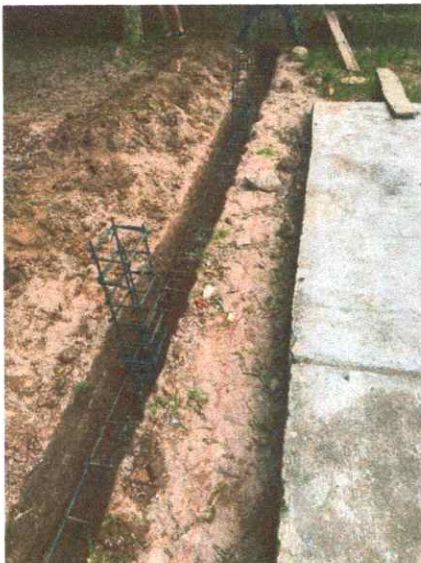
Ilustración 18 - Ítems 2.1: Viga cimentación 3.000 PSI 0.30X0.20 m
