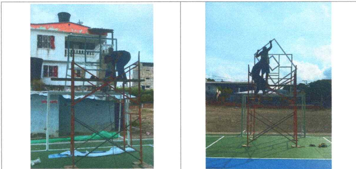
Ilustración 13 - Ítems 2.2: Desmonte de tableros de baloncesto existente e Ítems 2.3: Suministro e instalación de tableros de baloncesto en acrílico calibre 12 mm resistente a la intemperie Incluye (Aro y malla de baloncesto 6 mm blanco para aro o canasta)
