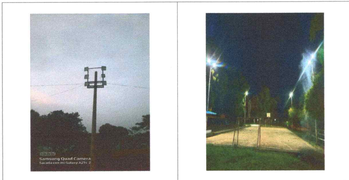
Ilustración 34 - Ítems 1.9: Suministro e instalación de reflector potencia 200w, incluye fotocelda eléctrica. Para el corregimiento de Villaflores
