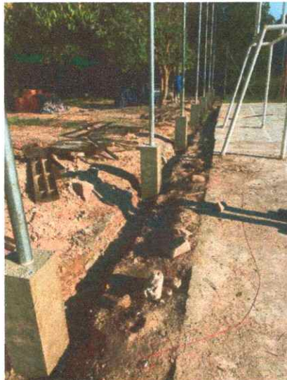
Ilustración 19 - Ítems 2.2: Columna 3.000 PSI 0.25X0.25 m
