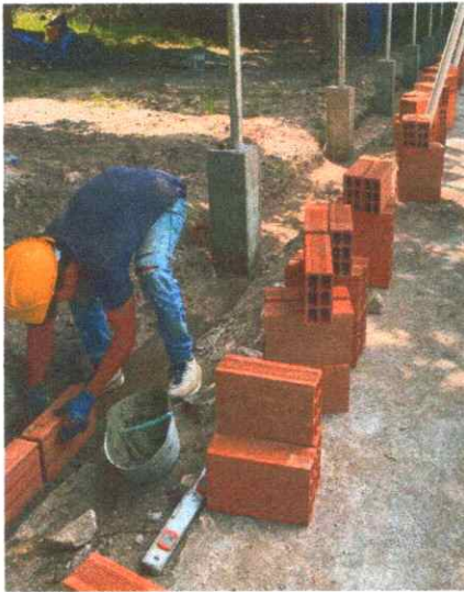
Ilustración 21 - Ítems 4.1: Muro en ladrillo H-10
