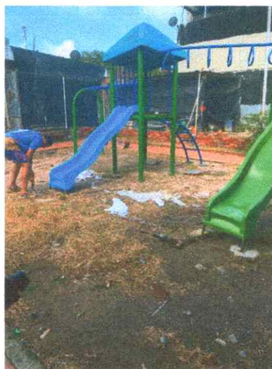
Ilustración 7 - Ítems 4.3: Pintura para parque infantil (Incluye lijado y anticorrosivo)
