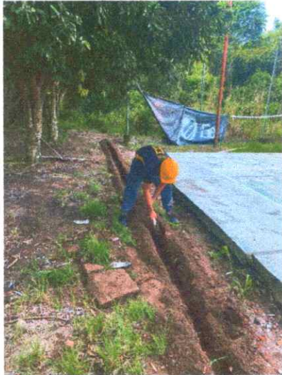
Ilustración 17 - Ítems 1.2: Excavación manual cimientos
