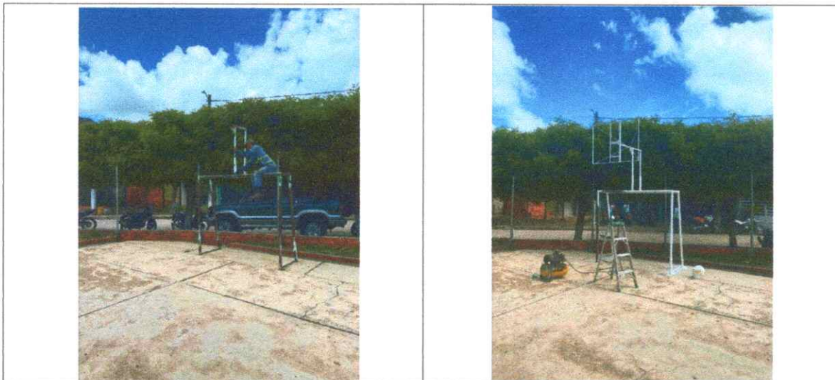
Ilustración 5- Ítems 4.1: Adecuación estructura arcos metálicos incluye (lijar, aplicación de pintura anticorrosiva, pintura y demás elementos necesarios para su correcto funcionamiento)
