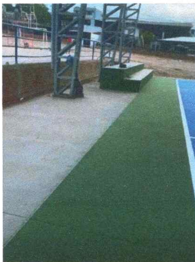
Ilustración 15 - Ítems 2.5: Pintura de exteriores para gradería (incluye remoción de pintura en mal estado)
