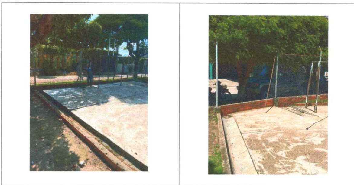
Ilustración 1 – Ítems 1.1 Desmonte módulos en malla eslabonada plastificada en mal estado (Incluye retiro)
