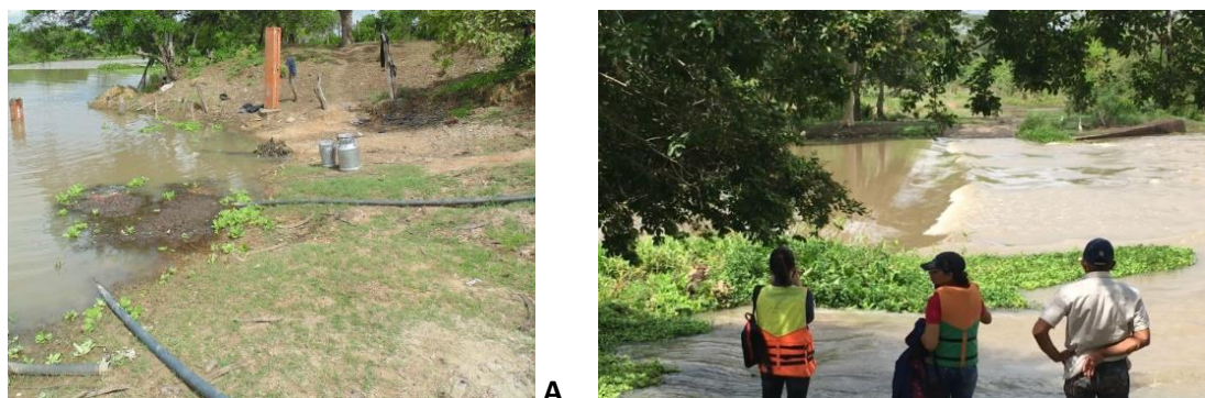
Figura 37. Intervenciones antrópicas en la ciénaga de Betancí .A) Captación de agua. B) Construcción del dique. Fuente: Equipo técnico.
