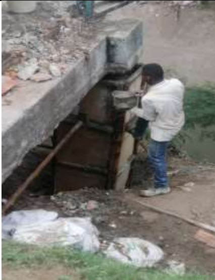
Foto No. 17 Fundición para calce, refuerzo y revestimiento de columna. Comuna 15 Barrio Mojica - CALLE 72Z2 CON KR 28D2
