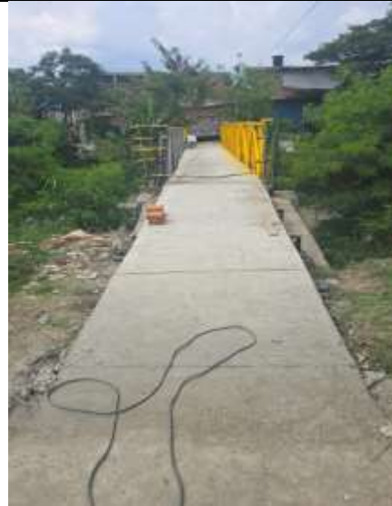
Foto No. 18 Fundición de andén y pintura de barandas del puente. Comuna 15 Barrio Mojica - CALLE 72Z2 CON KR 28D2
