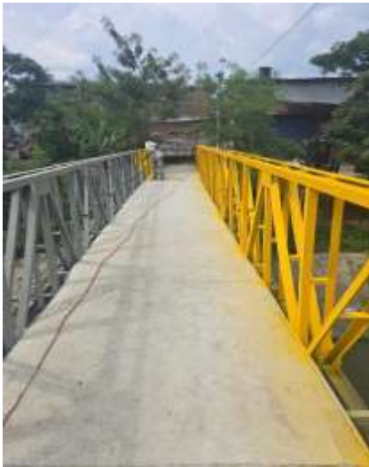
Foto No. 19 Pintura anticorrosiva y de acabado de las barandas del puente peatonal, Comuna 15 Barrio Mojica - CALLE 72Z2 CON KR 28D2
