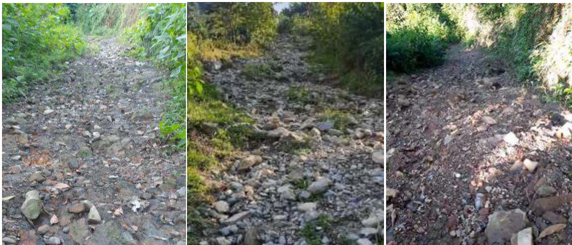
Ilustración 37. Estado inicial de la vía
