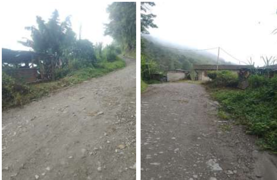
Ilustración 28. Estado inicial de la vía
