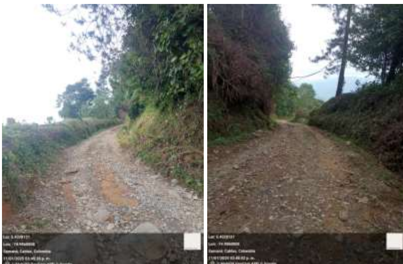
Ilustración 25. Estado inicial de la vía
