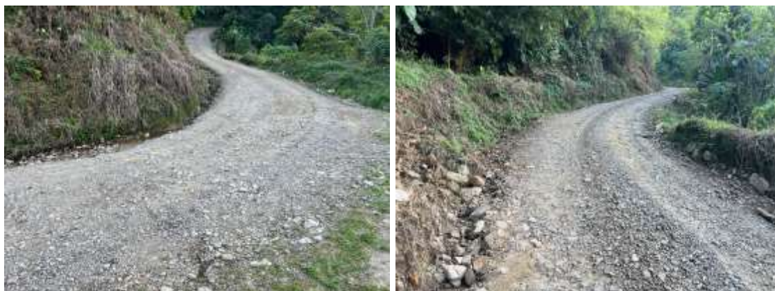
Ilustración 34. Estado inicial de la vía
