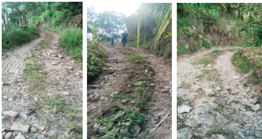
Ilustración 31. Estado inicial de la vía
