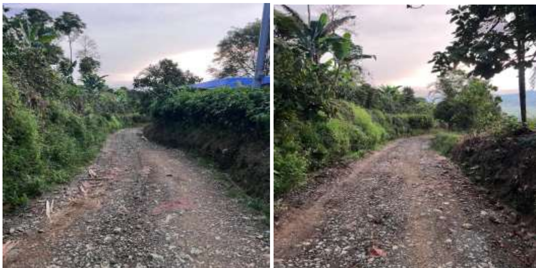
Ilustración 40. Estado inicial de la vía
