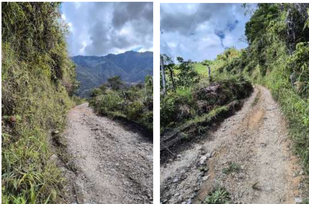
Ilustración 43. Estado inicial de la vía
