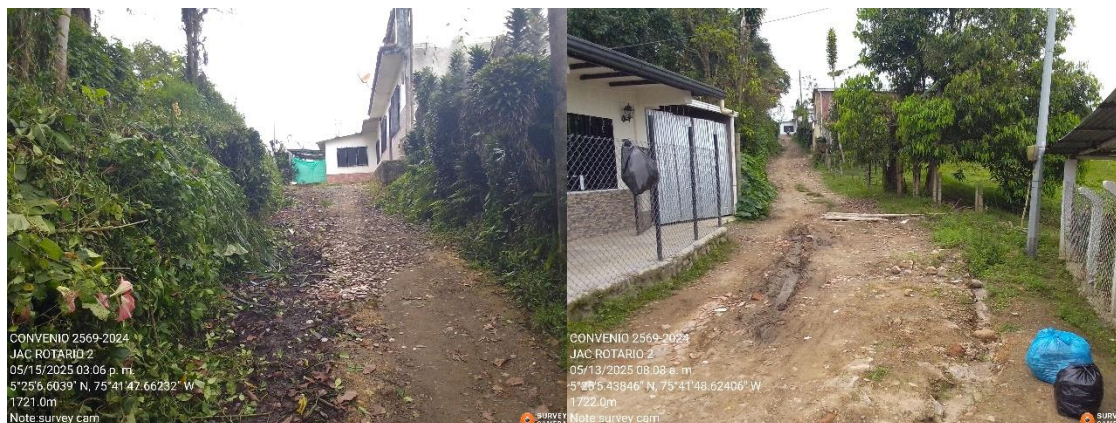
Ilustración 66 Estado inicial de la vía
