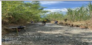
FOTO 2 - COMPACTACIÓN DE TERRENO
