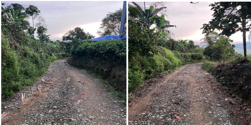
Ilustración 41. Estado inicial de la vía
