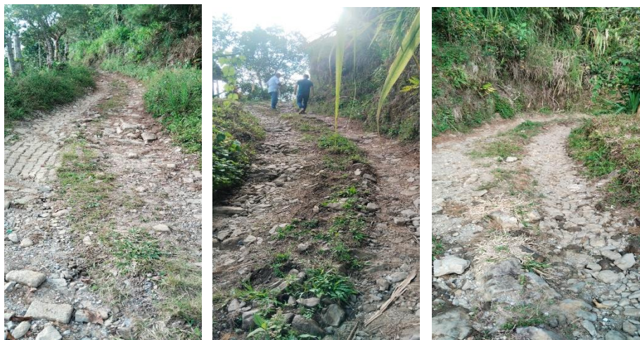
Ilustración 32. Estado inicial de la vía
