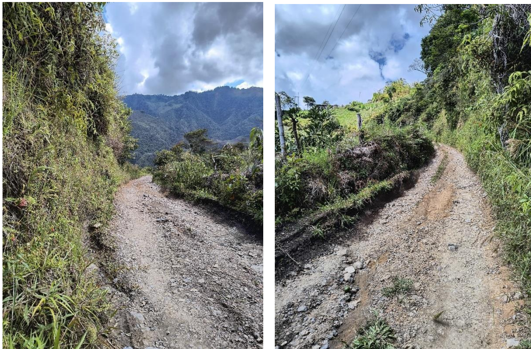
Ilustración 44. Estado inicial de la vía
