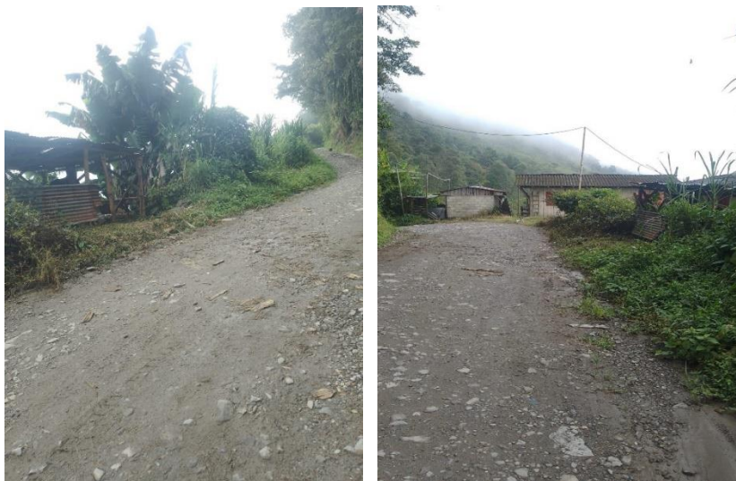
Ilustración 29. Estado inicial de la vía
