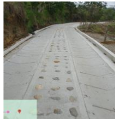
VEREDA CARACOLÍ FOTO 1 - OBRA FINALIZADA 15/04/25
