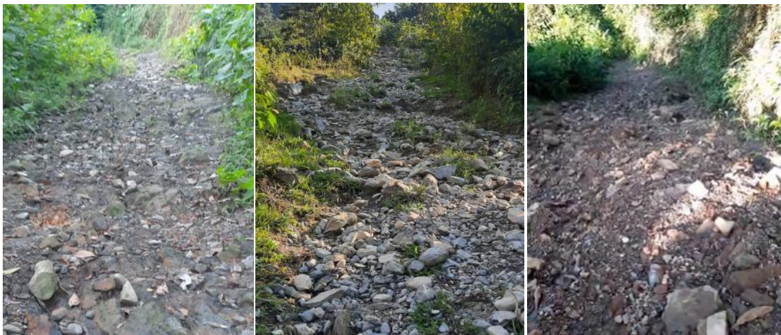
Ilustración 38. Estado inicial de la vía
