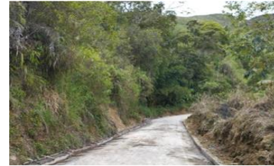
VEREDA EL VERDAL FOTO 2 - OBRA FINALIZADA - 16/04/2025
