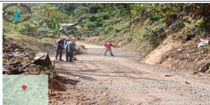
Foto 1, Localización y replanteo
