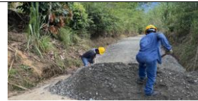
FOTO 3 - APLICACIÓN DE SUBBASE
