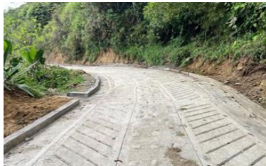
VEREDA EL VERDAL FOTO 1 - OBRA FINALIZADA - 16/04/2025
