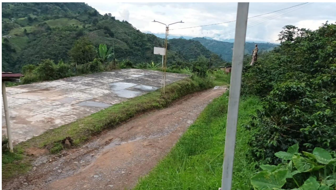
Ilustración 64 Estado inicial de la vía
