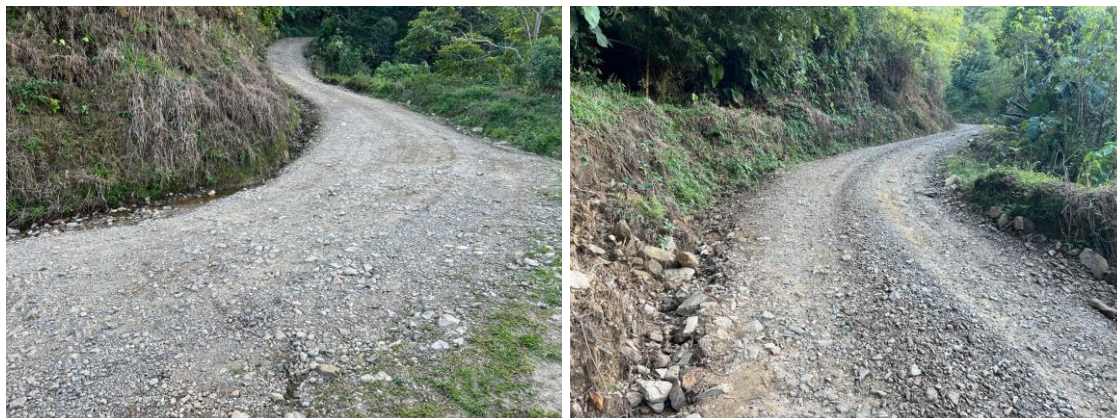
Ilustración 35. Estado inicial de la vía
