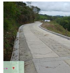
VEREDA CARACOLÍ FOTO 2 - OBRA FINALIZADA 15/04/25
