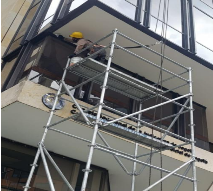
Foto 11: Aplicación de silicona en ventanería de fachada sur.
