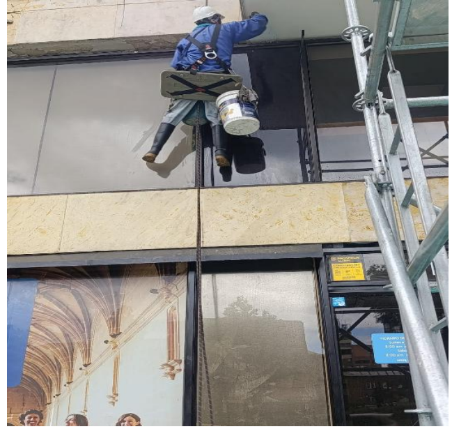
Foto 12: Lavado de ventanería fachada sur piso 2.
