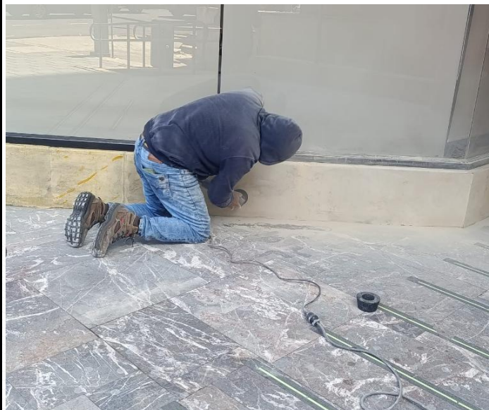
Foto 5: pulida de piedra muñeca para retiro de grafiti
