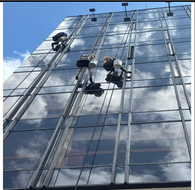
Foto 4: Lavado de ventanería en fachada sur.
