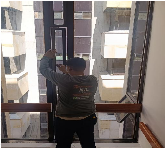
Foto 13: Mantenimiento de ventanería batiente en zona de escaleras.
