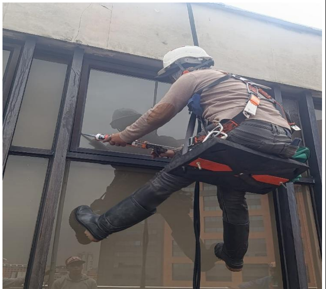
Foto 6: Aplicación de silicona en ventanería de la fachada sur.
