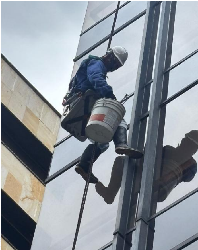
Foto 1: Ensiliconado de ventanería en fachada sur.
