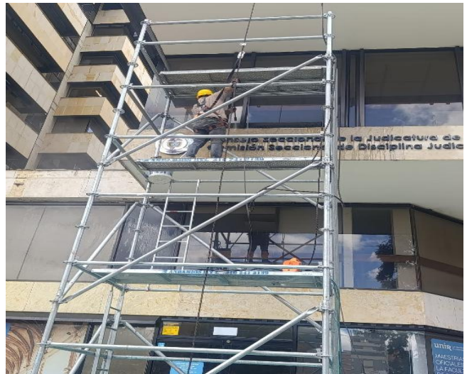
Foto 10: Aplicación de pintura en cielo raso de la fachada sur, pisos 3 y 2.
