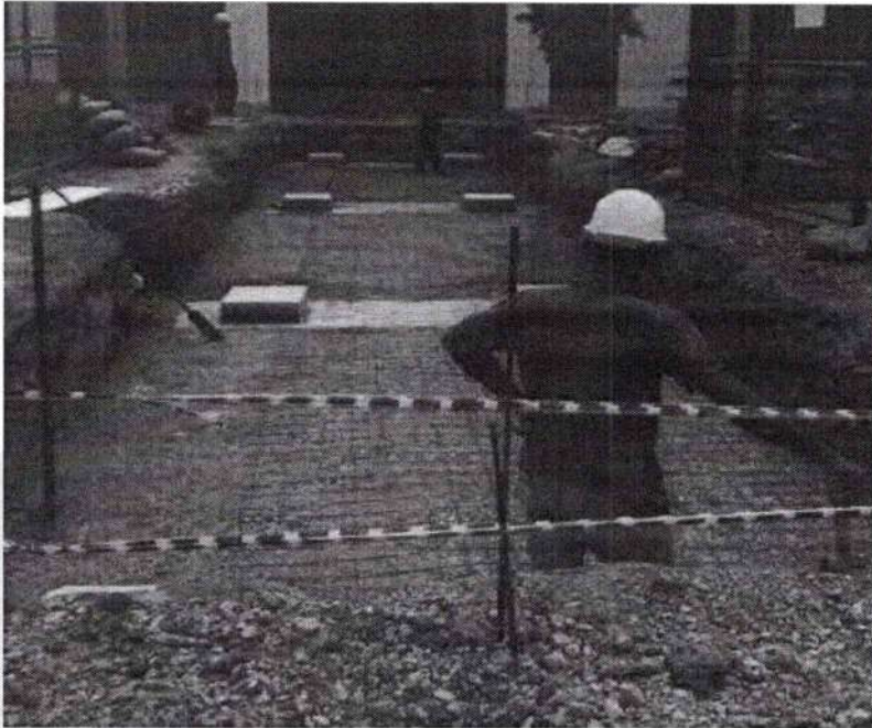
Fundición de bases
