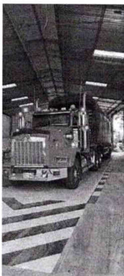
BASCULA ELECTRÓNICA AGROPESO – (Bucaramanga) bascula de foso Capacidad 80 toneladas Pesaje de café y cacao
