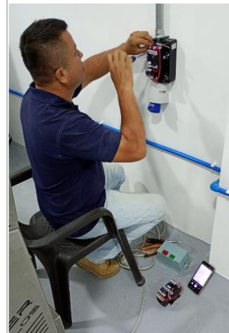
Imagen 3: Adecuación de infraestructura al interior.
