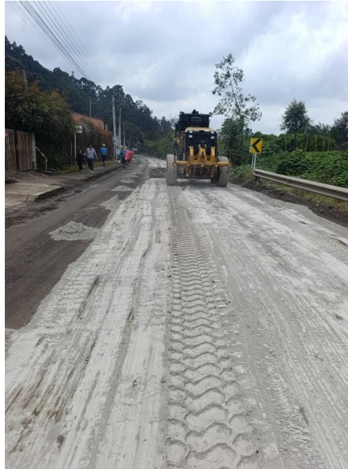
Ilustración 14, Homogenización % de Cemento.
