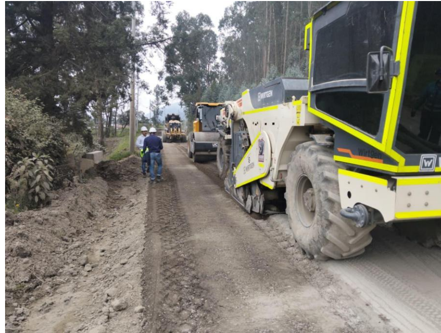
Ilustración 16, Estabilización con material de sitio, emulsión asfáltica y cemento estructural
