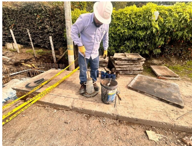
Ilustración 26 y 27, Control de Asentamiento, Toma de slump
