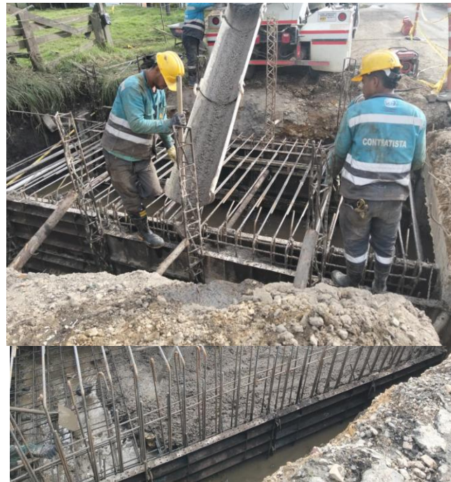
Ilustración 23, Instalación de Concreto Ilustración 24, Instalación de Concreto
