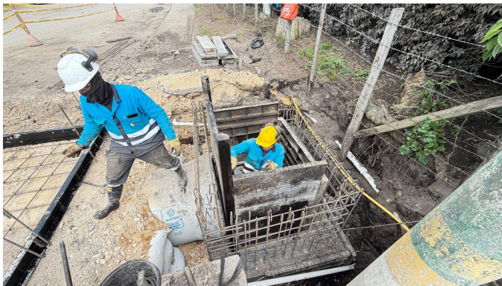
Ilustración 22, Refuerzo Caja de Encole
