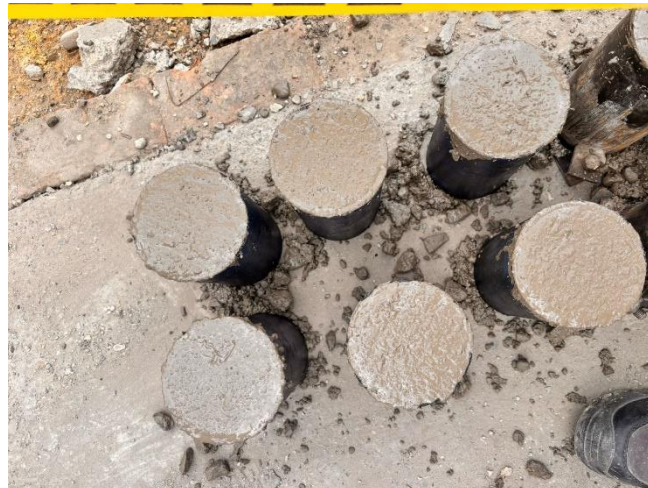
Ilustración 28, Verificación de Asentamiento Ilustración 29, Toma de cilindros.
