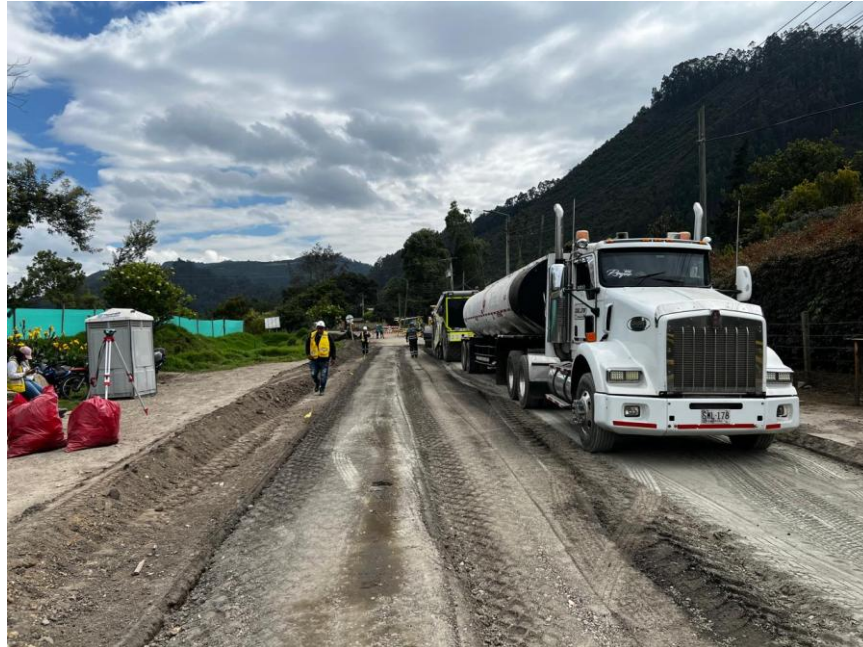
Ilustración 15, Estabilización con material de sitio, emulsión asfáltica y cemento estructural
