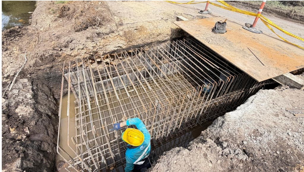
Ilustración 20, Instalación y Amarre de Acero de Refuerzo
