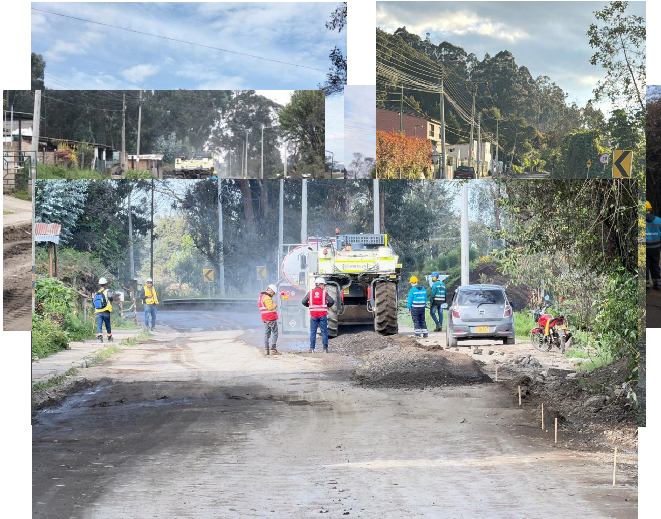
Ilustración 6, Reciclado Material de Sitio, Sector de La Cuesta, K8+880.
