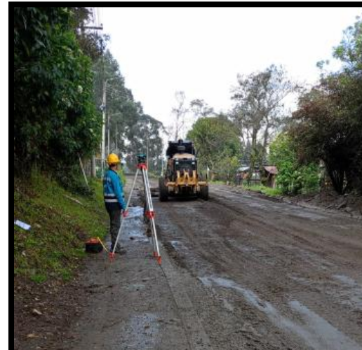
Ilustración 35 y 36, Control Topográfico Estabilizado.
