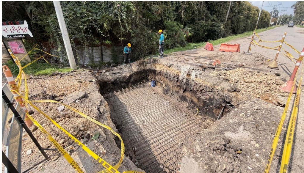
Ilustración 19, Instalación y Amarre de Acero de Refuerzo
