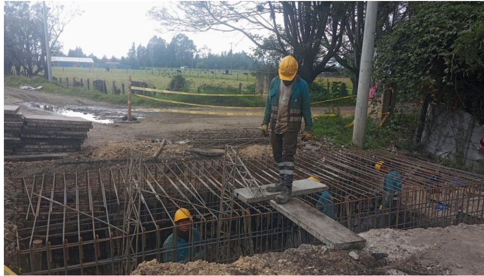
Ilustración 21, Instalación y Amarre de Acero de Refuerzo
