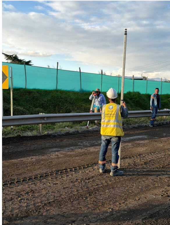
Ilustración 33 y 34, Control Topográfico Estabilizado.
