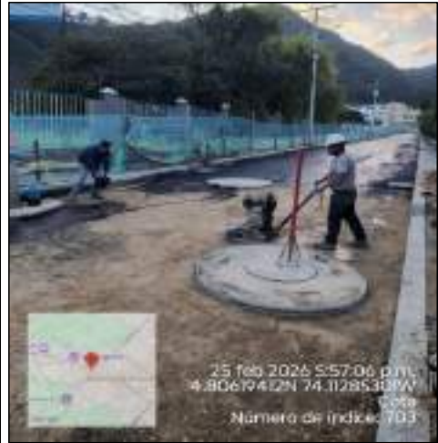
RIEGO DE IMPRIMACIÓN
