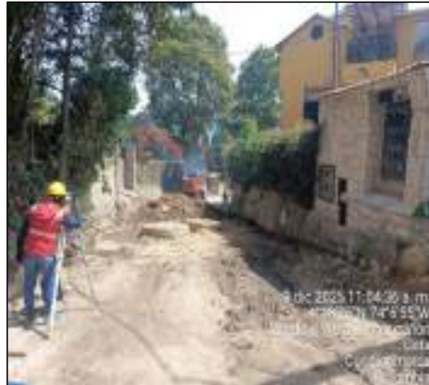
CONTROL TOPOGRÁFICO EN OBRA
