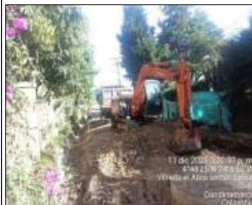
EXCAVACIONES VARIAS A MÁQUINA SIN CLASIFICAR (INCLUYE RETIRO DE SOBRANTES A UNA DISTANCIA MENOR DE 5 KM)
