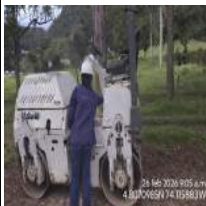
Ilustración 16 Revisión Vibro compactador
