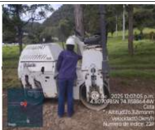
Ilustración 16 Revisión Vibro compactador
