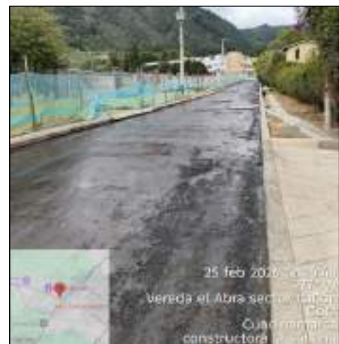
RIEGO DE IMPRIMACIÓN
