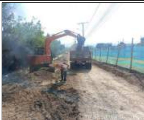
TRANSPORTE DE MATERIALES PROV. DE EXPLANACIÓN, CANALES, PRESTAMOS, SOBREACARREOS Y DERRUMBES
