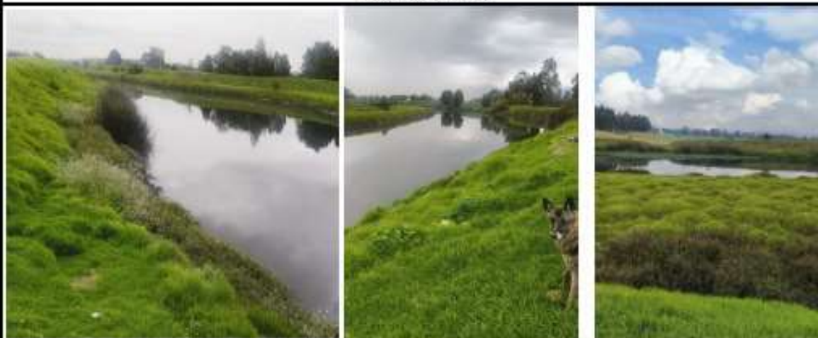
PUNTO DE INTERVENCION
