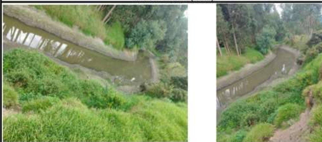
PUNTO DE INTERVENCION
