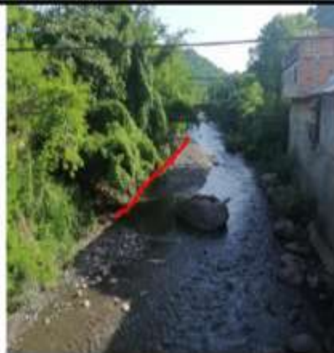
PUNTO DE INTERVENCION
