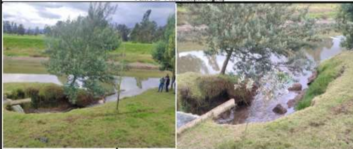
PUNTO DE INTERVENCION
