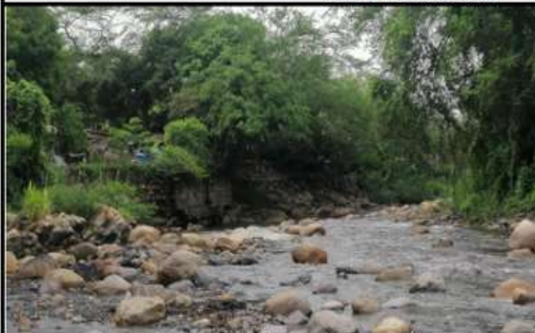
MURO AGUAS ABAJO
