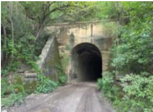
Túnel férreo Golondrinas
