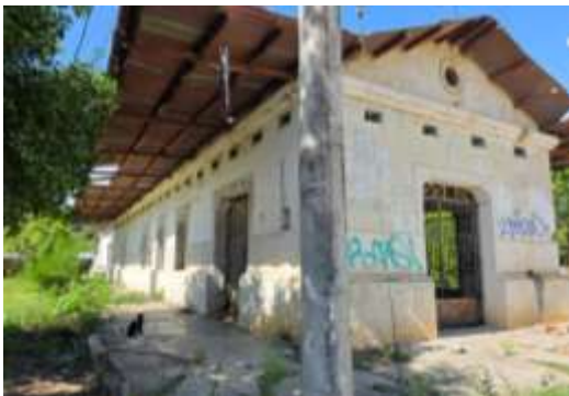
Estación Férrea Villavieja.
