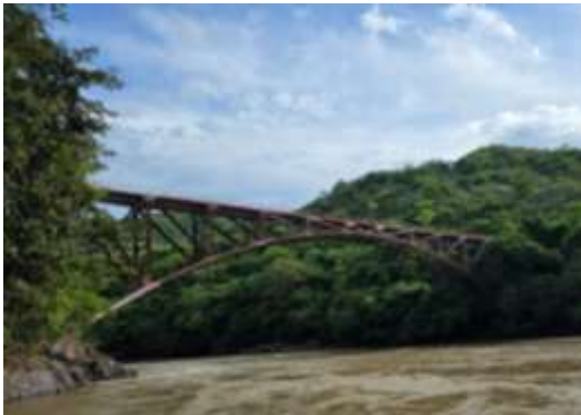
Puente férreo Golondrinas
