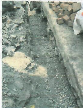
Ilustracion 10. Relleno con material de afirmado compactado rana y/o vibrocompactador (incluye acarreo libre hasta 5 km.)
