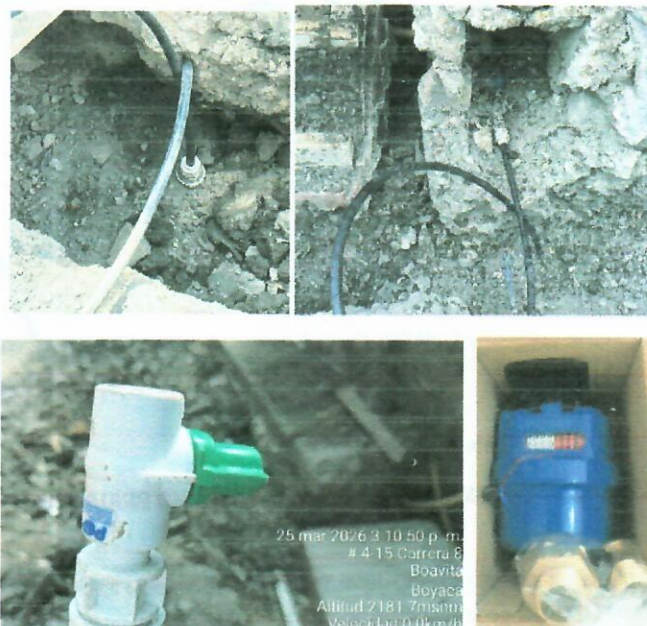
Ilustracion 17. Suministro e instalación de acometida 2" x 1/2" incluye tubería PF + UAD 1/2", registro de corte, collar derivación y accesorios complementarios para su conexión. incluye caja de inspección y medidor volumétrico
