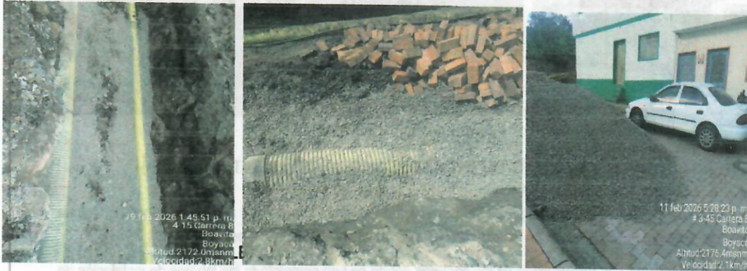
Ilustración 25. Relleno de gravilla
