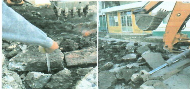
Ilustracion 7. Demolición de concreto
