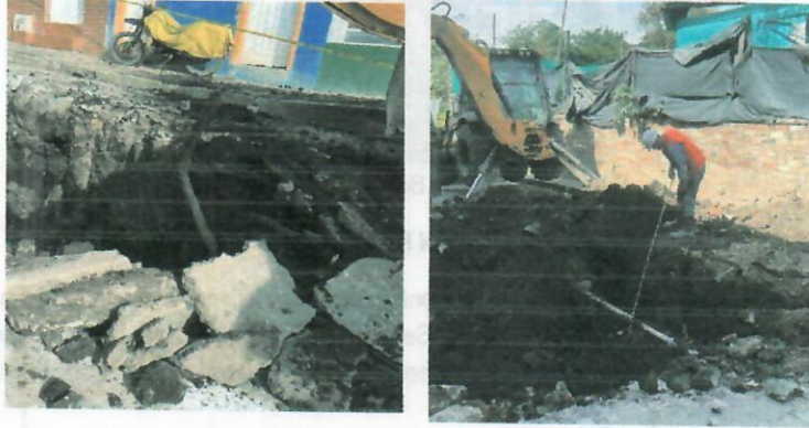
Ilustracion 9. Retiro de tubería de redes de acueducto
