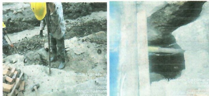
Ilustración 4. Demolición de pisos y/o andenes
