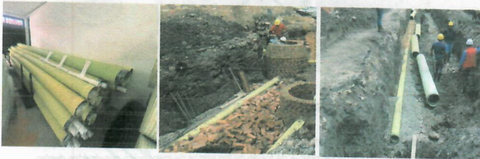
Ilustración 30. Suministro e instalación de tubería d=8"
