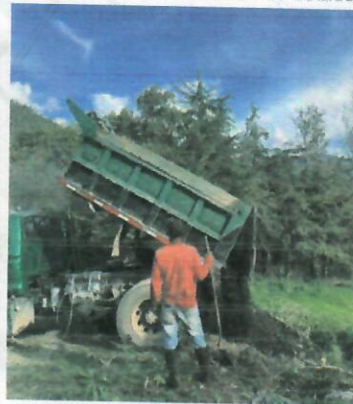
Ilustración 6. Conformación de botadero
