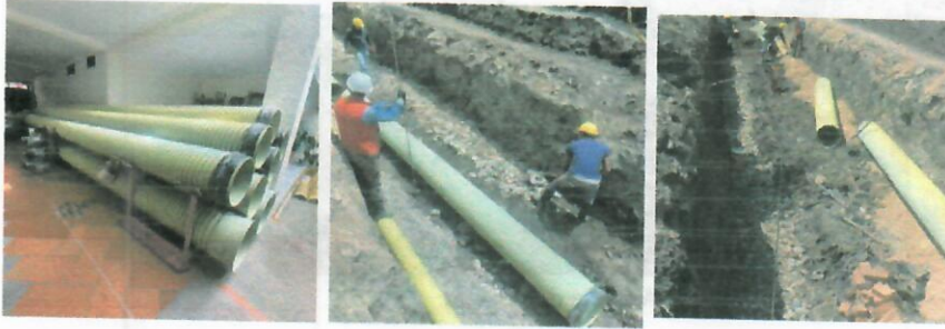
Ilustración 29. Suministro e instalación de tubería d=16"
