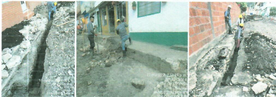
Ilustracion 8. Excavación manual en material común
