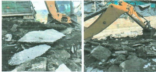
Ilustración 3. Demolición Pavimento asfaltico
