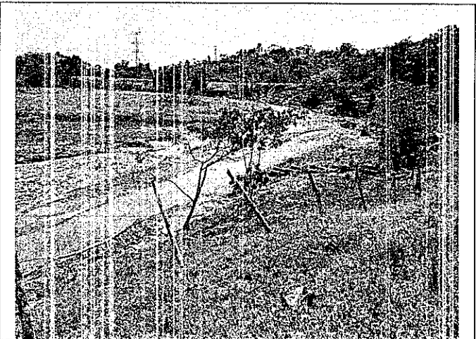
Fotos 5 y 6: donde se puede observar el colapso del muro de contención en gaviones y la obra de drenaje con sus respectivos disipadores, en la margen izquierda el río Guadualito en el punto crítico K9+400
