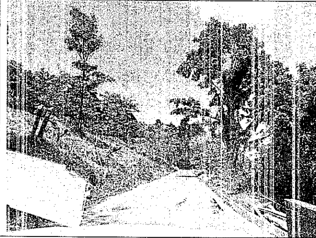
Fotos 11 y 12: pavimento asfáltico en buen estado entre las abscisas K16+000 y K17+000
