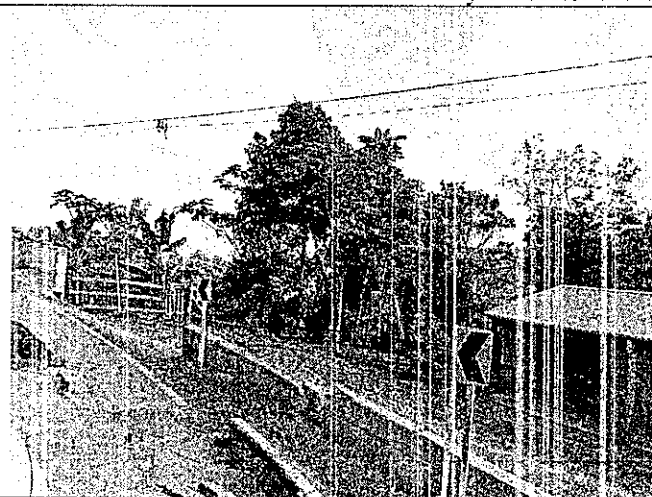
Fotos 15 y 16: bordillo de confinamiento con asentamiento de pavimento y muro de contención en pilas profundas
