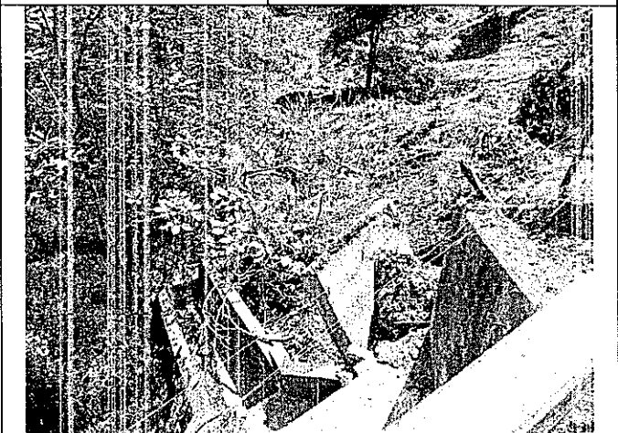
Fotos 9 y 10: estado actual del tramo entre el K15+000 y el K16+000 donde se observa colapso de las obras de drenaje
