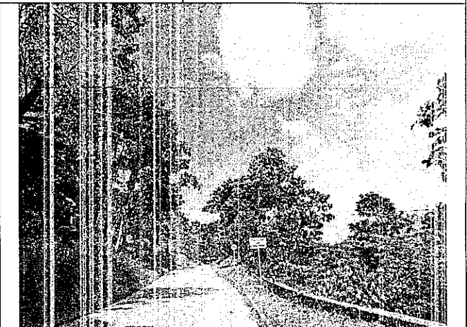
Foto 8: tramo de pavimento en el K15+000
