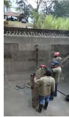
FOTO : MEJORAMIENTO DEL ACUEDUCTO DE LA VEREDA LA VEGA, MUNICIPIO DE MACANAL, DEPARTAMENTO DE BOYACÁ 19
