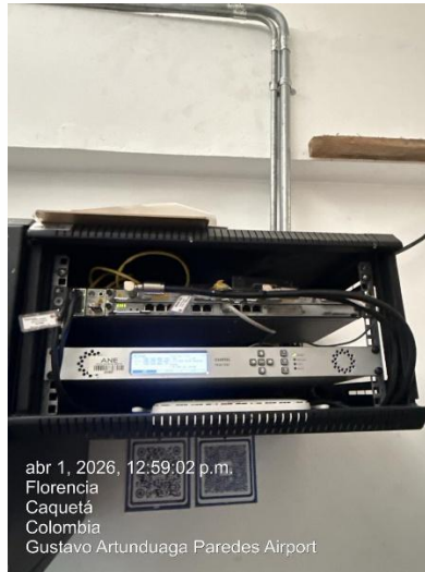
FIGURA 6. INSTALACION DEL EQUIPO
