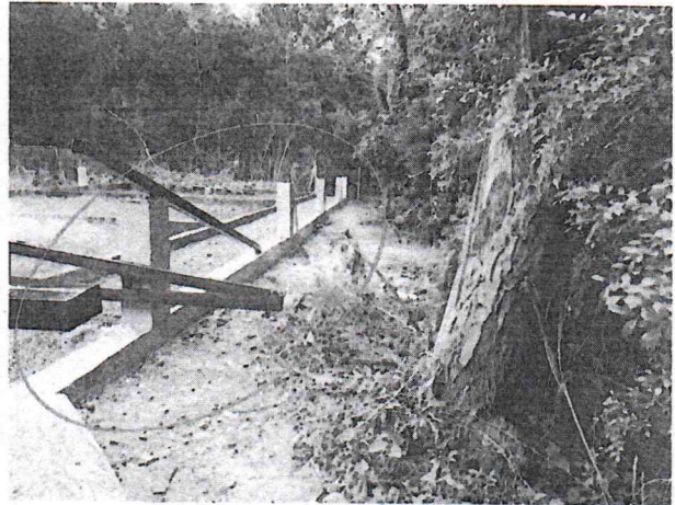
Pedestales en concreto 0.20x0.20x1,00 y Viga de Cimentación
