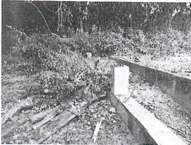
Pedestales en concreto 0.20x0.20x1,00 y Viga de Cimentación
