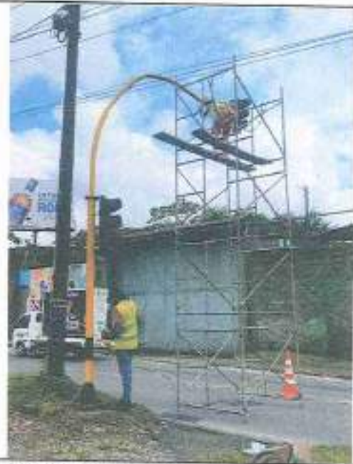
Lavado y pintura:
