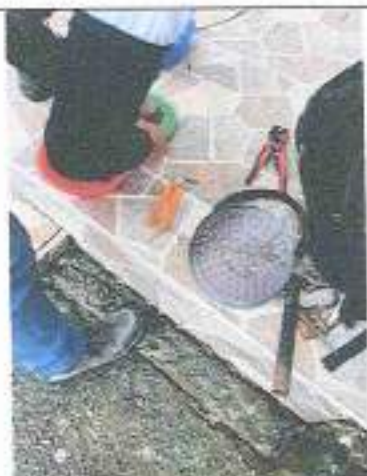
Reparación luz peatonal roja
