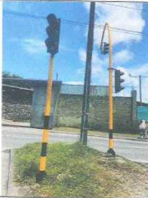
Mantenimiento de red eléctrica.
