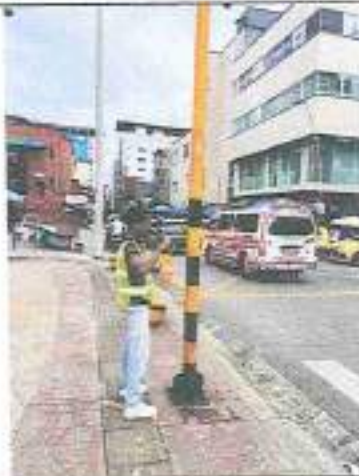
Lavado y pintura de Mensula y Mastil:
