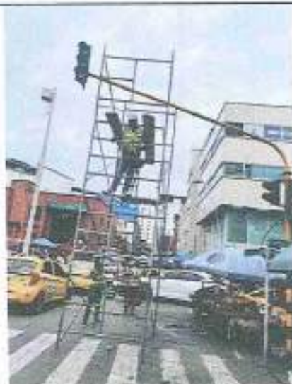
Instalación de semáforo peatonal animado:
