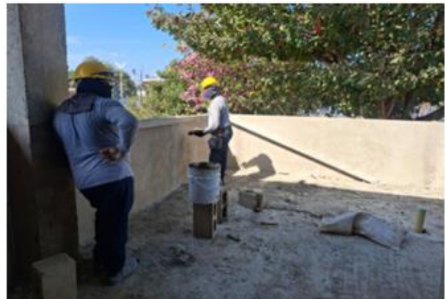
Ilustración 12. Inicio de pañete en fachada segundo nivel
