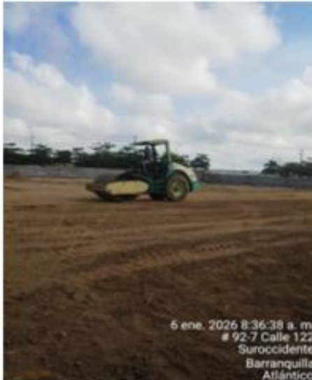
Ilustración 1. Extensión de material subbase
