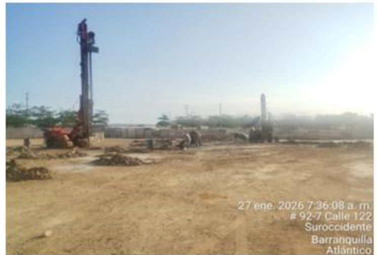
Ilustración 4. Excavación de pilotes
