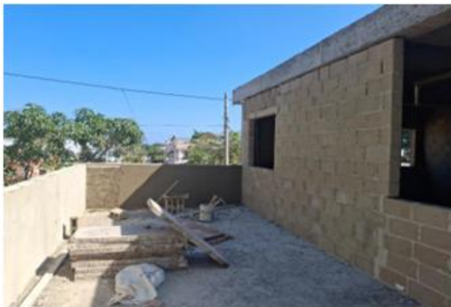
Ilustración 11. Inicio de pañete en fachada segundo nivel
