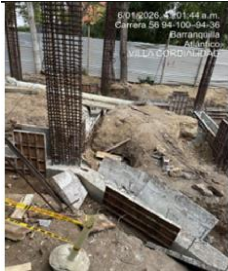
Ilustración 13. Fundida de cimentación
