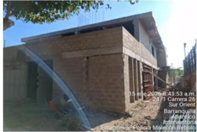
Ilustración 10. Levante de muros de mampostería
