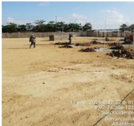
Ilustración 3. Extendido de material
