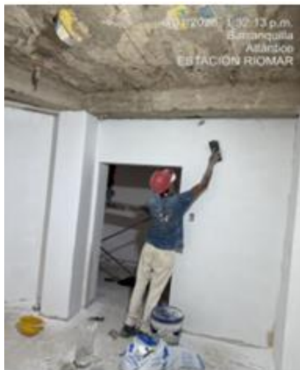
Ilustración 15. Aplicación de estucos interiores
