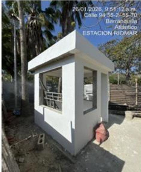
Ilustración 17. Aplicación estuco plástico
