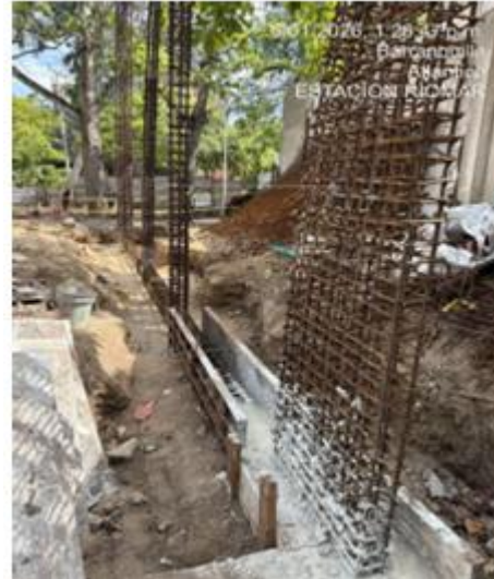
Ilustración 14. Armado de acero de refuerzo para vigas de cimentación
