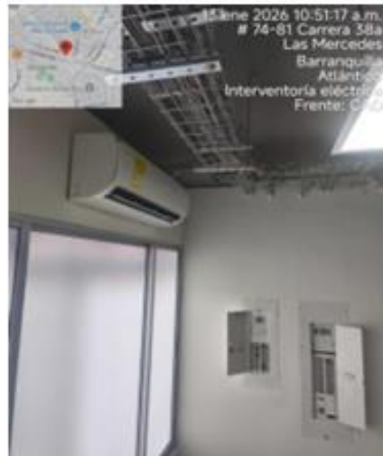
Ilustración 27. Instalación de AA
