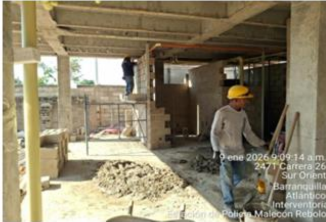
Ilustración 9. Levante de mampostería interna
