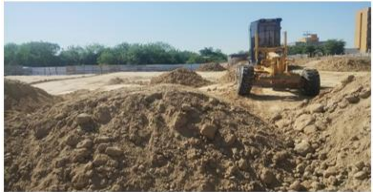
Ilustración 6. Extendido de material subbase Caribe Verde
