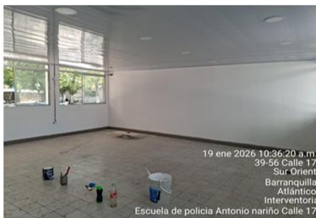
Ilustración 23. Instalación de cielo raso y pintura de guardaescobas
