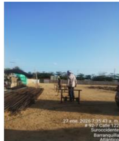
Ilustración 8. Armado de acero de refuerzo para pilotes
