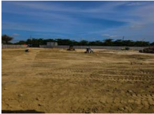
Ilustración 5. Extendido de material subbase Caribe Verde
