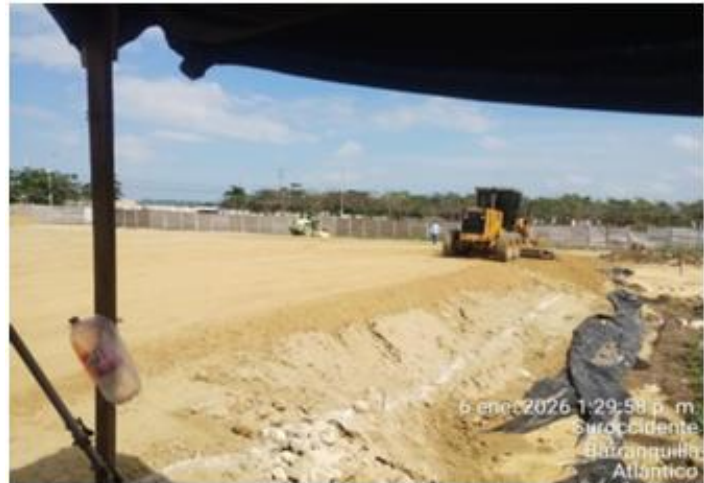
Ilustración 2. Extendido de material subbase Caribe verde
