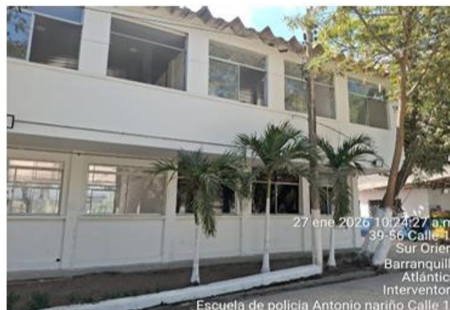
Ilustración 24. Aplicación de estuco plástico exterior
