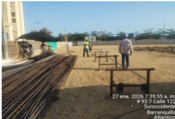
Ilustración 7. Armado de acero de refuerzo para pilotes
