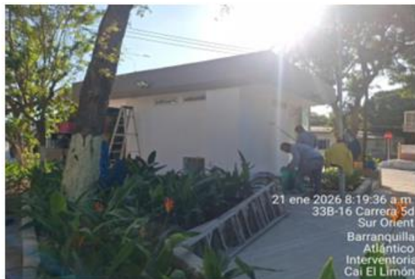
Ilustración 35. Toma de detalles el limon
