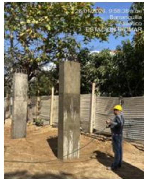
Ilustración 20. Columnas fundidas
