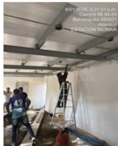
Ilustración 16. Instalación de bandejas para acometida eléctrica
