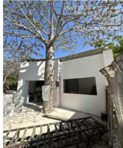
Ilustración 18. Aplicación de estuco plástico
