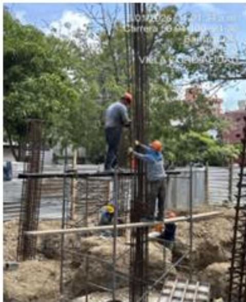
Ilustración 19. Armado de acero para columnas
