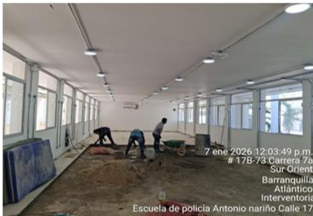
Ilustración 21. Instalación de piso en granito pulido
