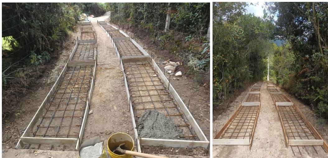
Ilustración No. 2 – Instalación de formaletas y aceros de refuerzo Fuente: elaboración Propia
