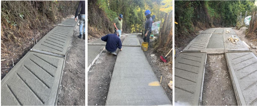
Ilustración No. 4 – Fundida de concreto clase D f'c = 3000 psi (bases) Fuente: elaboración Propia
