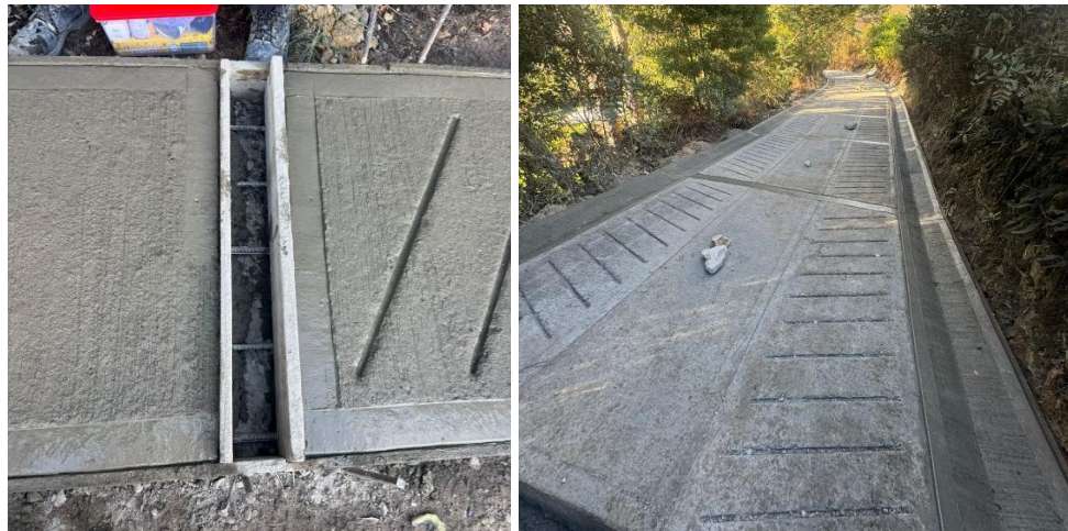
Ilustración No. 5 – Fundida de concreto clase D ( f'c = 3000 psi) para vigas de amarre Fuente: elaboración Propia
