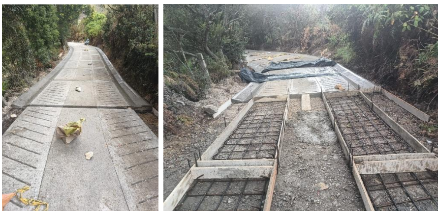
Ilustración No. 6 –Construcción de cunetas laterales y descoles Fuente: elaboración Propia
