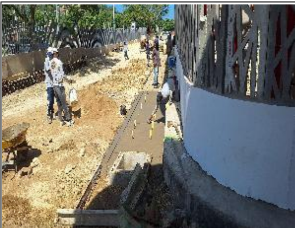
CONSTRUCCIÓN DE BORDILLO PARA ANDENES EN CONCRETO
