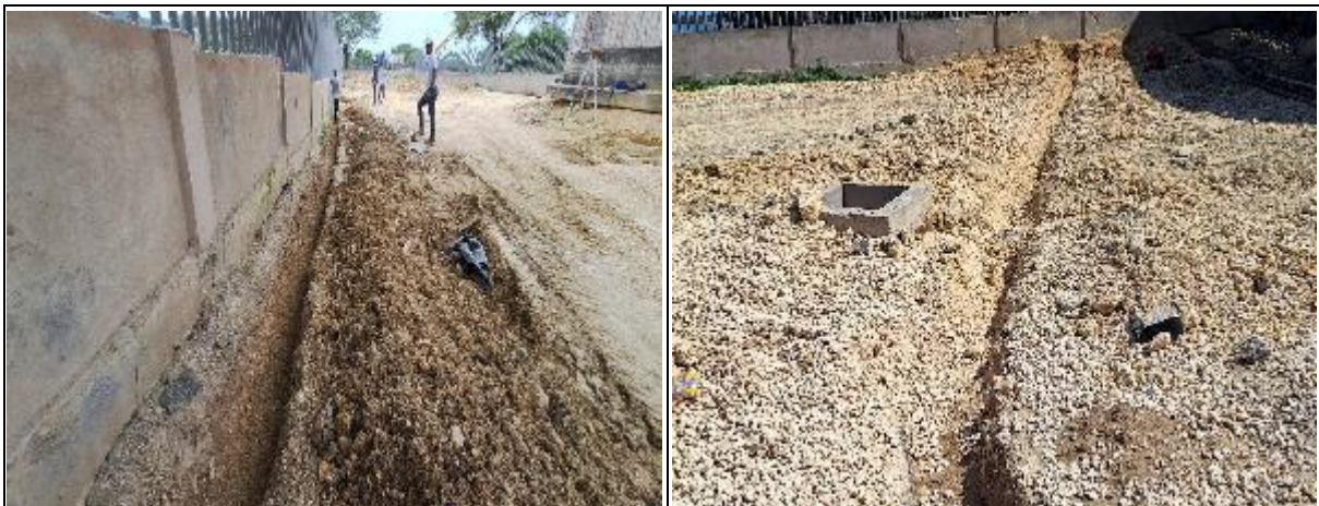
EXCAVACIÓN MANUAL EN TERRENO NATURAL
