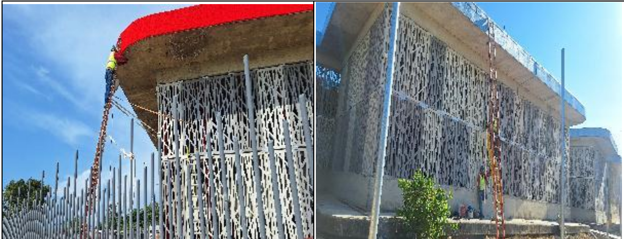
SUMINISTRO E INSTALACION DE REFLECTORES
