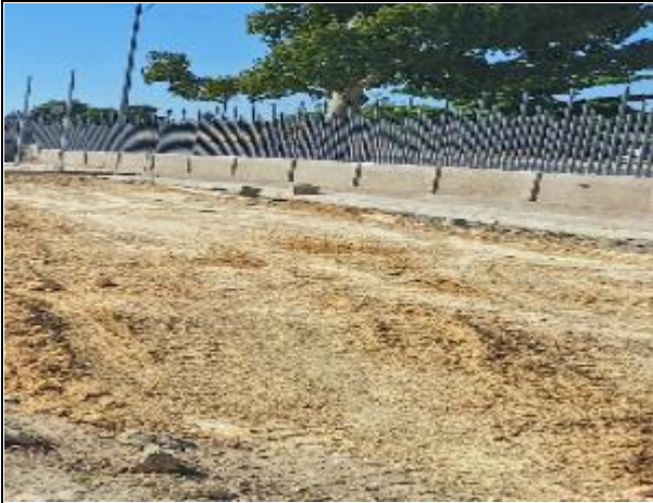
RELLENO Y COMPACTACIÓN CON MATERIAL DE SELECCIONADO
