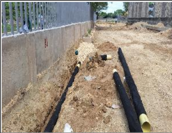
RED DE DRENAJE EN TUBERÍA DE 4" CON PERFORACIONES RECUBIERTO EN GEOTEXTIL
