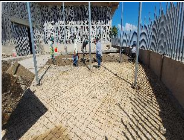
SUMINISTRO E INSTALACION DE TUBERÍA DE SOPORTE PARA LONAS
