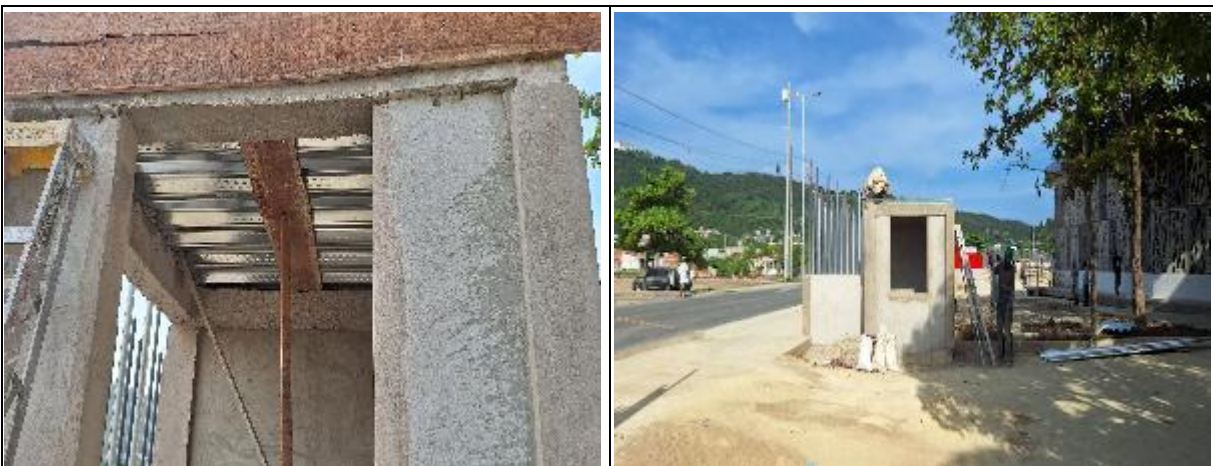
CONSTRUCCIÓN DE PLACA EN CONCRETO CON BASE INFERIOR EN METALDECK 2" CAL
