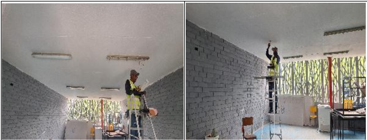
INSTALACIÓN DE LAMPARAS HERMETICAS
