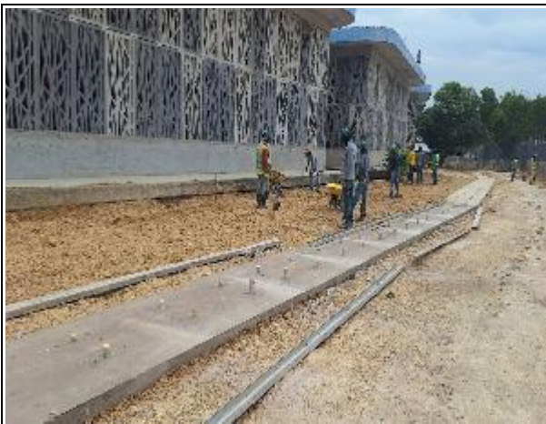
RELLENO Y COMPACTACIÓN CON MATERIAL DE SELECCIONADO
