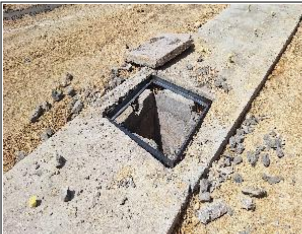
CONSTRUCCION DE REGISTRO DE AGUAS LLUVIAS
