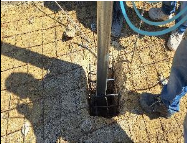
CONSTRUCCIÓN DE PEDESTALES EN CONCRETO
