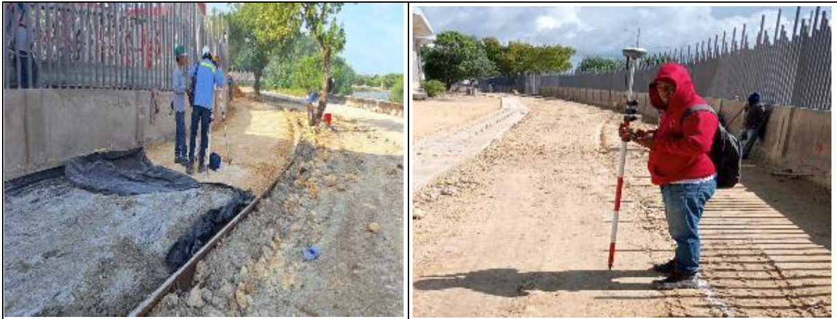
NIVELACIÓN, TRAZADO Y REPLANTEO DEL TERRENO
