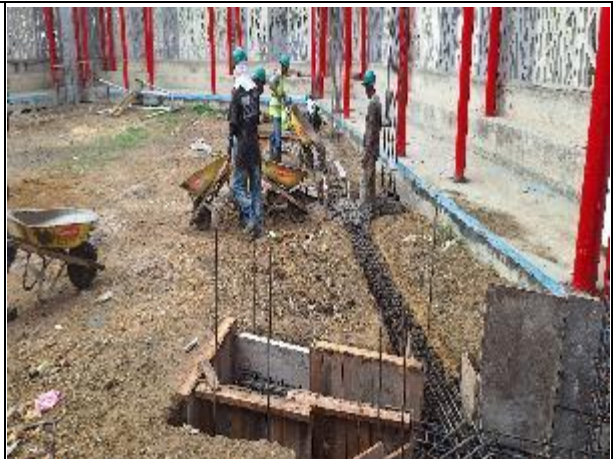
CONCRETO 4000 PSI PARA CIMENTACIÓN
