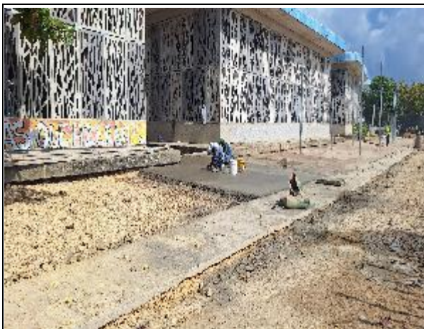
CONSTRUCCIÓN DE PLACA DE CONTRAPISO EN CONCRETO PSI (INCLUYE MALLA ELECTROSOLDADA)
