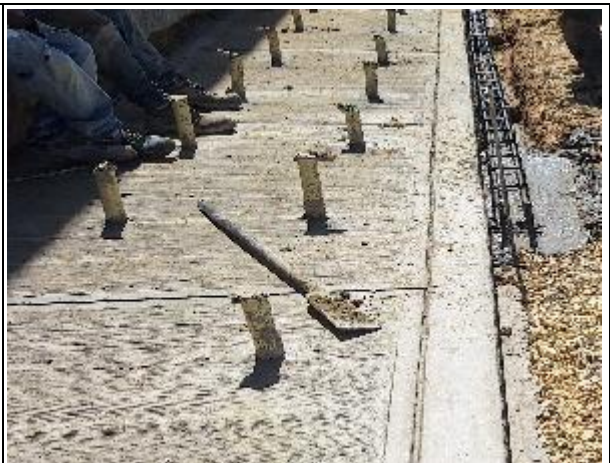
CONSTRUCCIÓN DE BORDILLO PARA ANDENES EN CONCRETO
