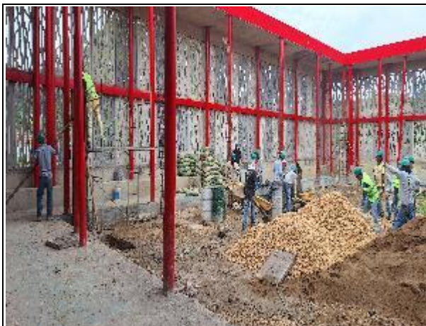
CONSTRUCCION DE COLUMNAS EN CONCRETO
