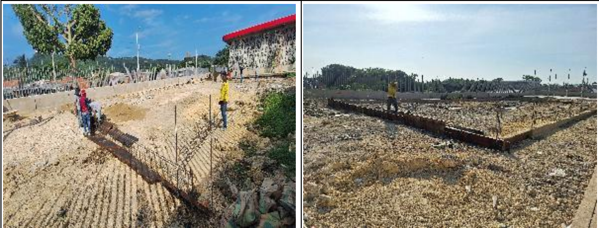
CONSTRUCCIÓN DE VIGA DE AMARRE INFERIOR EN CONCRETO
