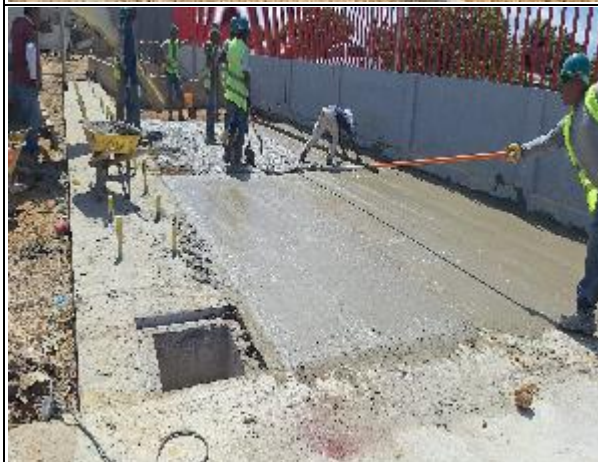
CONSTRUCCIÓN DE PLACA DE CONTRAPISO EN CONCRETO PSI (INCLUYE MALLA ELECTROSOLDADA)
