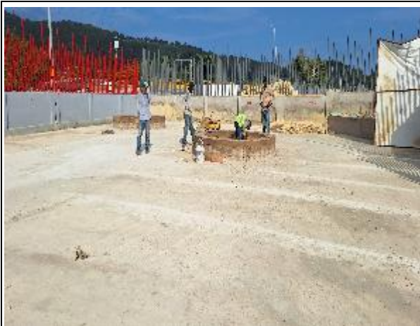
SUMINISTRO E INSTALACIÓN DE BANCAS CIRCULARES EN CONCRETO
