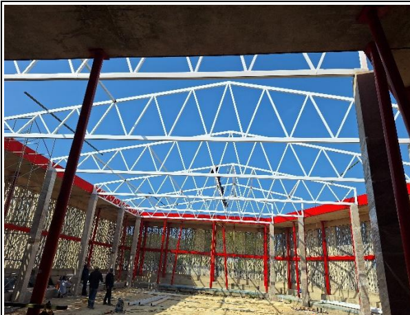
ESTRUCTURA METÁLICA COMPUESTA POR VIGAS EN PERFIL DE ALMA LLENA HEA ANCLADAS A PLACA BASE SOBRE COLUMNA DE CONCRETO EXISTENTE CON PERNO A193-B7.
