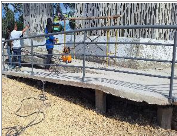
SUMINISTRO E INSTALACION BARANDA EN TUBERÍA METÁLICA 2"GALVANIZADA PARA RAMPA
