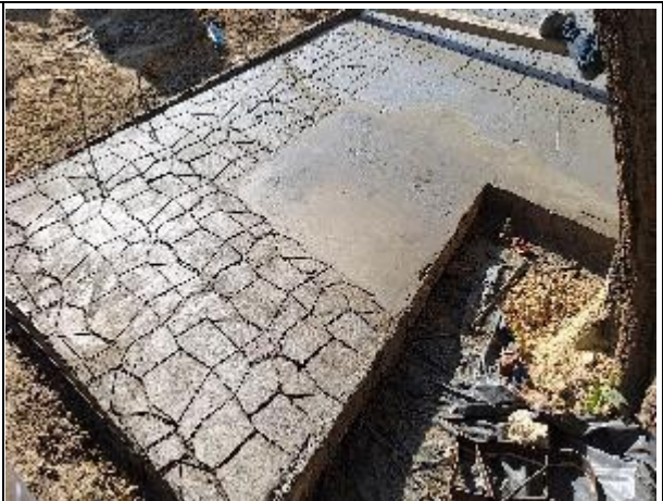
CONSTRUCCIÓN DE PLACA DE CONTRAPISO EN CONCRETO ESTAMPADO
