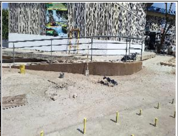
SUMINISTRO E INSTALACION BARANDA EN TUBERÍA METÁLICA 2"GALVANIZADA PARA RAMPA
