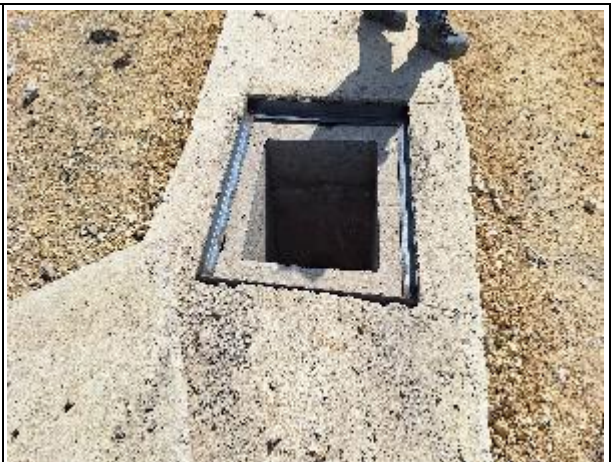
CONSTRUCCION DE REGISTRO DE AGUAS LLUVIAS
