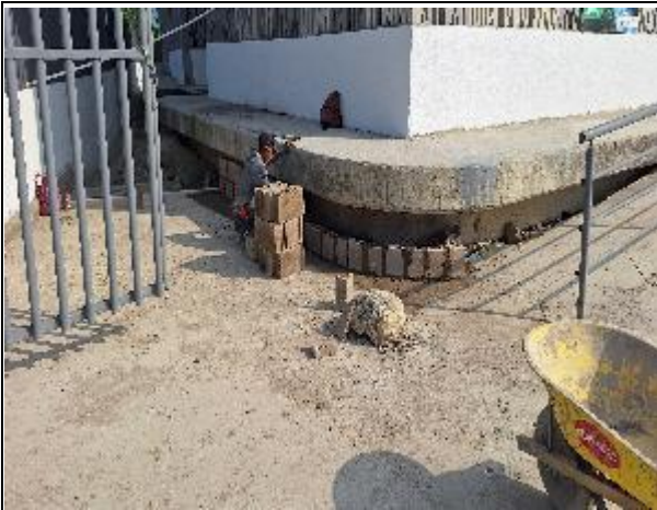
LEVANTE EN BLOCK No. 5
