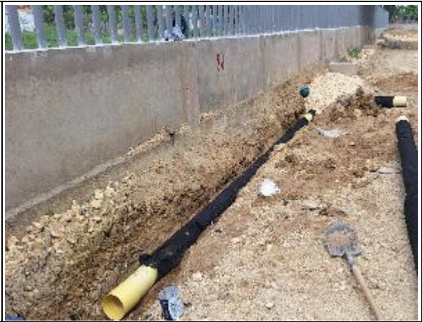
RED DE DRENAJE EN TUBERÍA DE 4" CON PERFORACIONES RECUBIERTO EN GEOTEXTIL
