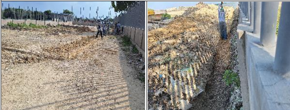
EXCAVACIÓN MANUAL EN TERRENO NATURAL
