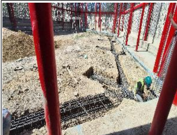
CONCRETO 4000 PSI PARA CIMENTACIÓN
