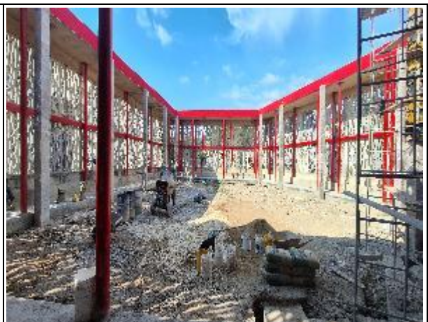
CONSTRUCCION DE COLUMNAS EN CONCRETO
