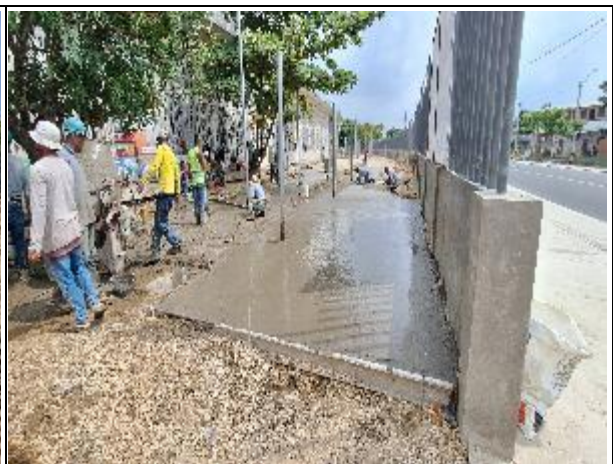
CONSTRUCCIÓN DE PLACA DE CONTRAPISO EN CONCRETO PSI (INCLUYE MALLA ELECTROSOLDADA)
