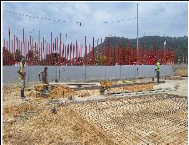
RELLENO Y COMPACTACIÓN CON MATERIAL DE SELECCIONADO
