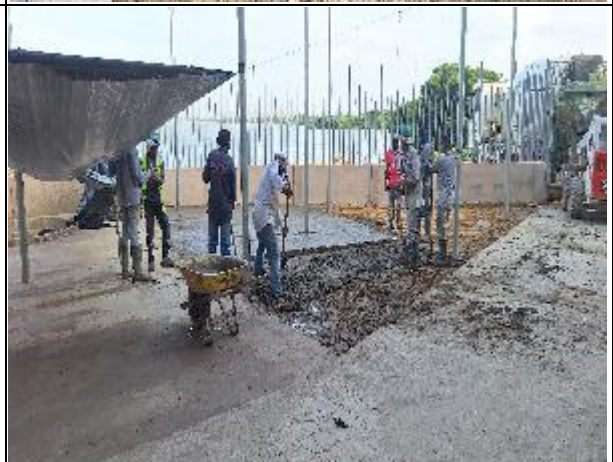
CONSTRUCCIÓN DE PLACA DE CONTRAPISO EN CONCRETO PSI (INCLUYE MALLA ELECTROSOLDADA)
