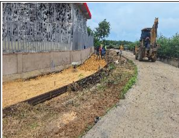
RELLENO Y COMPACTACIÓN CON MATERIAL DE SELECCIONADO
