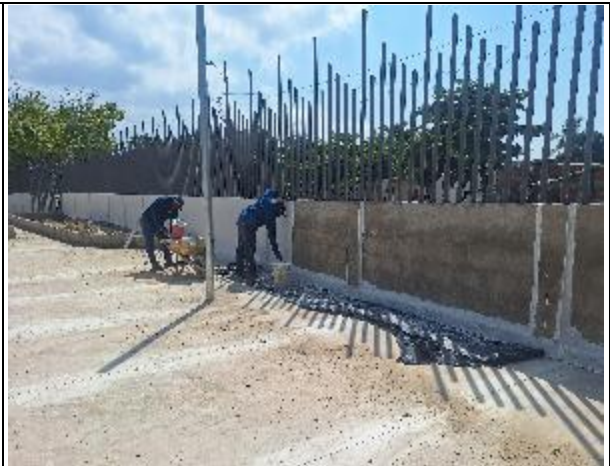
APLICACIÓN DE PINTURA PARA MUROS DE CERRAMIENTO
