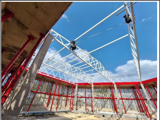
ESTRUCTURA METÁLICA COMPUESTA POR VIGAS EN PERFIL DE ALMA LLENA HEA ANCLADAS A PLACA BASE SOBRE COLUMNA DE CONCRETO EXISTENTE CON PERNO A193-B7.
