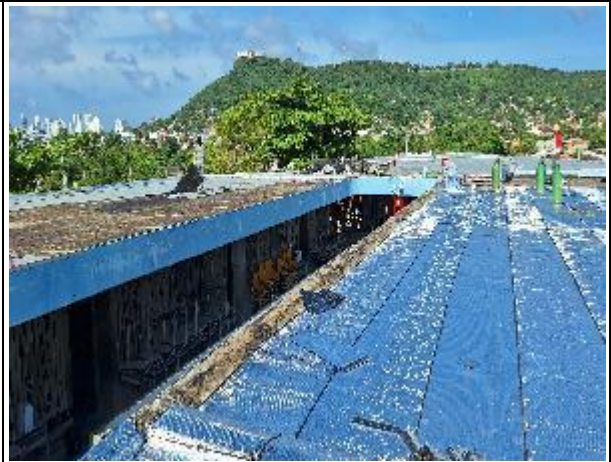
IMPERMEABILIZACION DE PLACA DE CUBIERTA CON MANTO ASFALTICO
