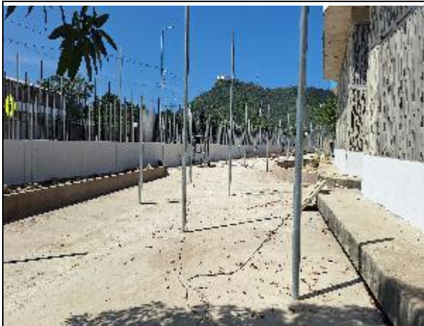
SUMINISTRO E INSTALACION DE TUBERÍA DE SOPORTE PARA LONAS
