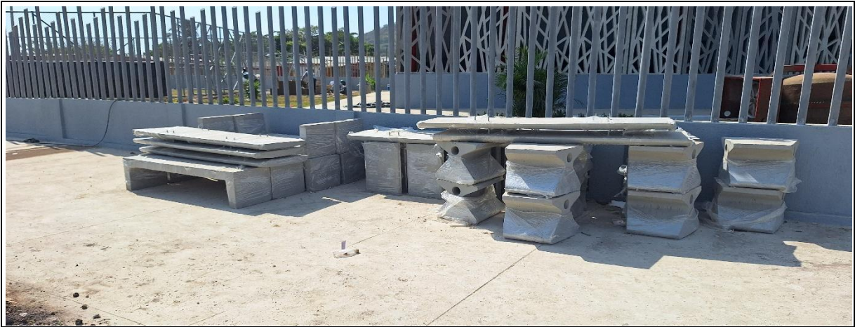
SUMINISTRO E INSTALACIÓN DE BANCAS EN CONCRETO SIN ESPALDAR
