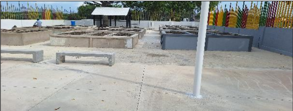
CONSTRUCCIÓN DE BANCAS EN CONCRETO DE ALTURA 0,40M
