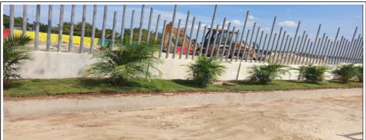
CONSTRUCCIÓN DE JARDINERAS
