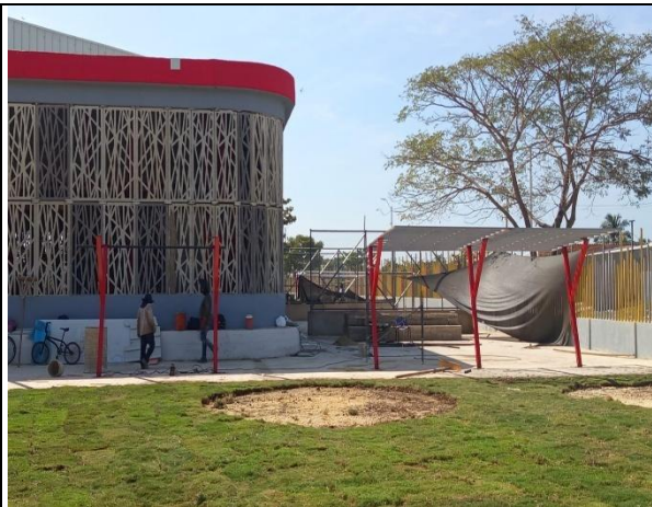
SUMINISTRO E INSTALACIÓN DE CUBIERTA EN CARPINTERÍA METÁLICA PARA ZONA DE DUGOUT
