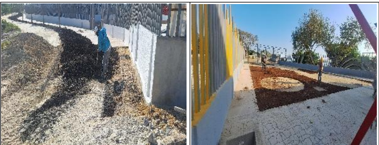
SUMINISTRO Y RELLENO DE TIERRA NEGRA
