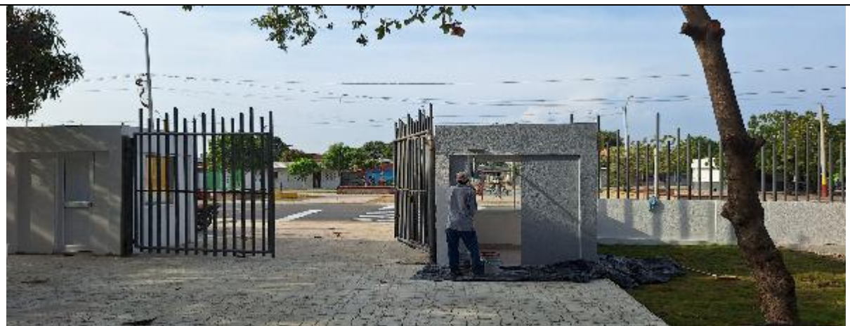
SUMINISTRO E INSTALACIÓN DE PUERTA DE ACCESO A CACETA EN ALUMINIO CON VISOR
