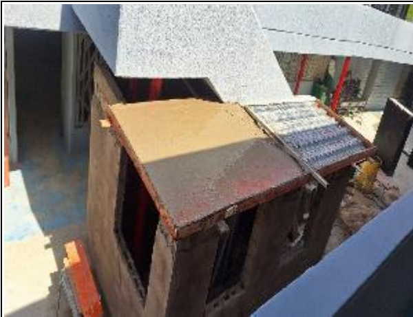
CONSTRUCCIÓN DE PLACA EN CONCRETO CON BASE INFERIOR EN METALDECK 2" CAL 20
