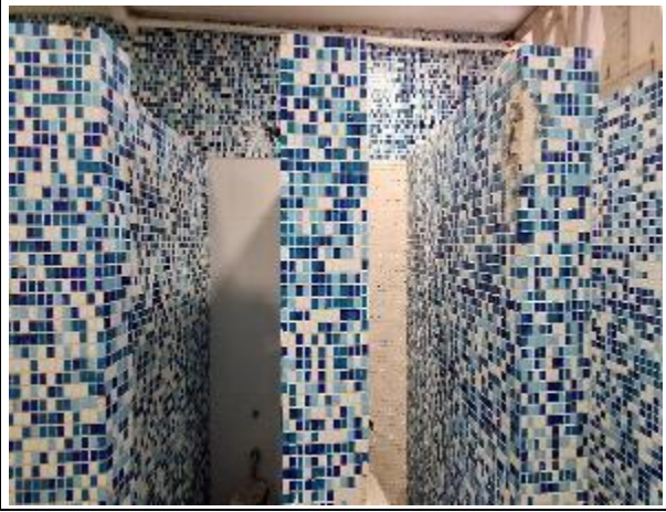
SUMINISTRO E INSTALACIÓN DE ENCHAPE DE BAÑOS
