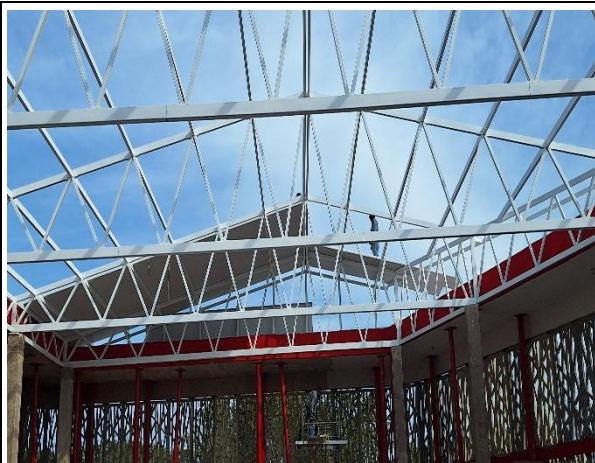
SUMINISTRO E INSTALACIÓN DE CUBIERTA EN TEJA TIPO SANDWICH
