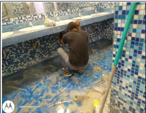
INTERVENCIONES HIDRAULICAS Y SANITARIAS
