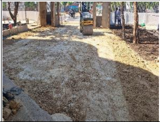
RELLENO Y COMPACTACIÓN CON MATERIAL DE SELECCIONADO
