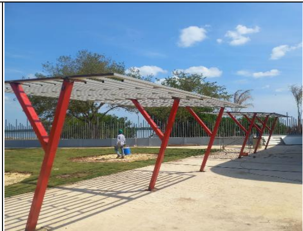
SUMINISTRO E INSTALACIÓN DE CUBIERTA EN CARPINTERÍA METÁLICA PARA ZONA DE DUGOUT
