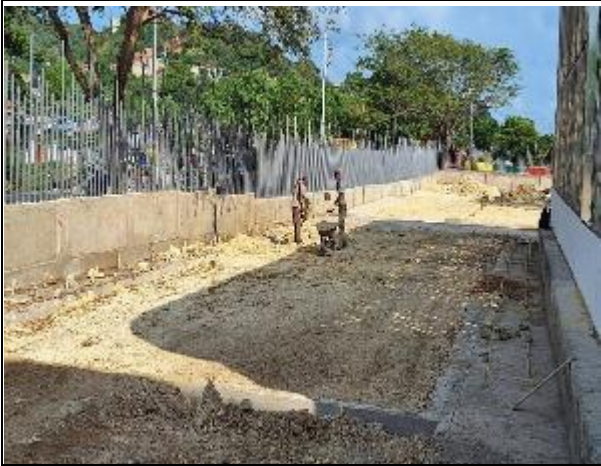
RELLENO Y COMPACTACIÓN CON MATERIAL DE SELECCIONADO
