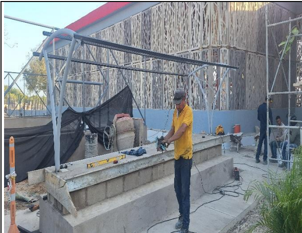
SUMINISTRO E INSTALACIÓN DE CUBIERTA METÁLICA PARA ÁREA DE GRADERÍAS,
