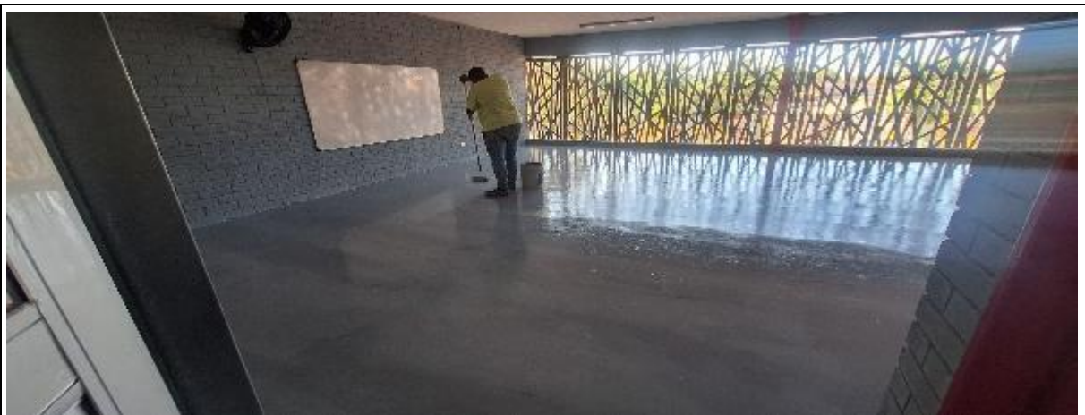
APLICACIÓN DE PINTURA DE TRAFICO SOBRE PLACAS EN CONCRETO
