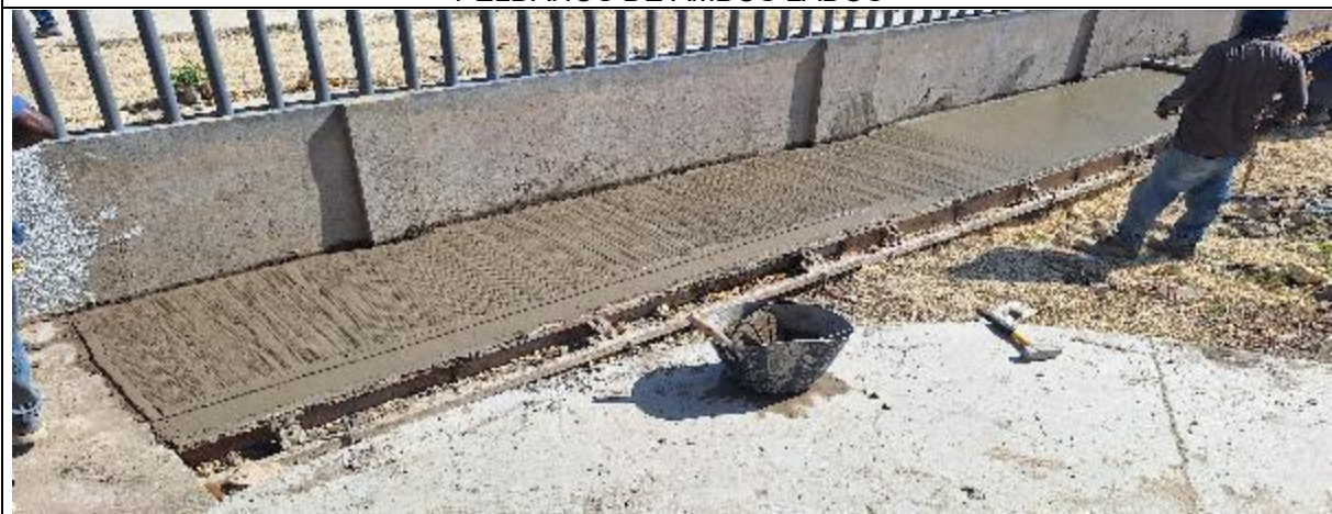
CONSTRUCCION DE ANDENES
