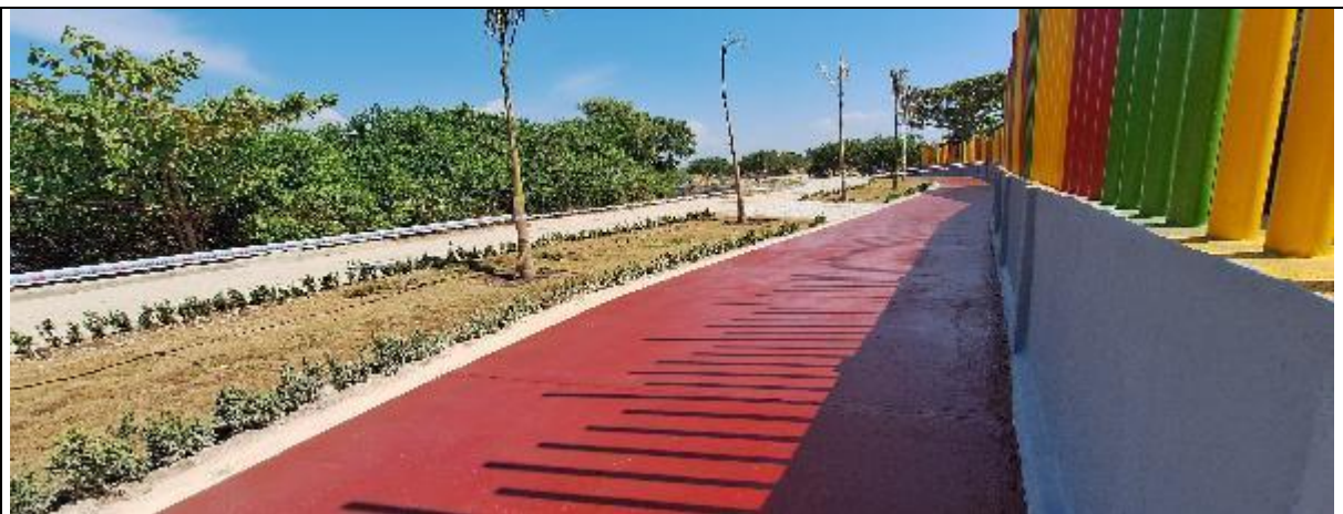
APLICACIÓN DE PINTURA DE TRAFICO PARA CICLOVÍA
