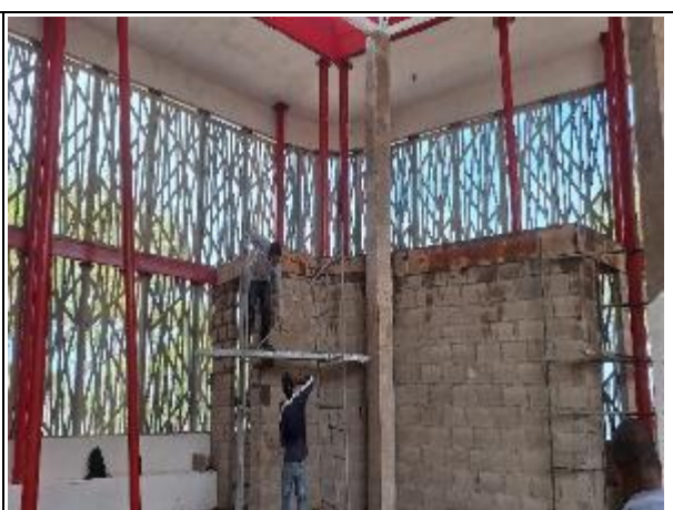
CONSTRUCCIÓN DE VIGA DE AMARRE SUPERIOR EN CONCRETO
