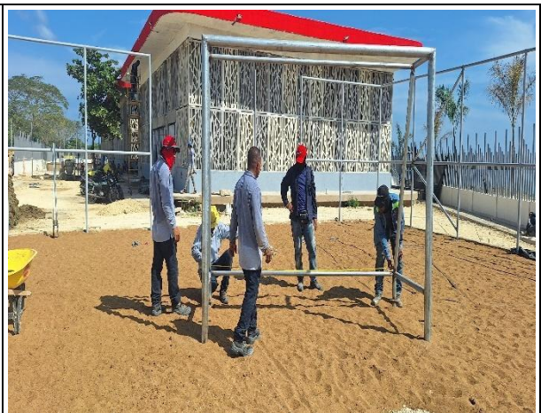
SUMINISTRO E INSTALACIÓN DE ARQUERÍAS
