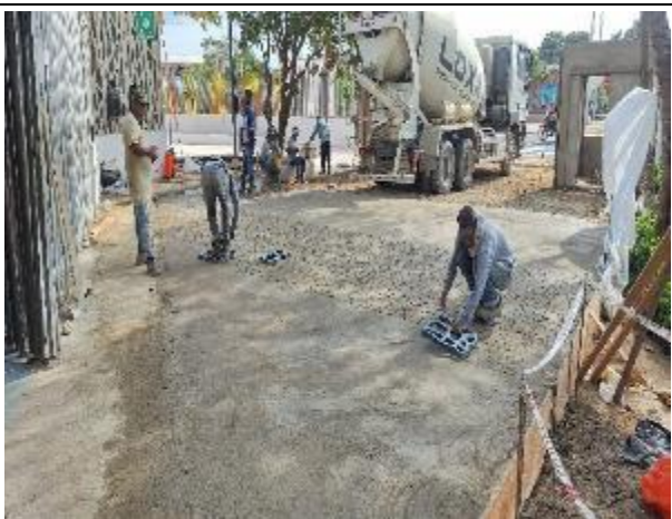
CONSTRUCCIÓN DE PLACA DE CONTRAPISO EN CONCRETO ESTAMPADO
