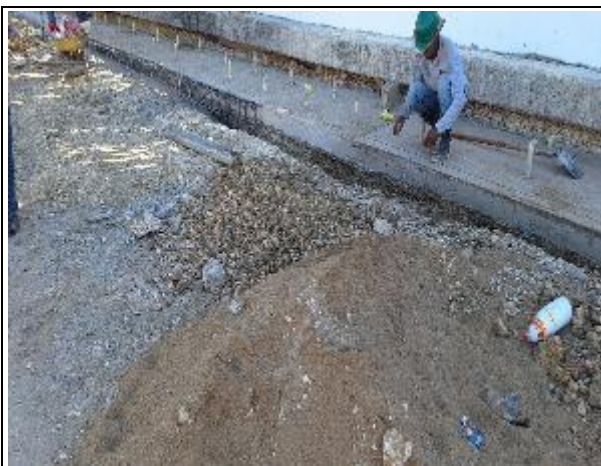
CONSTRUCCIÓN DE VIGA DE AMARRE INFERIOR EN CONCRETO
