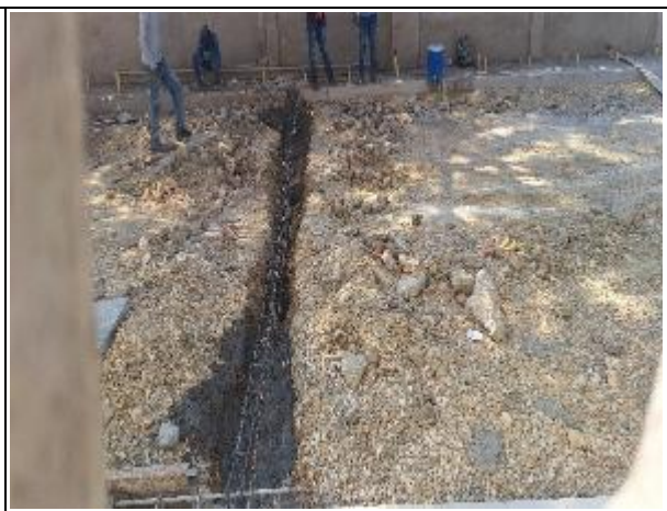
CONSTRUCCIÓN DE VIGA DE AMARRE INFERIOR EN CONCRETO
