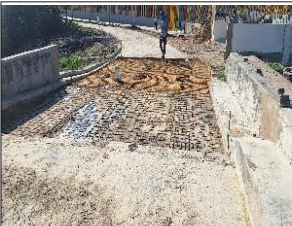
CONSTRUCCIÓN DE PLACA DE CONTRAPISO EN CONCRETO ESTAMPADO
