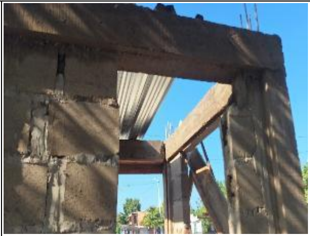
CONSTRUCCIÓN DE PLACA EN CONCRETO CON BASE INFERIOR EN METALDECK 2" CAL 20
