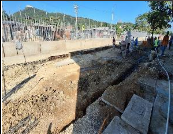
EXCAVACIÓN MANUAL EN TERRENO NATURAL
