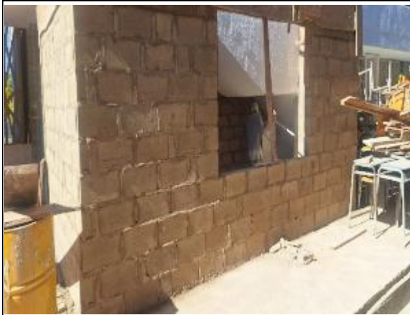
LEVANTE EN BLOCK No. 5
