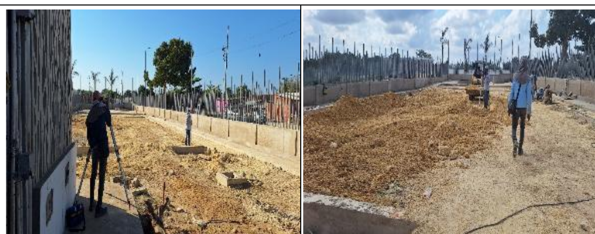
NIVELACIÓN, TRAZADO Y REPLANTEO DEL TERRENO
