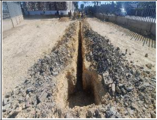
EXCAVACIÓN MANUAL EN TERRENO NATURAL
