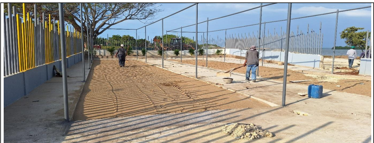
SUMINISTRO E INSTALACIÓN DE JAULA DE BATEO EN TUBERÍA METÁLICA Y MALLA ESLABONADA
