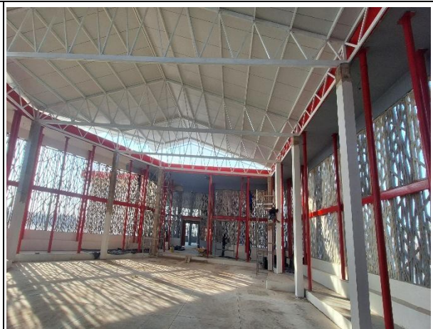
SUMINISTRO E INSTALACIÓN DE CUBIERTA EN TEJA TIPO SANDWICH
