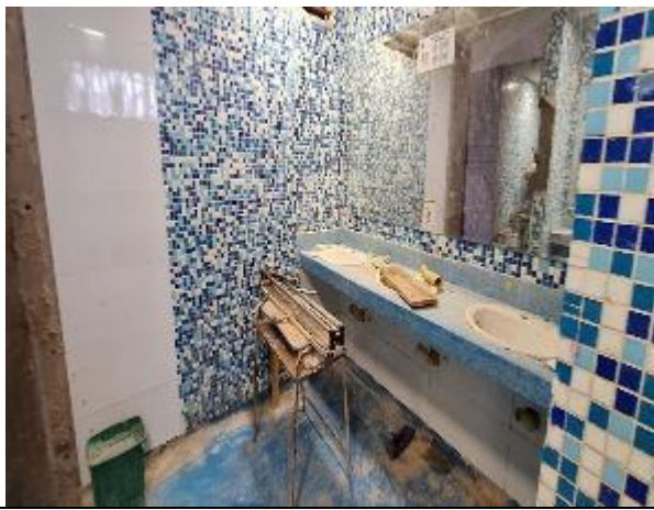
SUMINISTRO E INSTALACIÓN DE ENCHAPE DE BAÑOS
