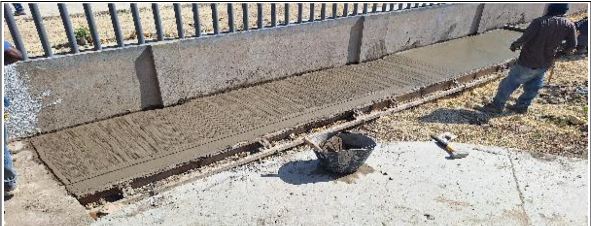
CONSTRUCCIÓN DE BORDILLO PARA ANDENES EN CONCRETO
