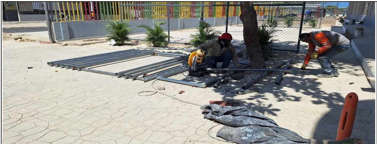
SUMINISTRO E INSTALACION DE PORTONES EN TUBERIA GALVANIZADA DE 2
