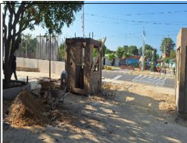
CONSTRUCCIÓN DE VIGA DE AMARRE SUPERIOR EN CONCRETO
