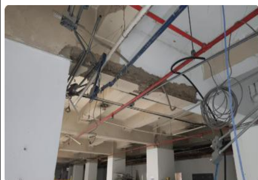
Desmante sistema de detección antiguo gimnasio
