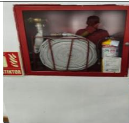
Inspección de elementos de gabinete p4 San Agustín
