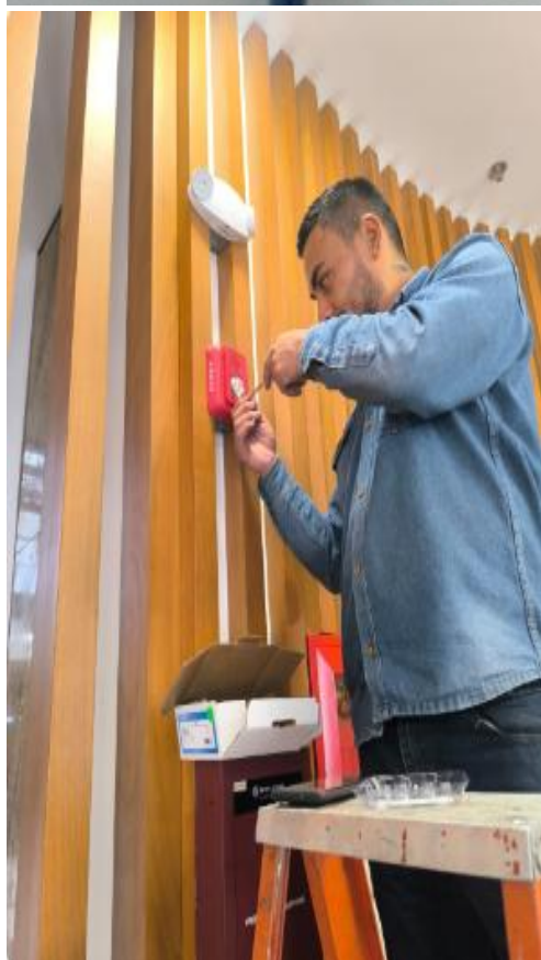
Se instala sirena y strobe recepción calle 7 recepción nueva
