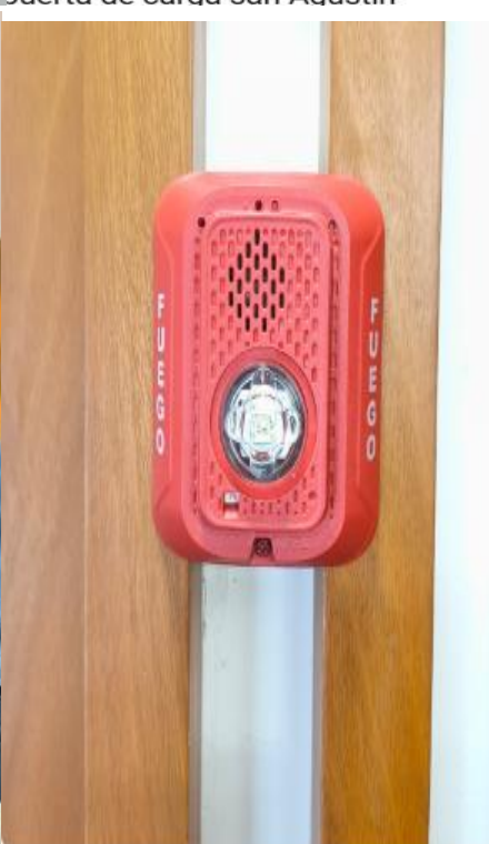
Se instala sirena y strobe recepción calle 7 recepción nueva
