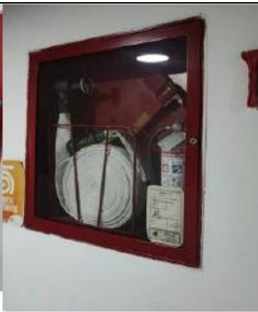
Elementos gabinete tipo 1 sótano
