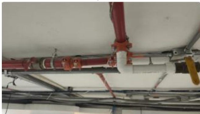
Rci costado norte sótano suspendido y drenado correspondiente
