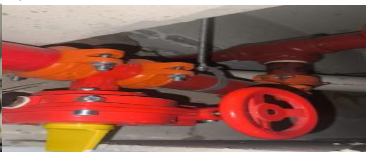
Rci costado norte sótano suspendido y drenado correspondiente
