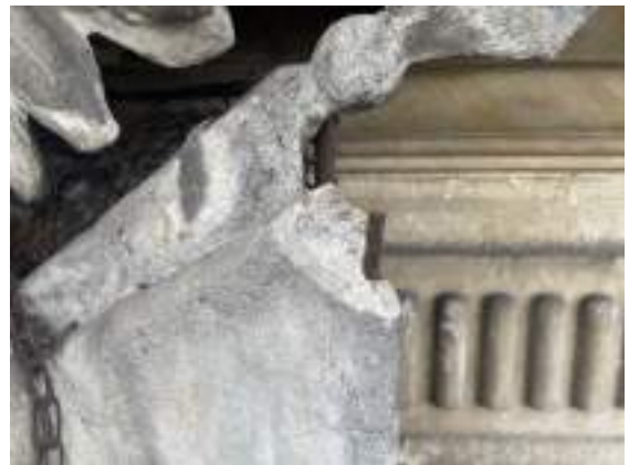
Ilustración 23 Fotografía detalle de escudo en fachada principal, 2025. Fuente: Consorcio Interhospital PAC
