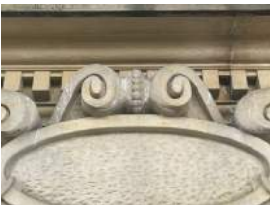
Ilustración 17 Fotografía detalle de medallones en fachada principal, 2025. Fuente: Consorcio Interhospital PAC
