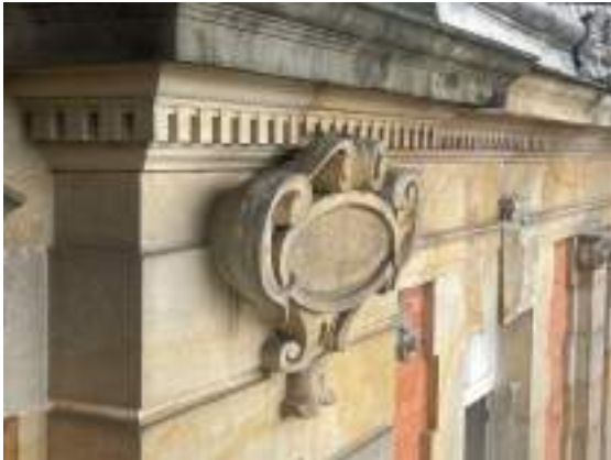
Ilustración 26 Fotografía detalle de medallones en fachada principal, 2025. Fuente: Consorcio Interhospital PAC
