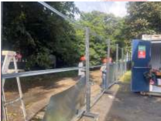
Ilustración 7 Fotografía construcción de cerramiento de obra, 2025. Fuente: Consorcio Interhospital PAC.
