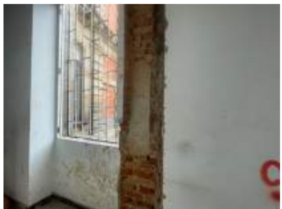
Ilustración 11 Fotografía corte y escarificación de muros en primer nivel para reforzamiento estructural, 2025. Fuente: Consorcio Interhospital PAC.
