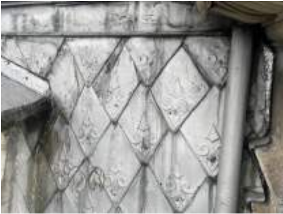
Ilustración 32 Fotografía detalle de tejas de mansarda en fachada principal, 2025. Fuente: Consorcio Interhospital PAC.
