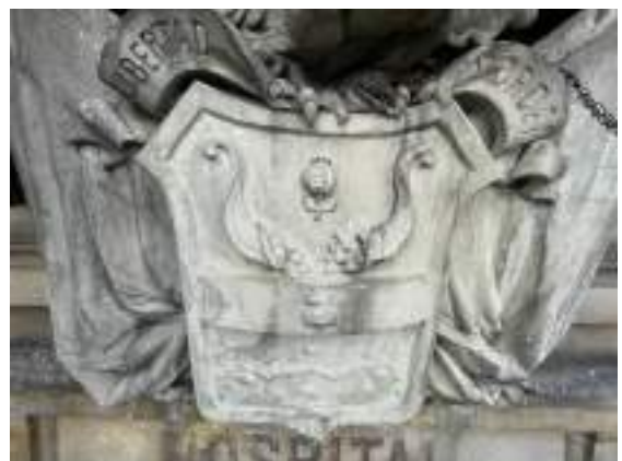
Ilustración 21 Fotografía detalle de escudo en fachada principal, 2025. Fuente: Consorcio Interhospital PAC
