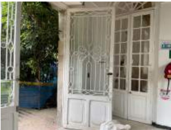
Ilustración 30 Fotografía desmonte de puertas costado sur primer nivel, 2025. Fuente: Consorcio Interhospital PAC.
