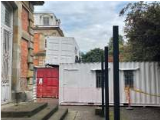
Ilustración 8 Fotografía adecuación de contenedores para campamentos, 2025. Fuente: Consorcio Interhospital PAC.
