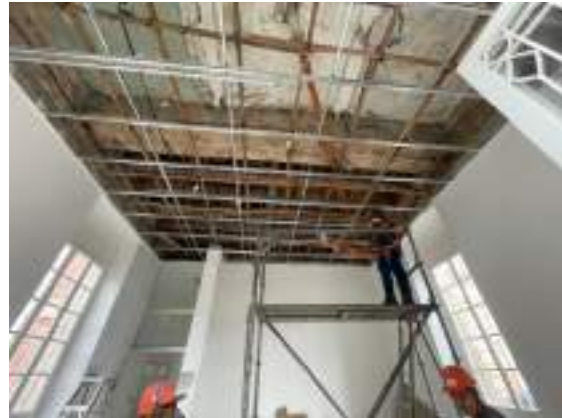
Ilustración 19 Fotografía desmonte de cielorraso en primer nivel, 2025. Fuente: Consorcio Interhospital PAC
