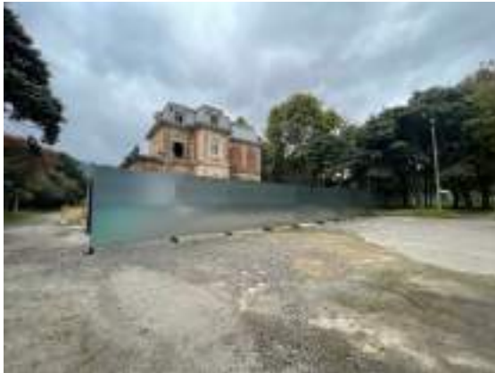
Ilustración 12 Fotografía construcción de cerramiento de obra, 2025. Fuente: Consorcio Interhospital PAC.
