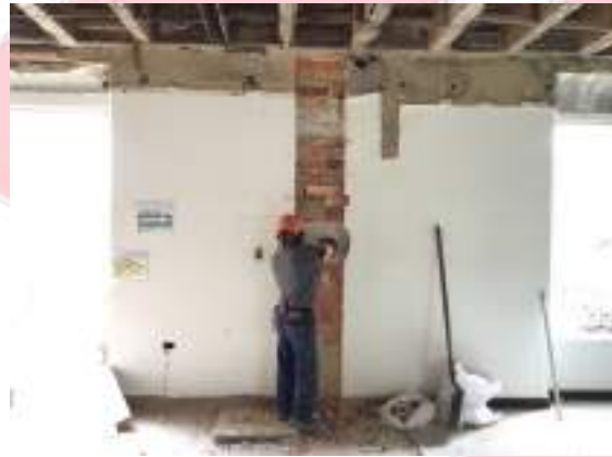
Ilustración 28 Fotografía de corte y escarificación para elementos del reforzamiento estructural, 2025. Fuente: Consorcio Interhospital PAC.
