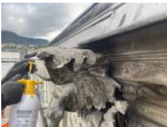
Ilustración 22 Fotografía limpieza preliminar de escudo en fachada principal, 2025. Fuente: Consorcio Interhospital PAC
