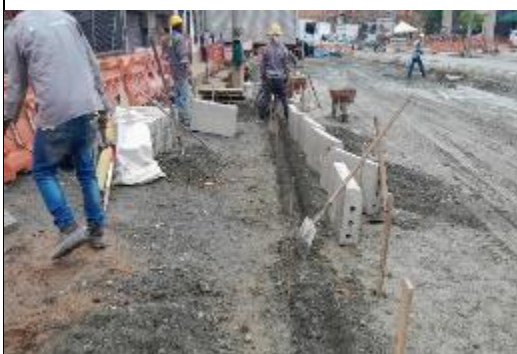
FOTO 23: Instalación de cordonería sector Laproff para conformación de urbanismo
