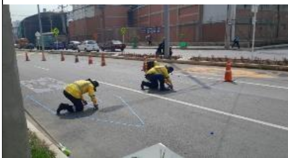
FOTO 28. Instalación de pintura plástica en frío para marcas viales
