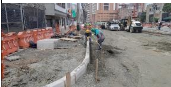
FOTO 30. Conformación y construcción de andén sector Al Sur
