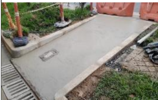
FOTO 21. Construcción rampa de acceso predio ID 47
