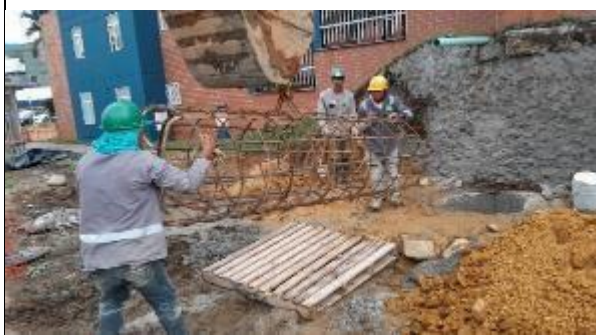
FOTO 54. Instalación de acero para pilas
