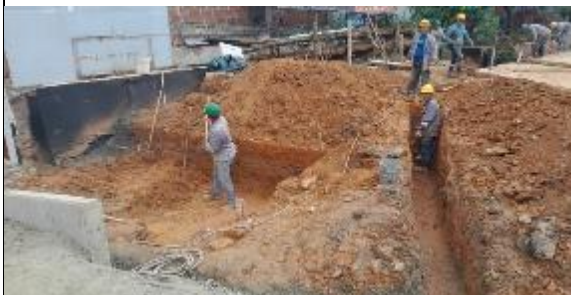
FOTO 39. Excavación para instalación de viaducto en el puente
