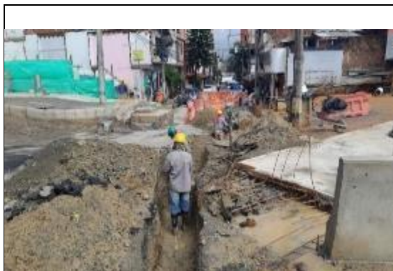
Foto 1: Excavación manual para retiro red de gas alta presión calle 62s
