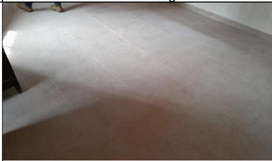
FOTO 68. Instalación de cerámica predio ID47
