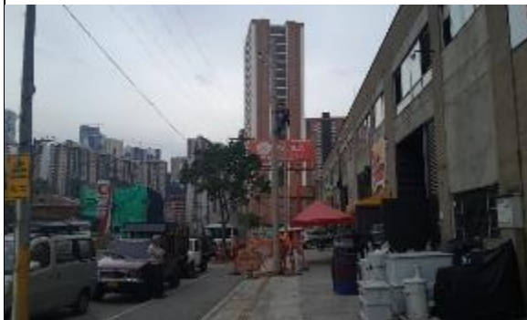
FOTO 26. Instalación postes red de media tensión sector caseritas
