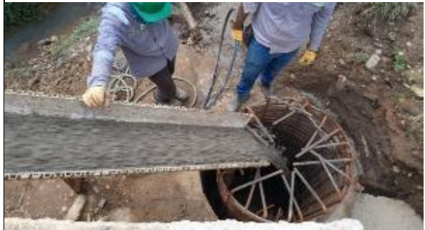
Foto 8: Instalación de acero de concreto para pila de apoyo viaducto
