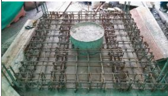
FOTO 50. Construcción de cámara de telecomunicación calle 61s
