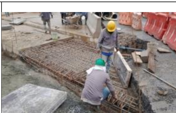
FOTO 20. Construcción de losa de aproximación eje 1 puente calzada norte sur
