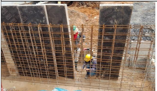
FOTO 67. Instalación de acero de refuerzo para muro de contención calle 62s
