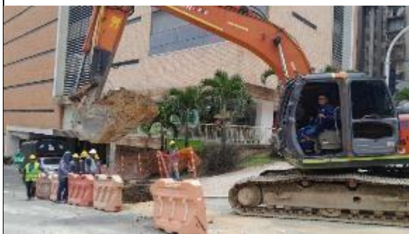
FOTO 22.: Excavación y construcción cámara de telecomunicación calle 61s
