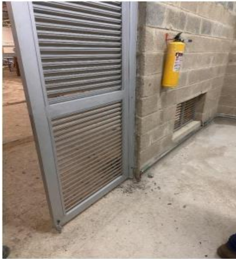
Equipotencializar o “aterizar” el ala de puerta de acceso.
