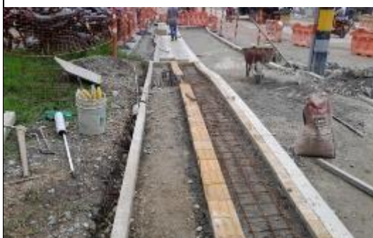
Foto 18: Conformación de urbanismo sector Caseritas
