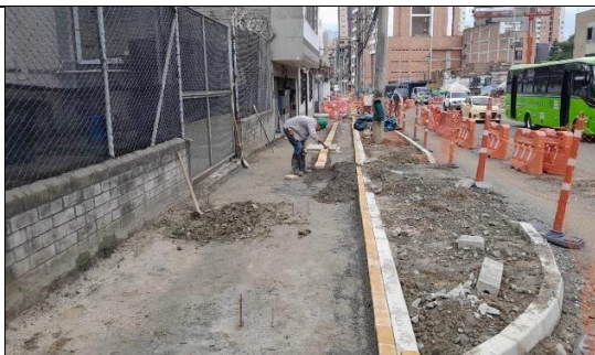
FOTO 66. Instalación de guía táctil sector Laproff
