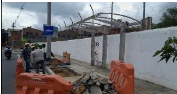
FOTO 48. Instalación de paradero de buses sector Alcázares
