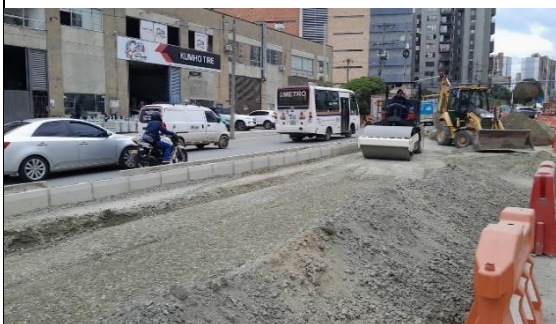
FOTO 59. Conformación de estructura de pavimento sector Spin
