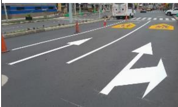
FOTO 24. Instalación de pintura plástica en frío para marcas viales
