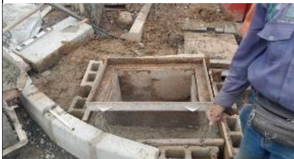
FOTO 40. Construcción cajas red de telecomunicación sector Laproff
