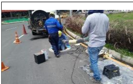
FOTO 41. Reparación redes de alcantarillado
