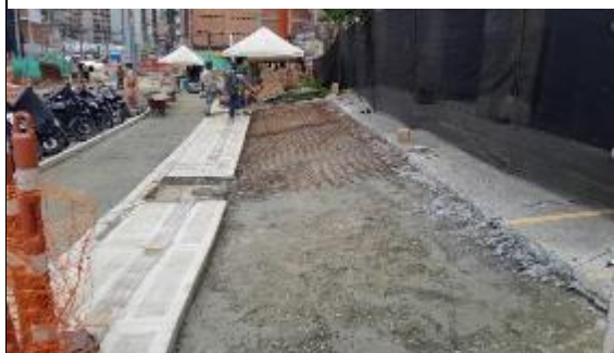
FOTO 45. Conformación de andén sector Caseritas
