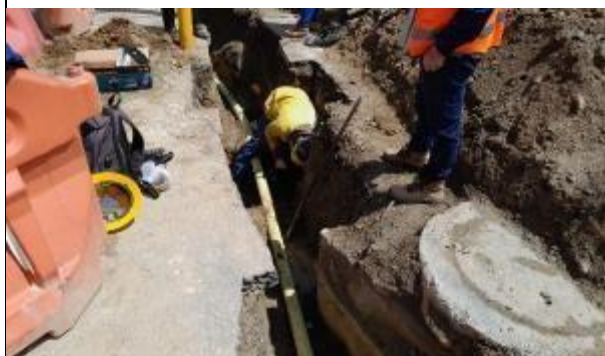
Foto 12: Corte y retiro de red de gas de alta presión calle 62s
