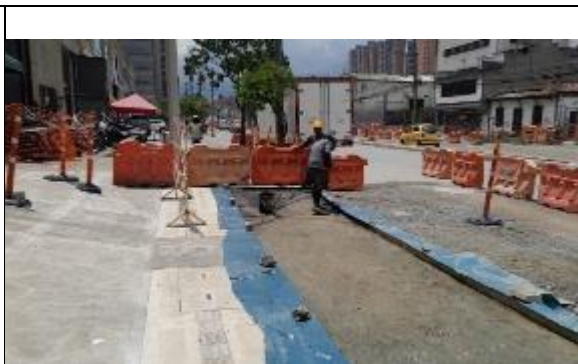
FOTO 58. Instalación de imprimante para mezcla asfáltica ciclorruta caseritas
