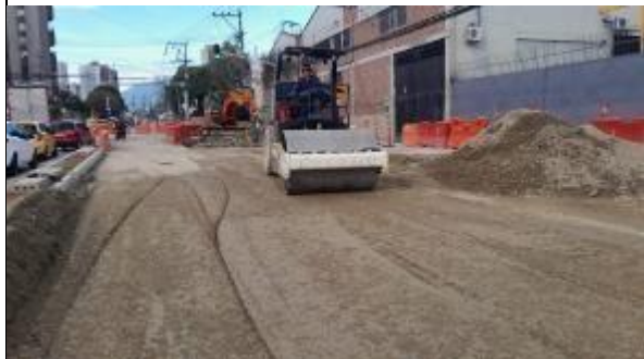
Foto 10: Extensión y compactación de base granular para conformación de estructura de pavimento
