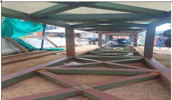
FOTO 76. Construcción de estructura metálica para viaducto
