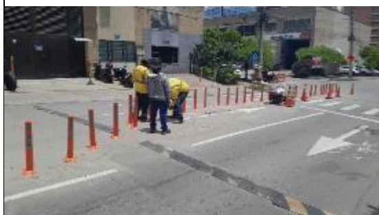
FOTO 43. Instalación de hitos calle 61s
