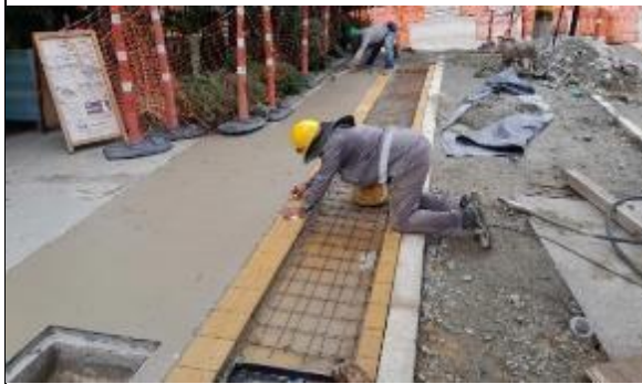
Foto 2: Construcción de andenes sector Catalán
