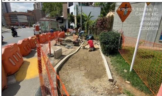
FOTO 75. Adecuación de andenes sector Porcicarnes
