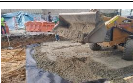
FOTO 42. Extensión y compactación de base granular sector Al Sur
