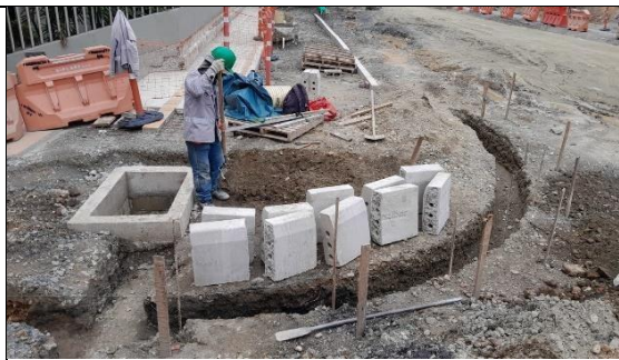
FOTO 74. Construcción de acceso unidad Al Sur
