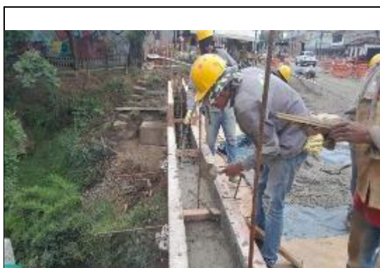
FOTO 25. Construcción viga de confinamiento puente calzada norte sur
