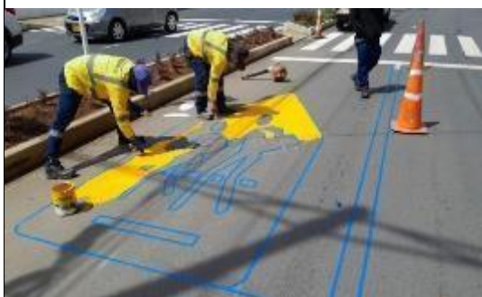
Foto 6: Instalación de pintura plástica en frío para marcas viales
