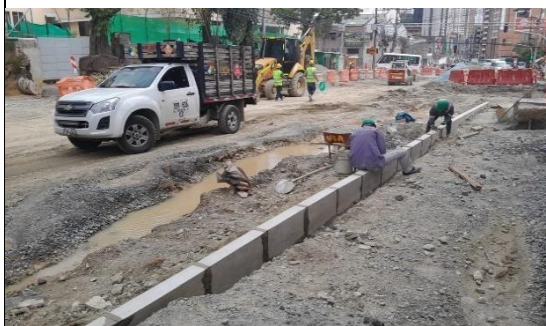
FOTO 62. Instalación de cordonería confinamiento en vía sector Al Sur
