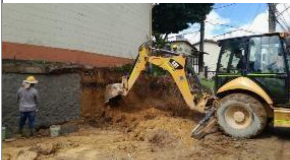
FOTO 47. Perfilación de talud San Antonio 1
