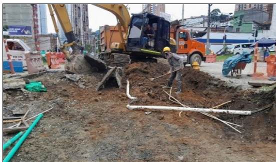
FOTO 73. Demolición de carpeta asfáltica y excavación para construcción de estructura de pavimento calle 60bs-60s
