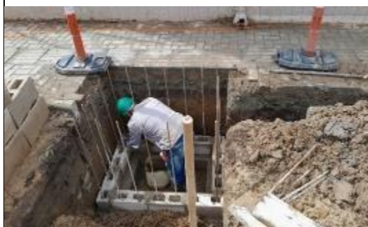
Foto 5: Construcción redes de telecomunicación sector Terpel
