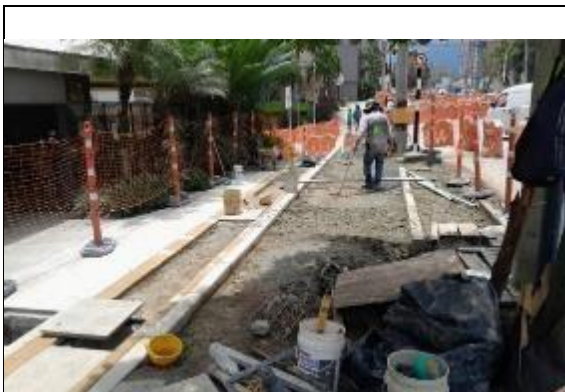
FOTO 19. Conformación de estructura de ciclorruta sector Catalán
