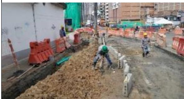
Foto 4: Instalación de cordonería para confinamiento de estructura de pavimento
