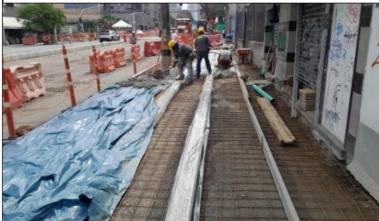
FOTO 69. Construcción de andenes sector Laproff
