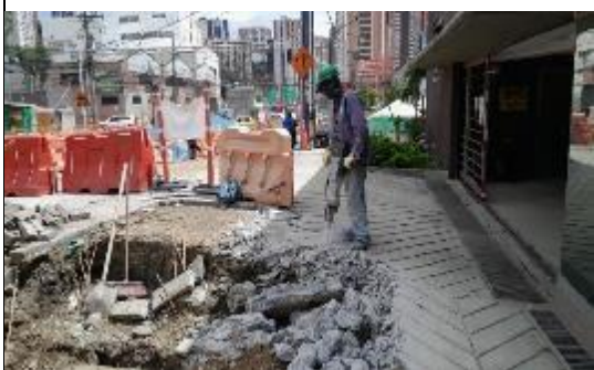
FOTO 53. Demolición de andén existente sector Al Sur
