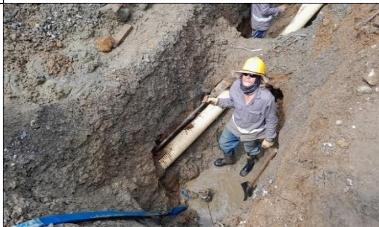
FOTO 70. Construcción red de acueducto de 200 mm calle 60bs-60s
