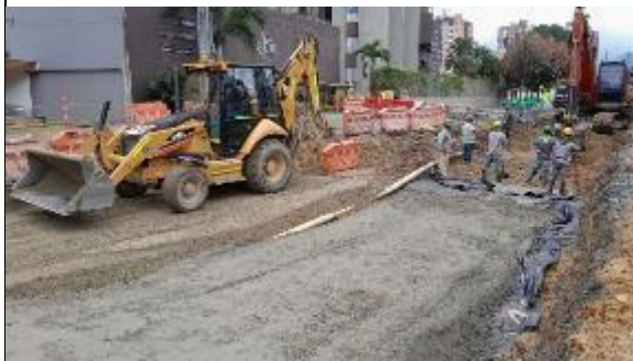
FOTO 32. Extensión y compactación de base granular para estructura de pavimento sector Al Sur
