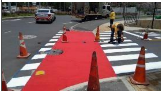
Foto 3: Instalación de pintura plástica en frío para marcas viales
