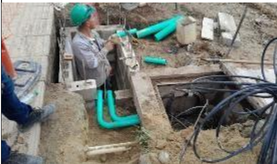
Foto 9: Construcción redes de telecomunicación sector Al Sur
