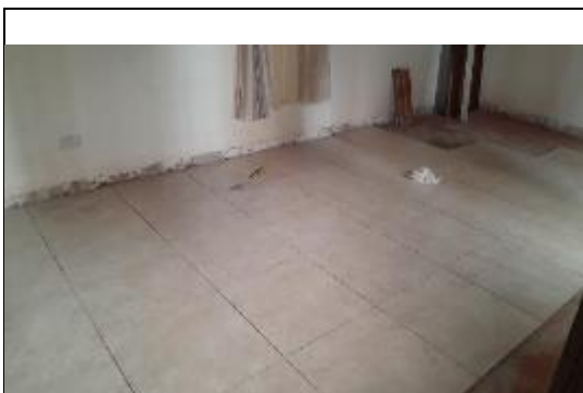
FOTO 49. Instalación de cerámica predio ID 47
