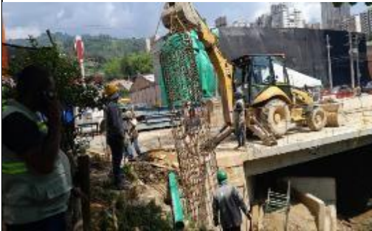
Foto 7: Instalación de acero de refuerzo para pila de apoyo viaducto
