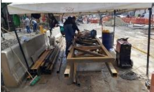
FOTO 51: Construcción de viaducto puente
