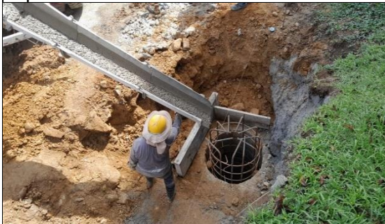
FOTO 71. Construcción de pilas para muro de
