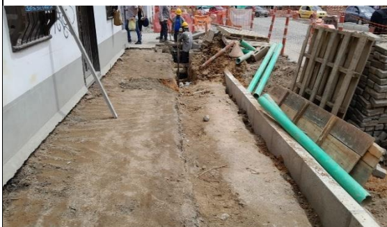
FOTO 61. Excavación y conformación de andenes sector Laproff
