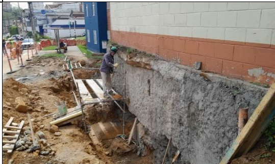
FOTO 72. Estabilización talud San Antonio 1
