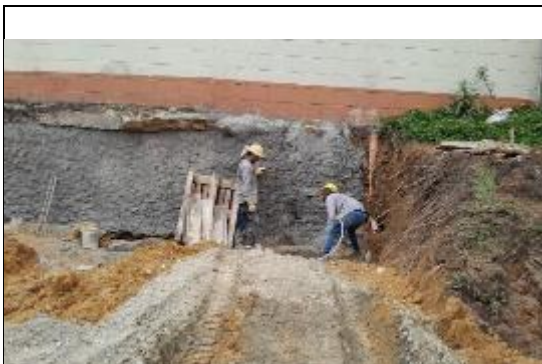
FOTO 57. Instalación de concreto para pilas San Antonio 1
