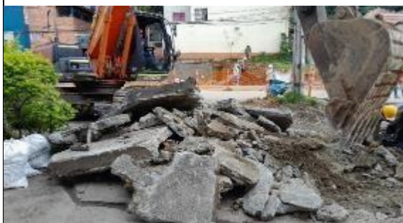
FOTO 46. Demolición de carpeta asfáltica calle 60bs
