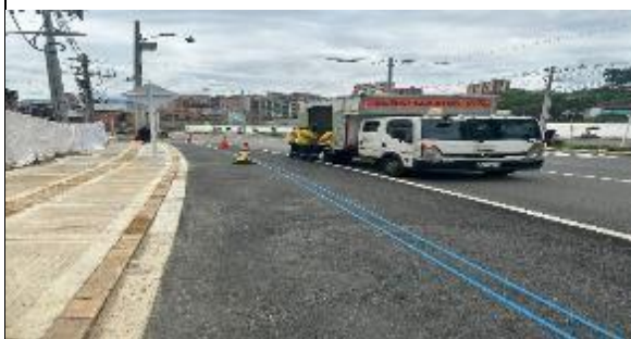
FOTO 44: Instalación marcas viales ciclorruta
