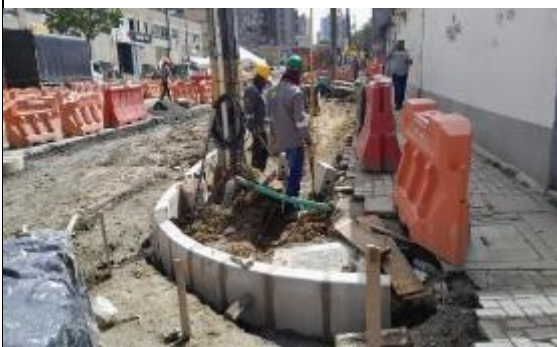
Foto 11: Instalación de cordonería para ingreso EDS Terpel
