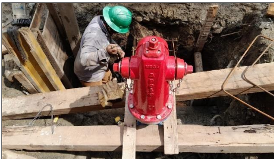
FOTO 65. Instalación de hidrante
