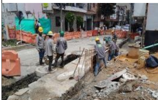
Foto 17: Construcción de muro de contención para andén calle 62s
