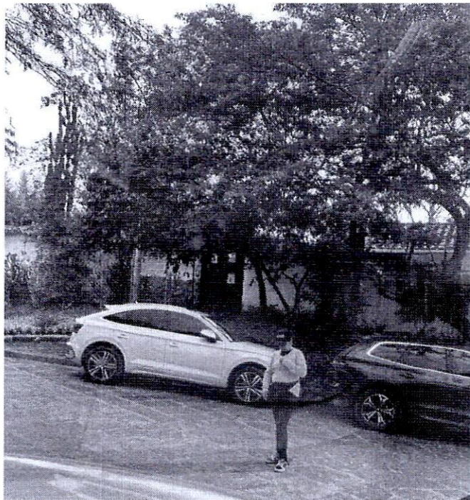
Punto 10. Regulador ubicado en el sector Santa Bárbara.
