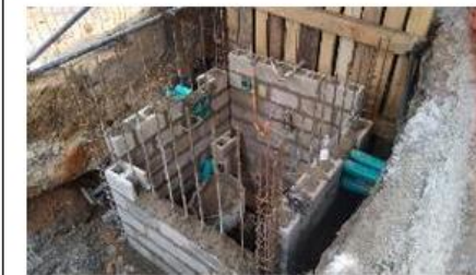
Foto 14: Construcción de cámara de telecomunicaciones en calle 56 sur
