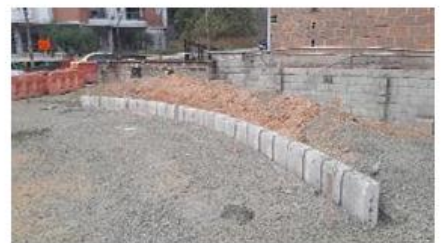
Foto 9: Instalación de bordillos sector retorno
