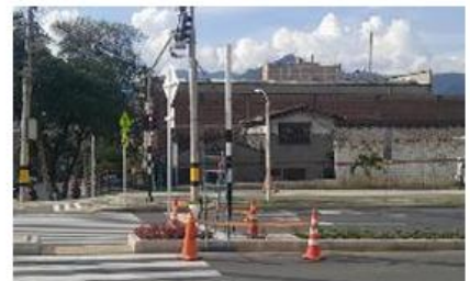
Foto 15: Instalación de semáforo separador central Espacio Óptimo
