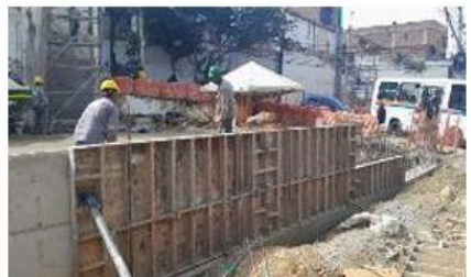
Foto 13: Construcción de muro de contención separador central sector retorno
