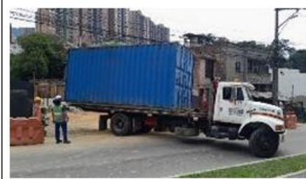
Foto 16: Traslado de contenedor para predio ID 6
