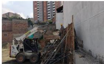
Foto 11: Vaciado de muro de limpieza sector retorno
