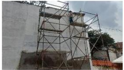
Foto 10: Adecuación de fachadas sector retorno
