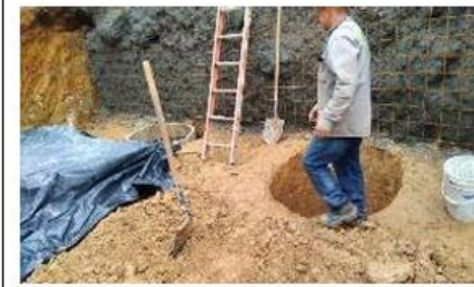
Foto 12: Excavación de pilas para muro de contención sector retorno
