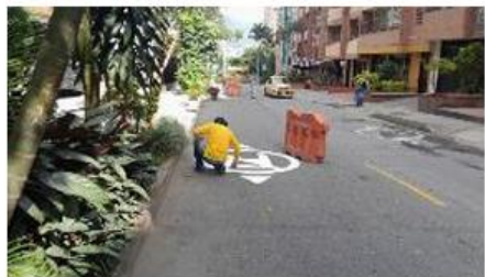
Foto 7: Implementación de PMT para redes hidrosanitarias calle 57 sur
