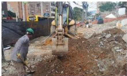
Foto 5: Excavación y nivelación para conformación de vía sector ID 19,20,21
