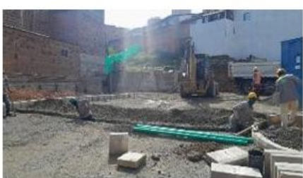
Foto 8: Instalación de tubería para redes eléctricas sector retorno
