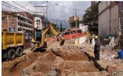
Foto 6: Excavación y nivelación para conformación de vía sector ID 19,20,21
