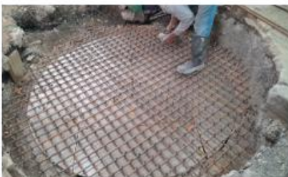
FOTO 33. Construcción de MH's para reposición de la red de aguas lluvias calle 57 sur
