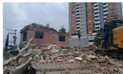
FOTO 61. Demolición de predio ID 09
