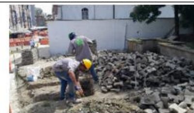
FOTO 45. Construcción de jardineras en predio San Antonio 2, atrio parroquia NSC
