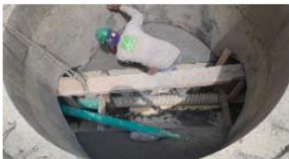
FOTO 32. Construcción de MH's para reposición de la red de aguas lluvias calle 57 sur
