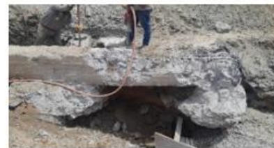
FOTO 64. Demolición de estructura en concreto de cimientos enterrados predios ID 21-19 costado oriental
