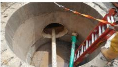
FOTO 31. Construcción de MH's para reposición de la red de aguas lluvias calle 57 sur
