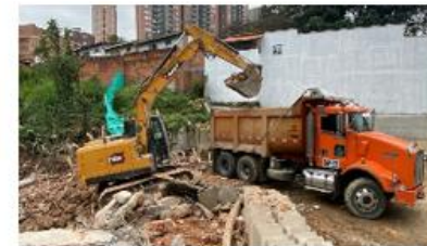
FOTO 62. Demolición de predio ID 09
