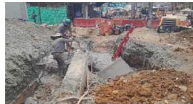
FOTO 63. Demolición de estructura en concreto de cimientos enterrados predios ID 21-19 costado oriental
