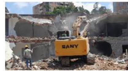
FOTO 36. Demolición mecánica de predio ID 9
