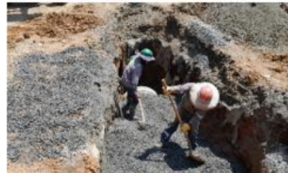
FOTO 40. Instalación de tubería de red aguas lluvias P35-34
