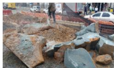
FOTO 65. Demolición de roca predios ID 21-19 costado oriental
