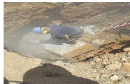
FOTO 38. Demolición y excavación de roca
