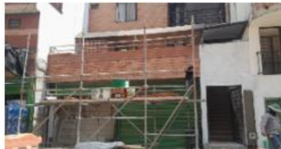
FOTO 44. Reconstrucción de fachada ID 24
