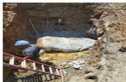
FOTO 37. Demolición y excavación de roca
