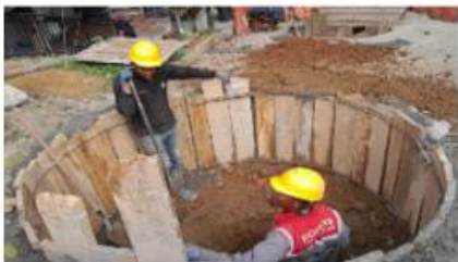
FOTO 29. Excavación de fosos para reposición de la red de aguas lluvias calle 57 sur
