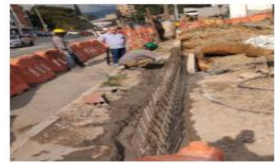
FOTO 66. Construcción muro de contención separador central entre predio ID 21 y el ID 10
