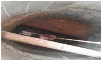
FOTO 30. Excavación de fosos para reposición de la red de aguas lluvias calle 57 sur
