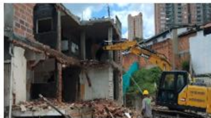
FOTO 35. Demolición mecánica de predio ID 9
