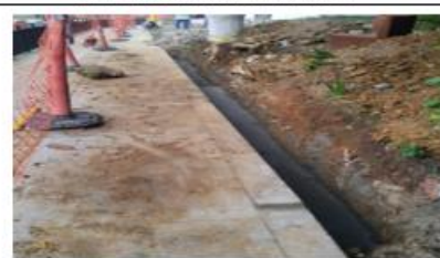
FOTO 46. Construcción de jardineras en predio San Antonio 2, atrio parroquia NSC
