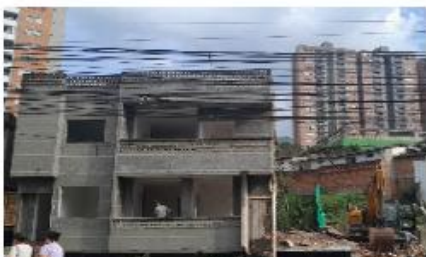
FOTO 34. Demolición mecánica de predio ID 9
