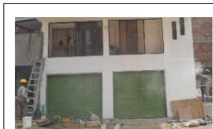
FOTO 41. Reconstrucción de fachada ID 22
