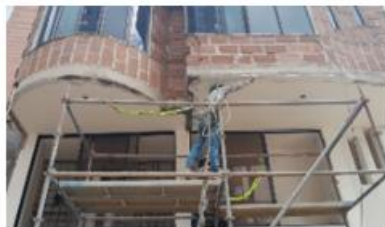
FOTO 42. Reconstrucción de fachada ID 22
