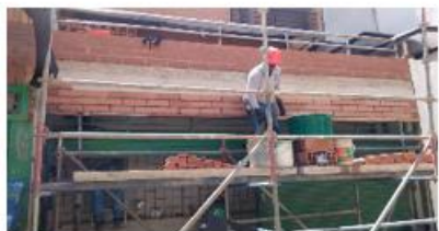
FOTO 43. Reconstrucción de fachada ID 24
