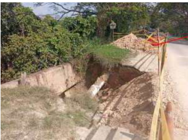
Vista técnica con Aqualia al PR 23+0070
