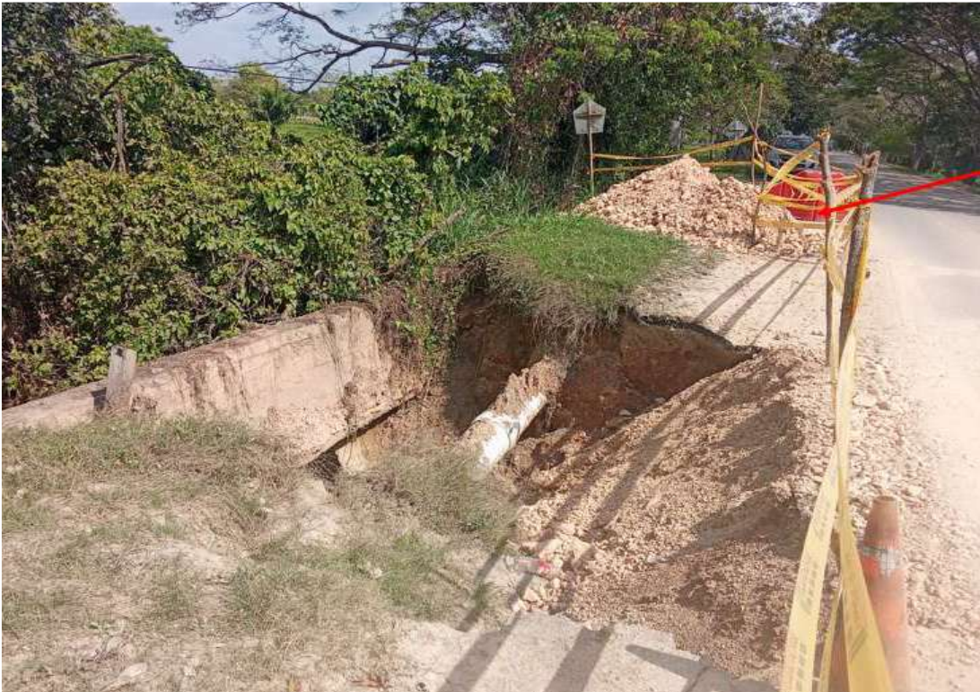
Vista técnica con Aqualia al PR 23+0070
