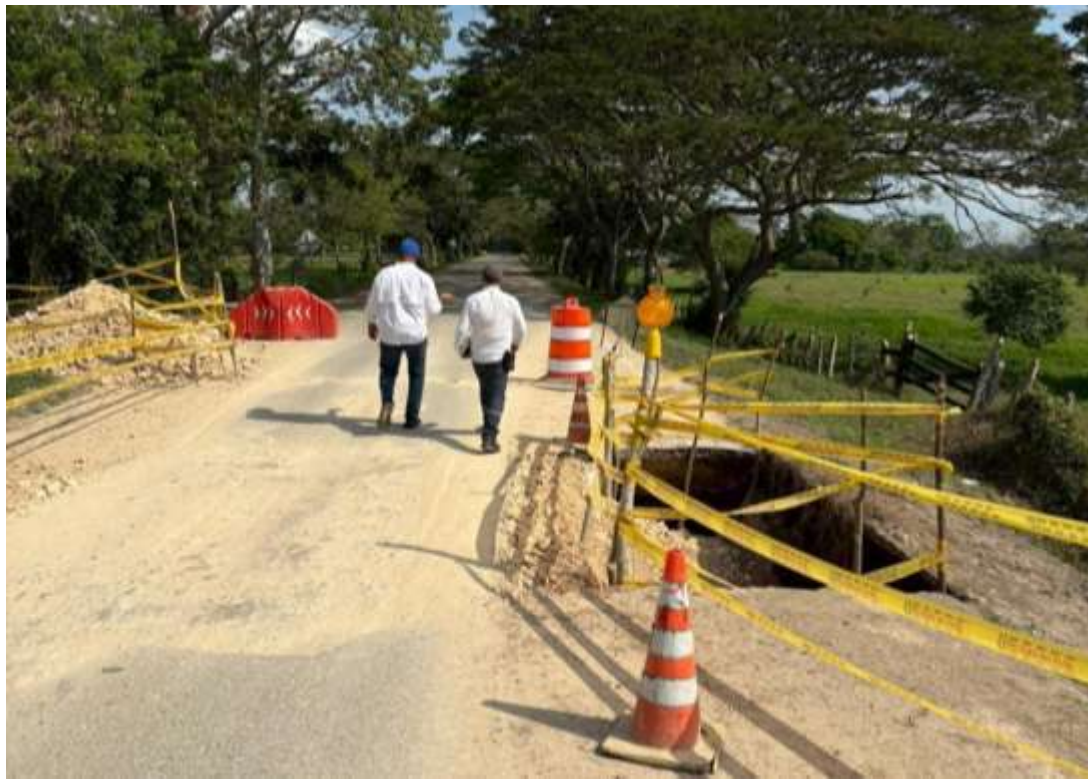
Vista técnica con Aqualia al PR 23+0070
