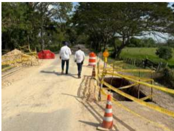
Vista técnica con Aqualia al PR 23+0070
