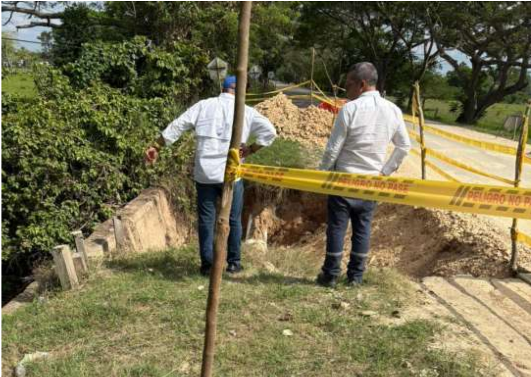
Vista técnica con Aqualia al PR 23+0070
