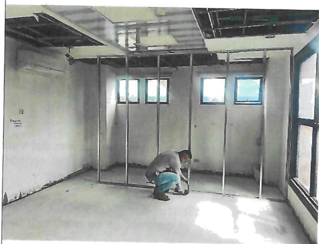
Instalación de Estructuras
