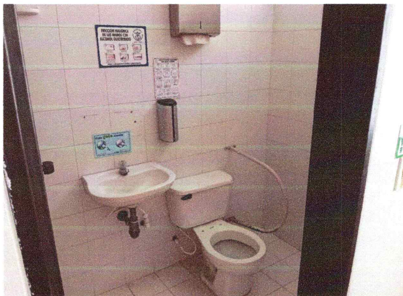
Ilustración 16 Desmonte aparatos sanitarios
