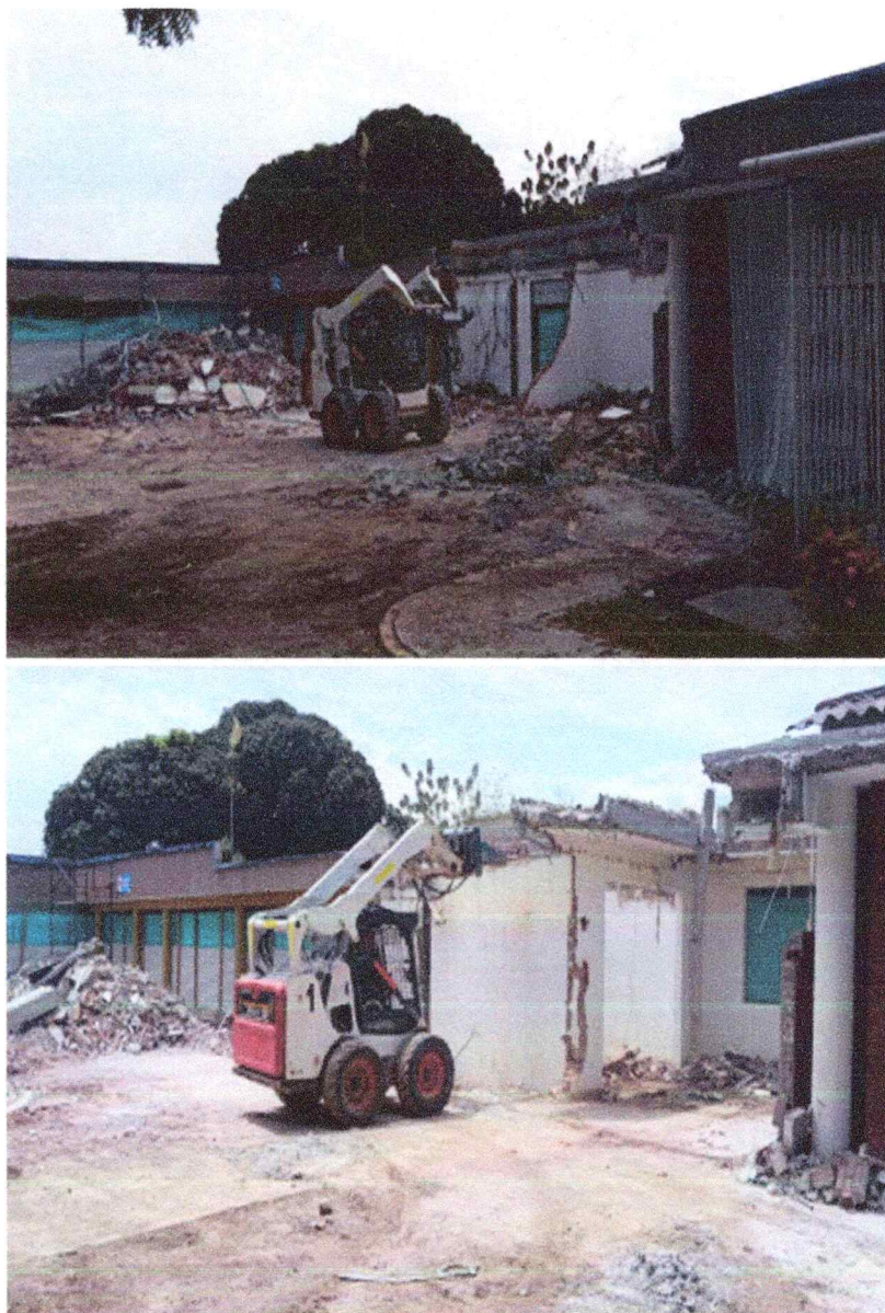
Ilustración 13 Demolición Vigas y columnas
