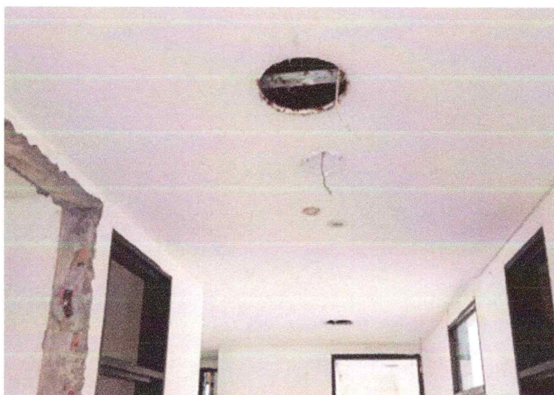
Ilustración 7 Retiro de luminarias fluorescentes
