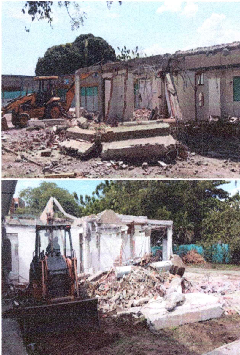
Ilustración 12 Demolición muros existente área urgencias
