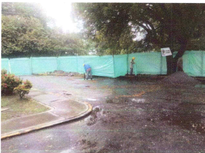
Ilustración 4 Cerramiento provisional en tela verde h= 2.10 mts
