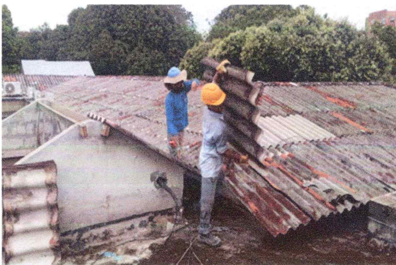
Ilustración 10 Desmonte de cubiertas (Asbesto cemento)
