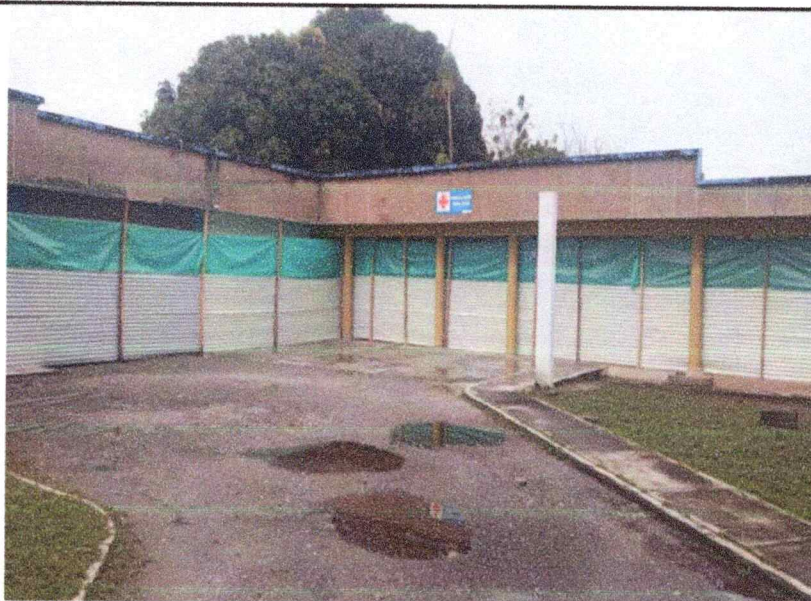
Ilustración 5 Cerramiento con lamina h= 2.00 mts
