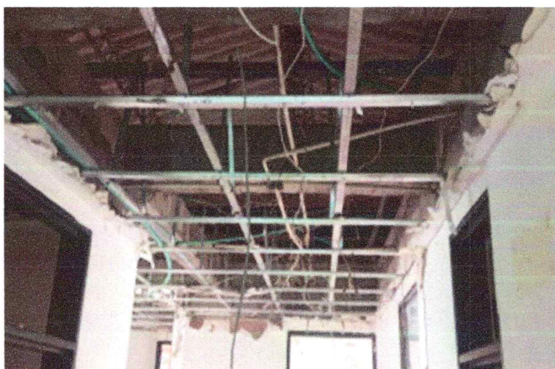
Ilustración 8 Retiro redes electricas existentes
