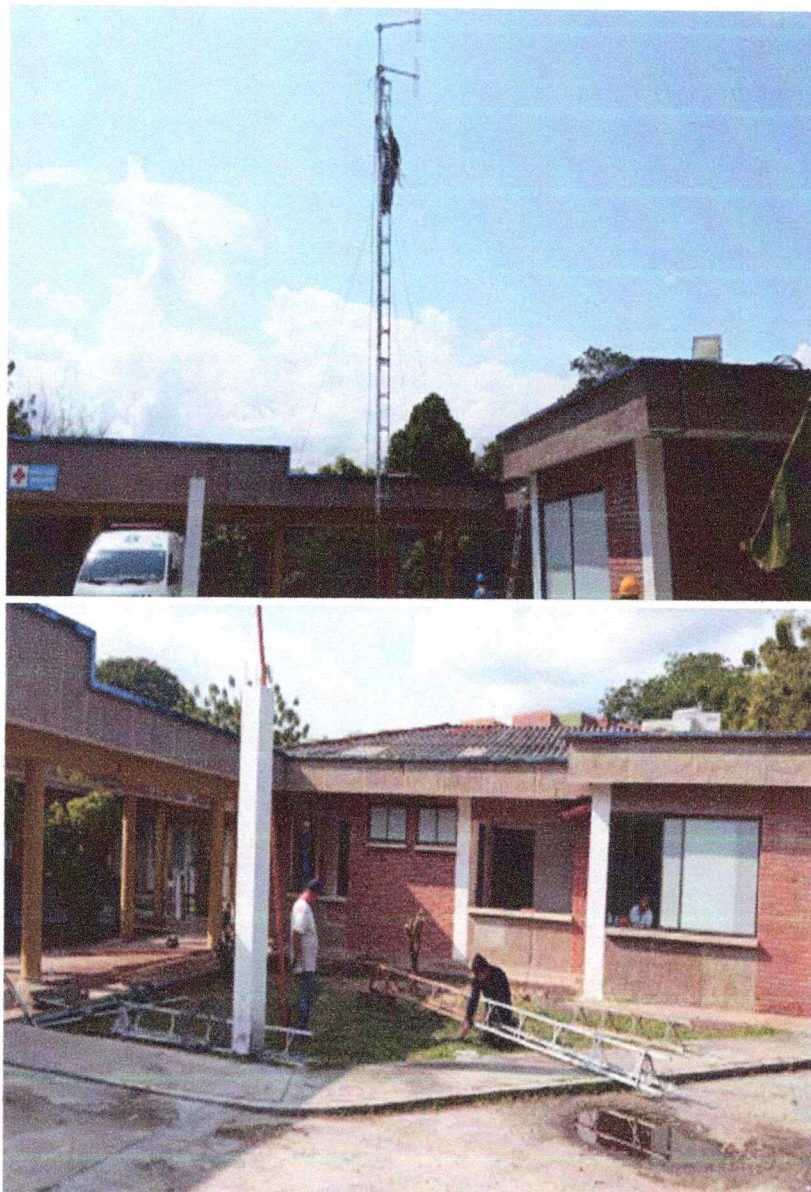
Ilustración 17 Desmonte de Antena
