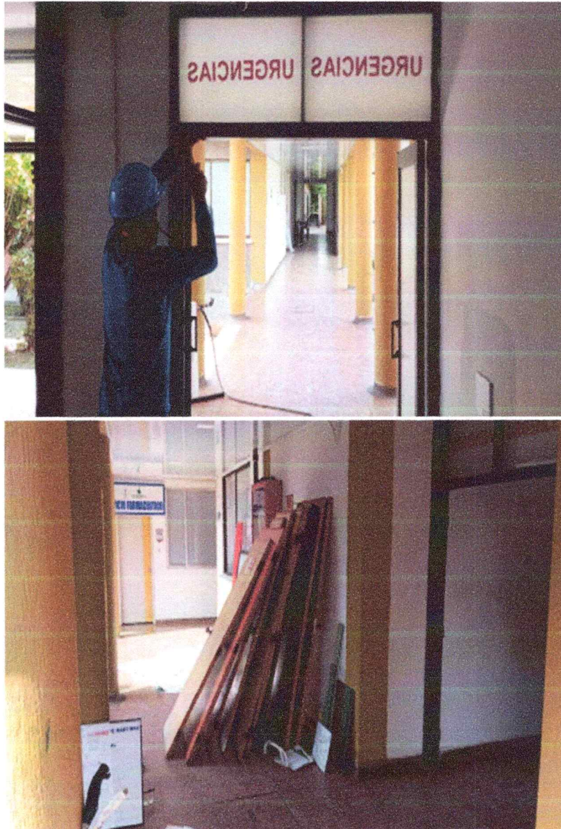
Ilustración 14 Desmonte marco y puertas
