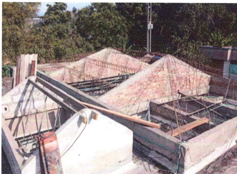
Ilustración 6 Desmonte de entramado de madera para estructura cubierta existente
