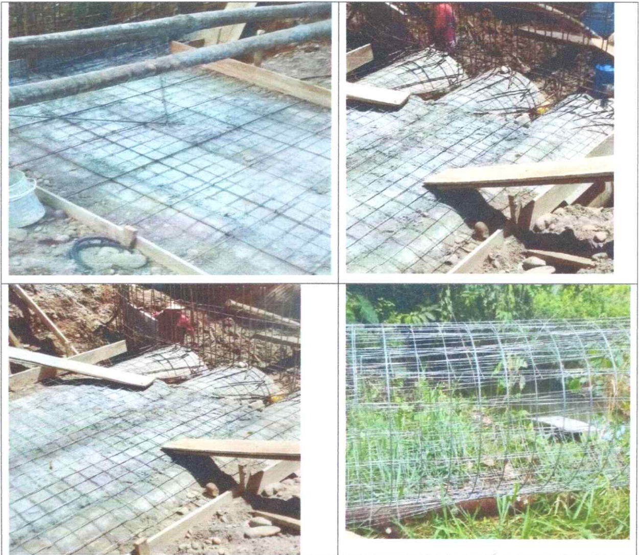
Imagen 8. MALLA ELECTROSOLDADA 5 MM
