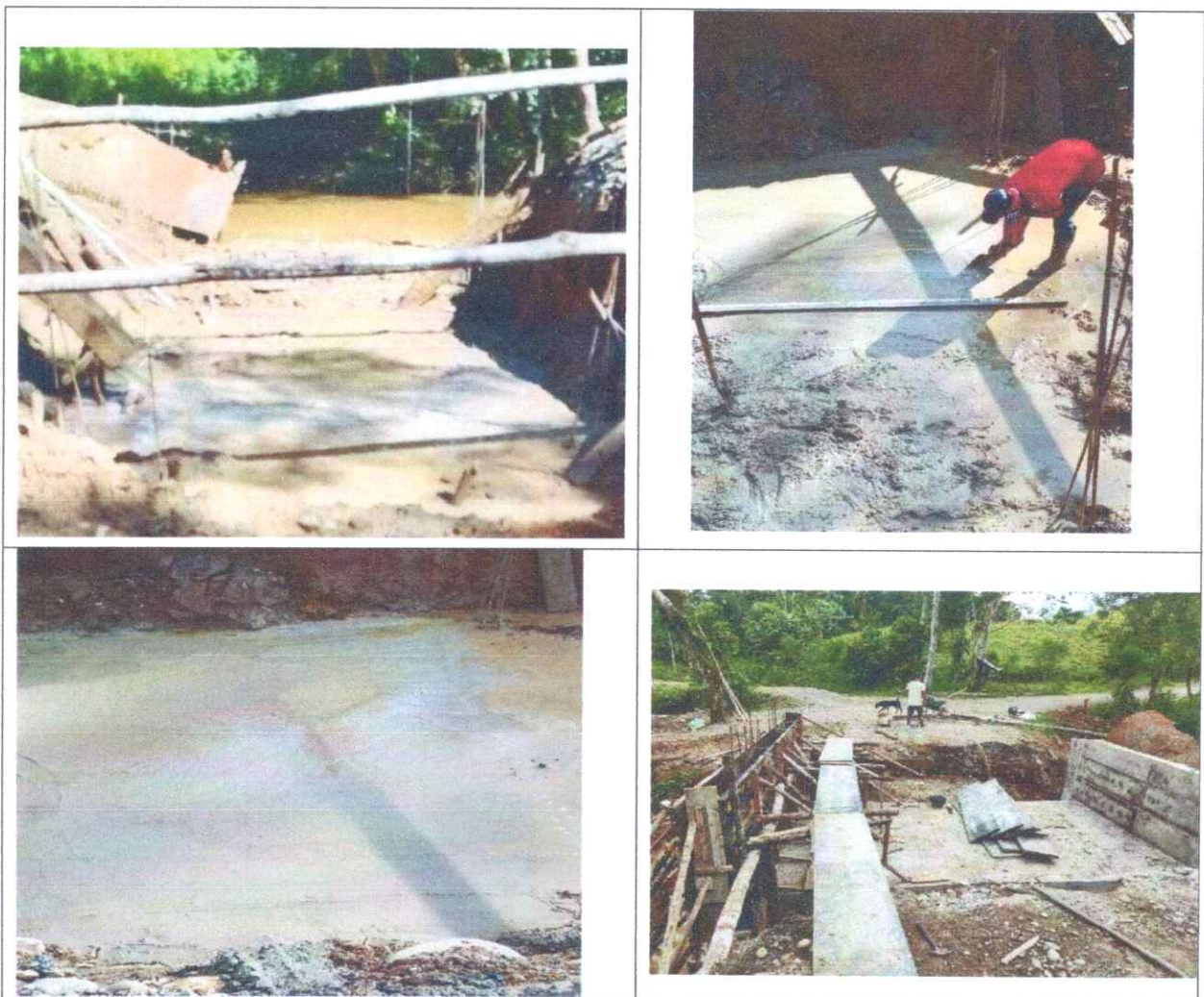
Imagen 3. PLACA CONCRETO 2000 PSI
