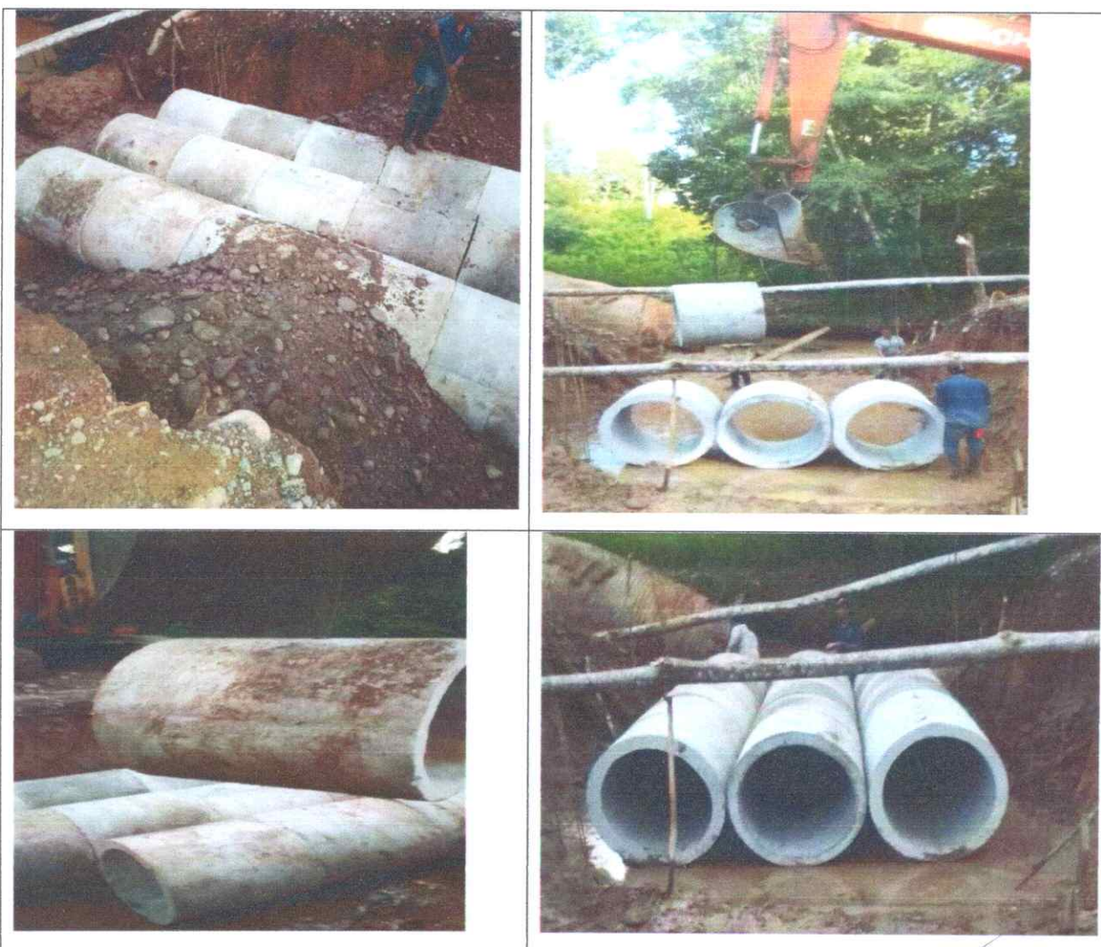
Imagen 4. INSTALACION DE TUBERIA DE CONCRETO REFORZADO
