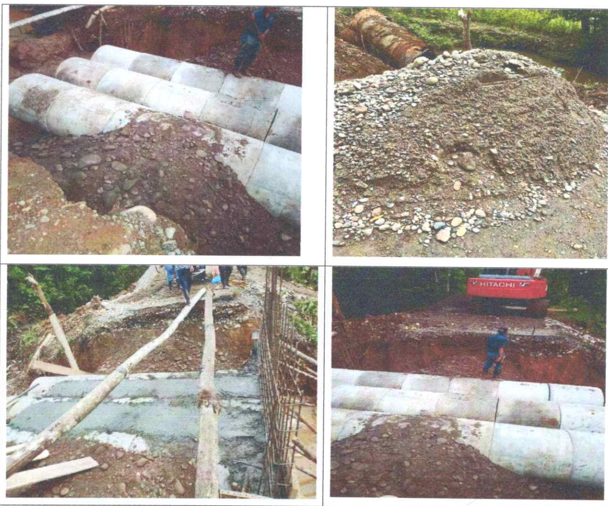
Imagen 9. RELLENOS CON SUBBASE GRANULAR
