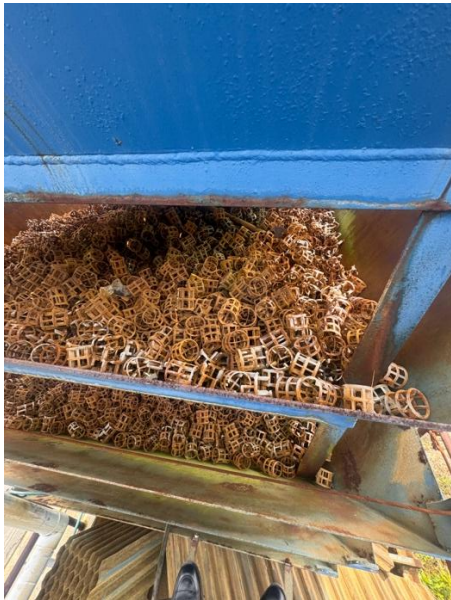
FOTOGRAFIA : Anillos Pall Ring para aumento de velocidad de precipitación de hierro en las bandejas de aireación.
