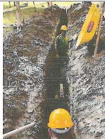
Fotografía 18. Instalacion de tubería sanitaria de 4" PVC.
