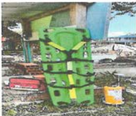
Fotografía 1. Elementos para socorrer emergencias (obra)
