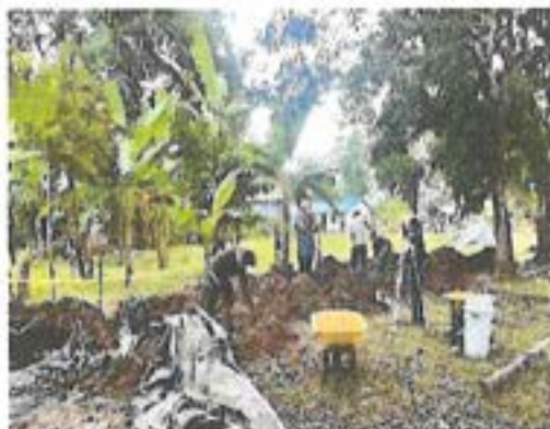
Fotografía 2. Super vision (Trabajos en obra)
