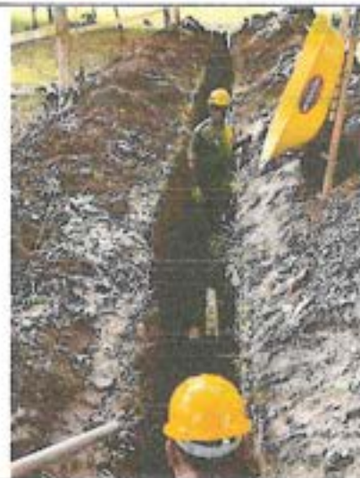
Fotografía 16. Conformación del material granular mixto protector de la red sanitario conformada en tubería PVC de 4".
