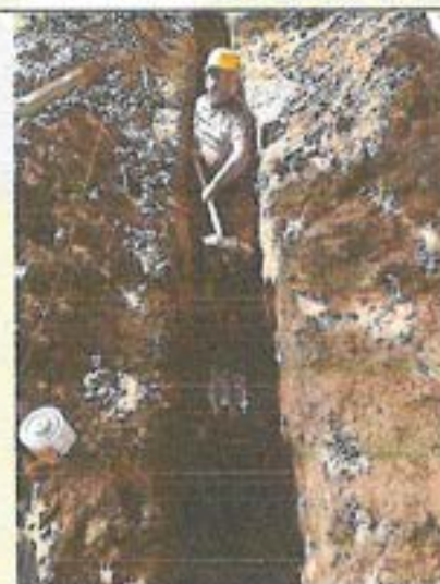
Fotografia 21. Excavaciones de la red principal del sistema sanitario en PVC 4".
