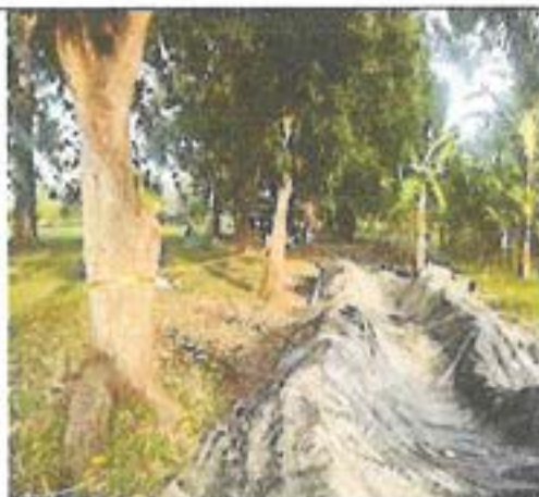
Cubrimiento de material de excavación
