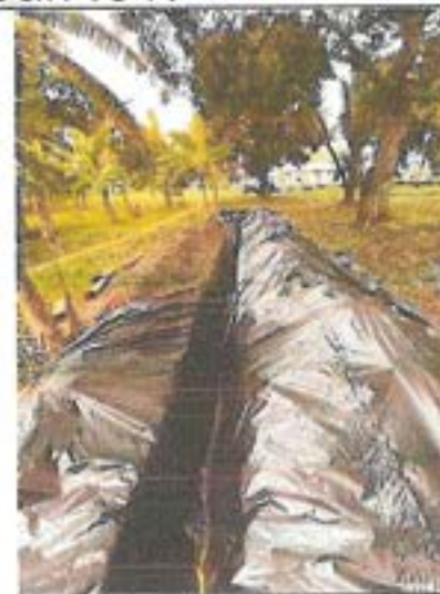
Fotografia 22. Protección con plástico de excavaciones de la red principal del sistema sanitario en PVC 4".
