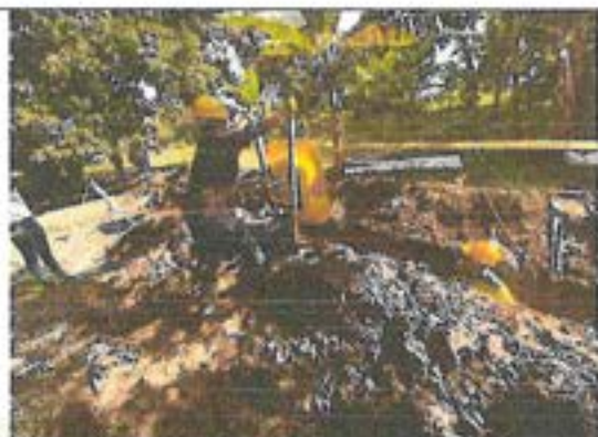
Fotografia 9. Excavaciones de la red principal del sistema sanitario en PVC 4".
