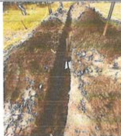
Fotografia 22. Protección con plástico de excavaciones de la red principal del sistema sanitario en PVC 4".
