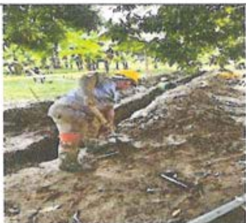
Cubrimiento de excavación
