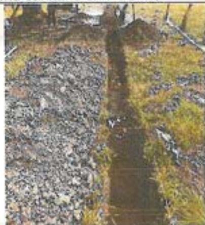
Fotografia 21. Excavaciones de la red principal del sistema sanitario en PVC 4".
