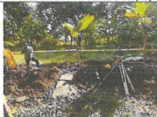
Fotografia 14. Conformacion del material granular mixto protector de la red sanitario conformada en tuberia PVC de 4".
