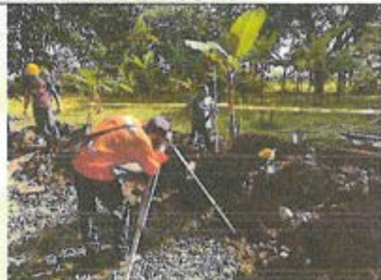
Fotografia 13. Instalacion de material granular para la nivelacion de la tuberia sanitario de 4" PVC perteneciente al sistema hidrosanitario del proyecto.
