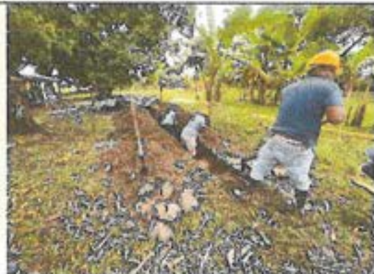
Fotografia 11. Toma de niveles é instalacion del sistema sanitario en PVC 4".
