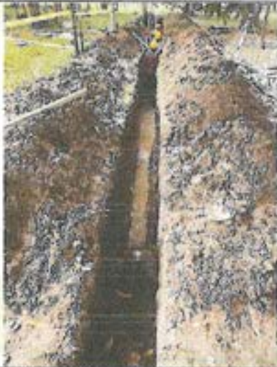
Fotografía 17. Instalacion de tubería sanitaria de 4" PVC.
