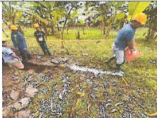
Fotografía 4. Localizacion y replanteo de la red sanitaria principal de 4" PVC en zona humedas frente a quiosco.
