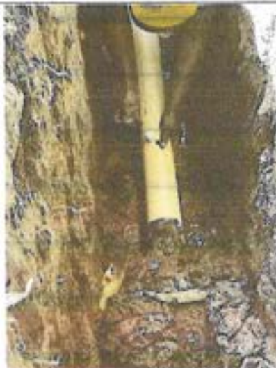
Fotografia 20. Excavaciones de la red principal del sistema sanitario en PVC 4".
