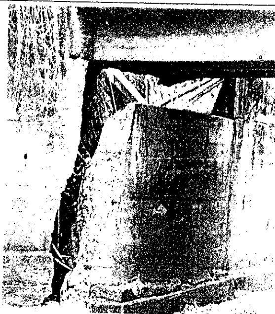
Ilustración 1 y 2 Socavación y Colapso de Puente vía San Marcos
