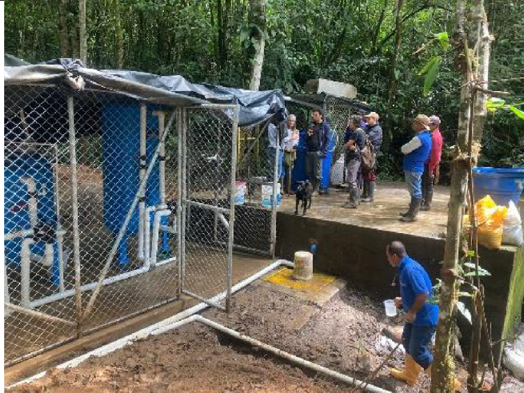
Ilustración 1 Infraestructura construida 2022 - Fuente UAESP
