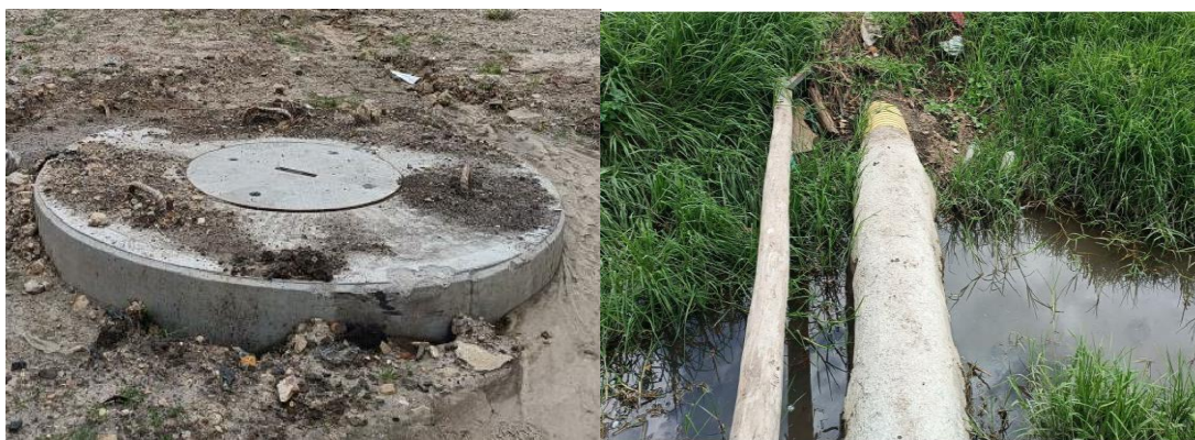
Ilustración 22. Registro fotográfico Tramo 5 (P112-P121)
