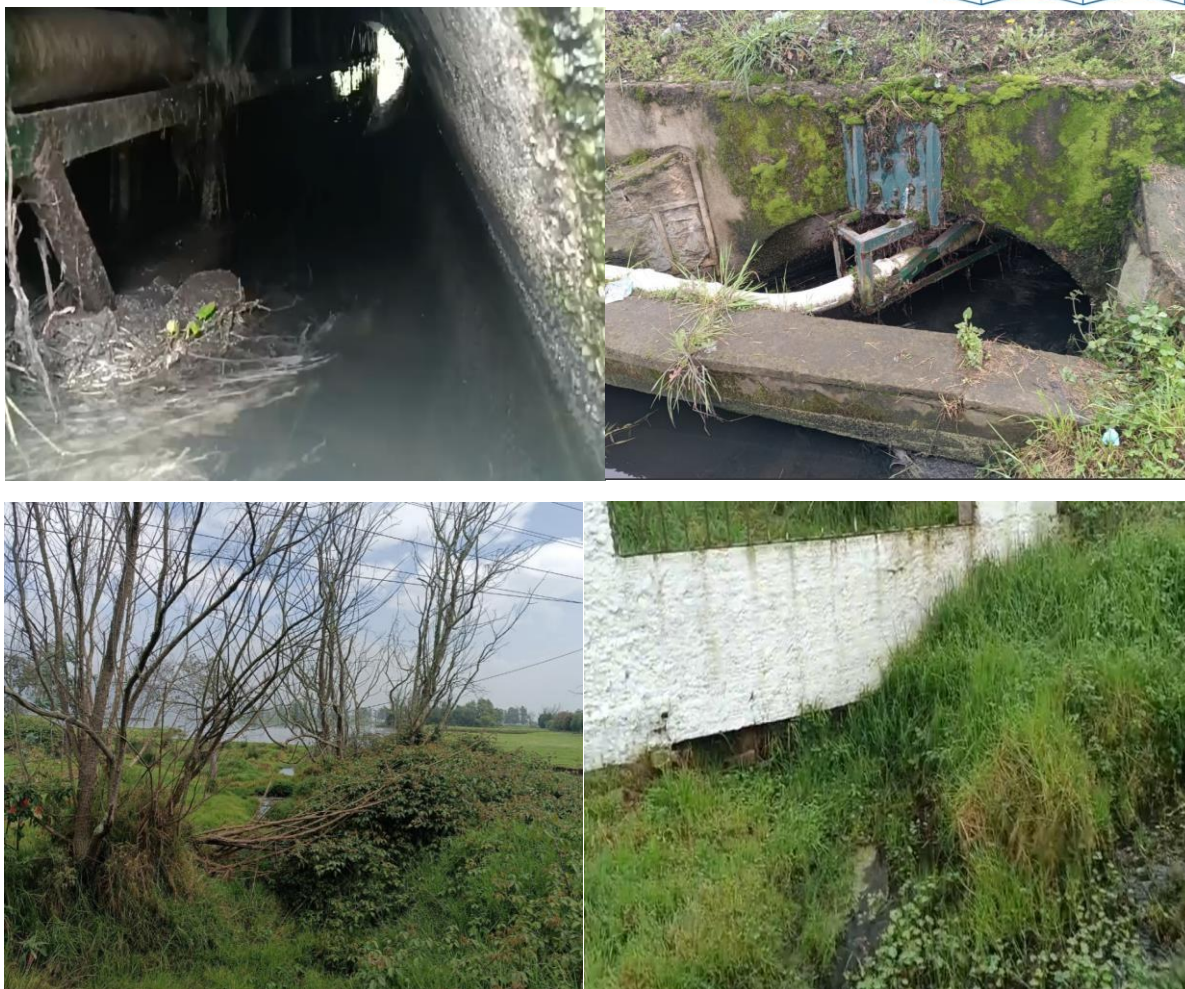
Ilustración 26. Registro fotográfico de la descarga actual de las aguas residuales hasta el embalse El Muña
