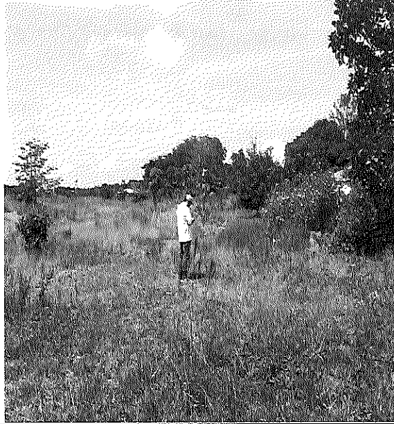
Localización y replanteo
