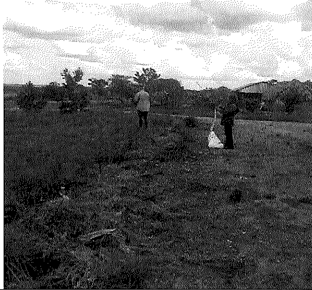
Localización y replanteo
