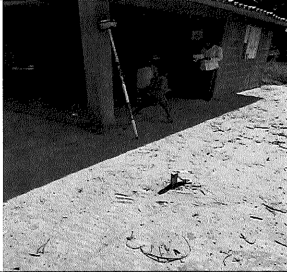
Localización y replanteo
