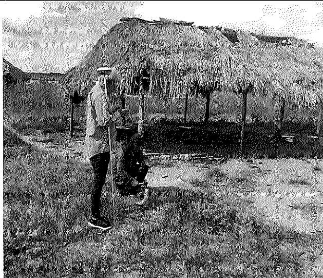
Localización y replanteo
