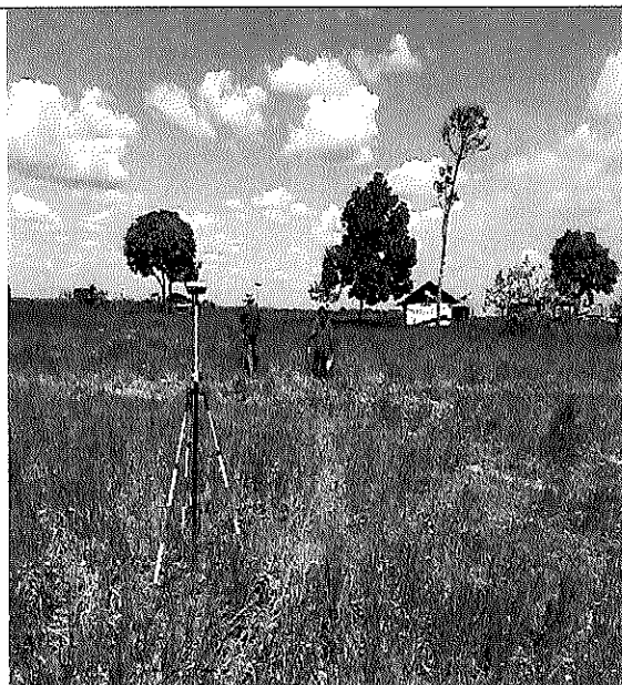
Localización y replanteo
