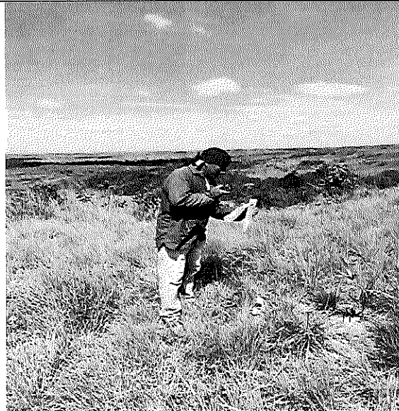
Localización y replanteo
