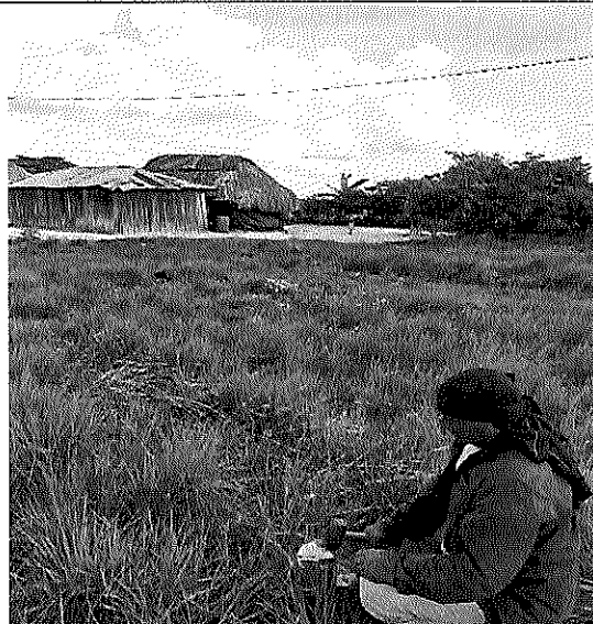
Localización y replanteo
