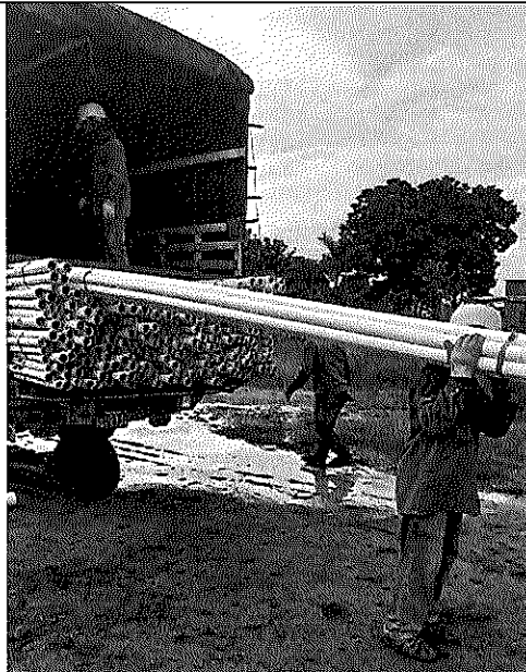
Suministro tubería pvcp
