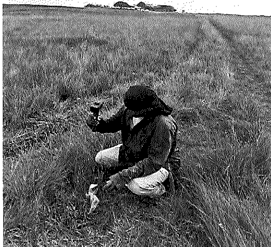
Localización y replanteo
