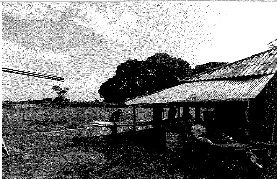
Suministro tubería pvc
