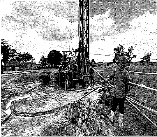
Construcción piscina de lodos
