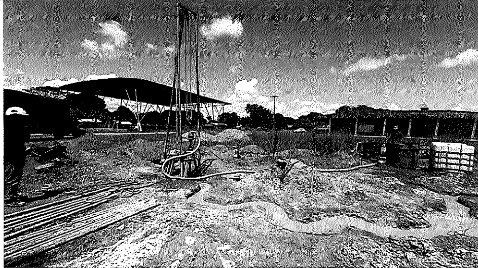
Ampliación de perforación
