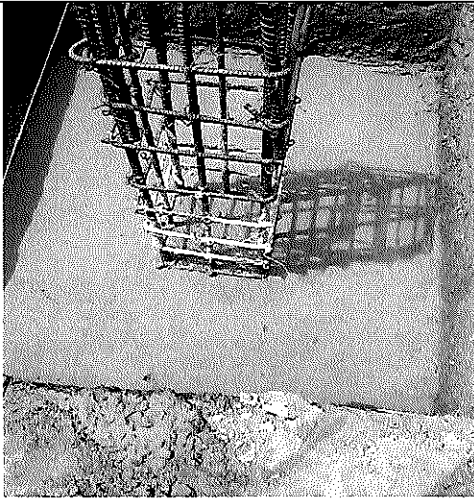
Zapata en concreto
