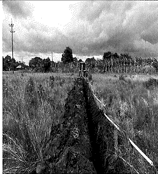
Relleno proveniente de la excavación
