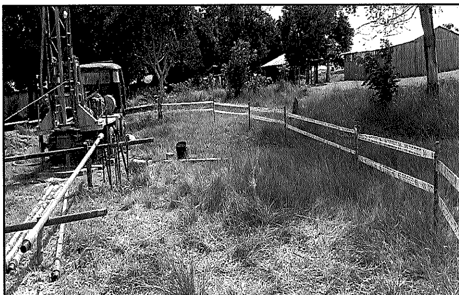
Imagen 5 Cerramiento y señalización
