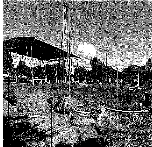
perforación de prueba
