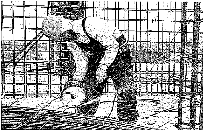
USO DE PROTECCIÓN VISUAL PARA EL CORTE DE ACERO
